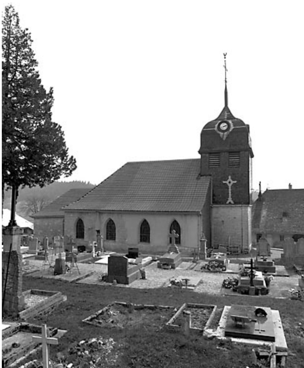
Vue de la façade latérale nord.
