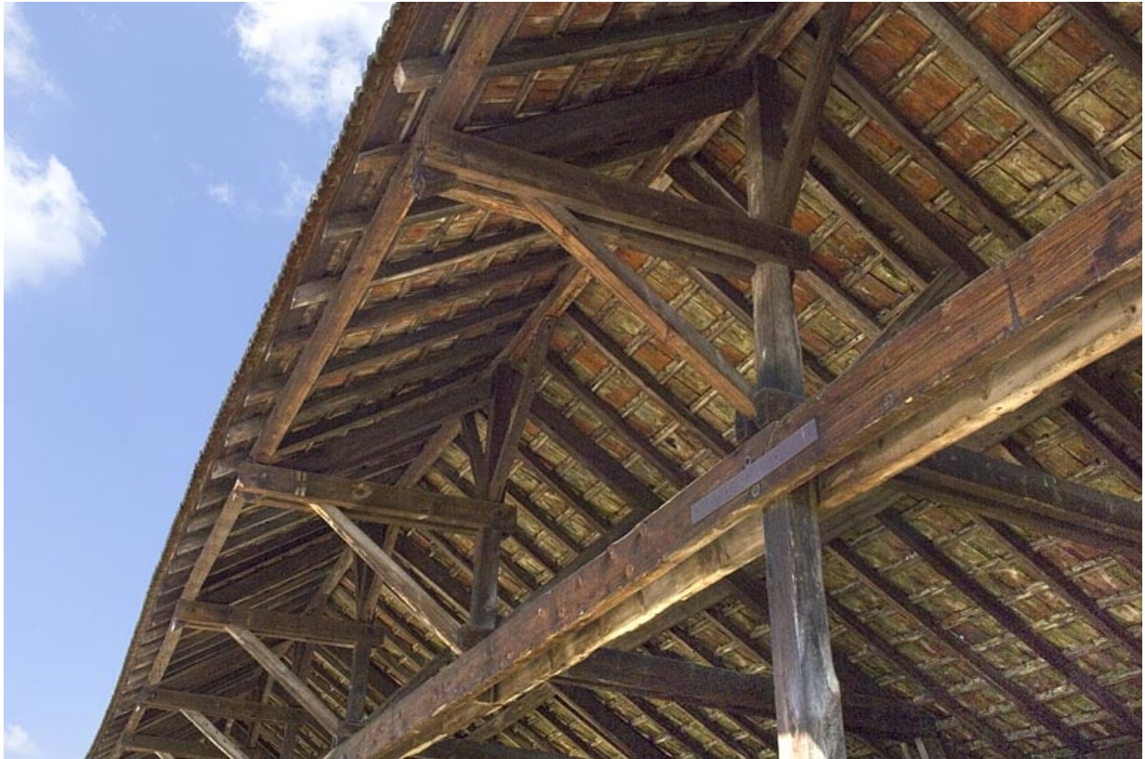
Entrepôt industriel ouest. Détail de la charpente.
