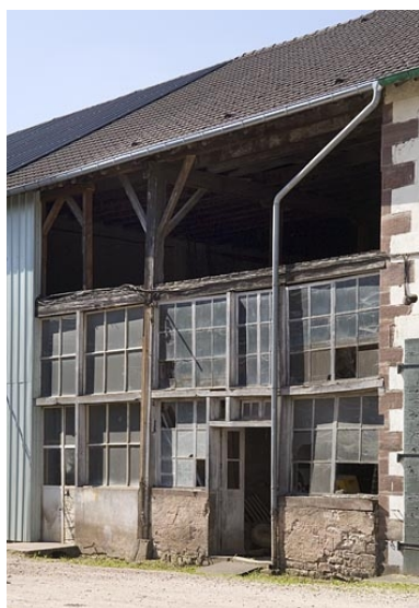
Bâtiment ouest. Elévation d'une façade. Phot. Jérôme Mongreville IVR43_20097000414NUC2A
