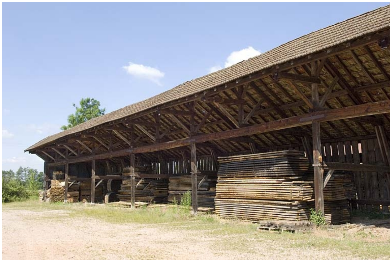
Entrepôt industriel ouest. Vue de trois quarts.
