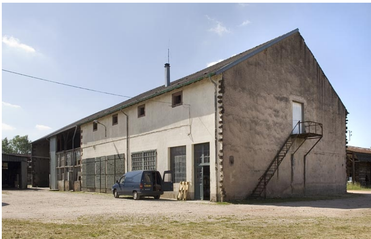
Bâtiment ouest. Remises et écuries (?).
