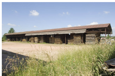
Entrepôt industriel ouest. Vue d'ensemble. Phot. Jérôme Mongreville IVR43_20097000417NUC2A
