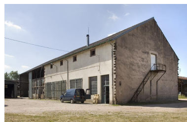
Bâtiment ouest. Remises et écuries (?). Phot. Jérôme Mongreville IVR43_20097000421NUC2A
