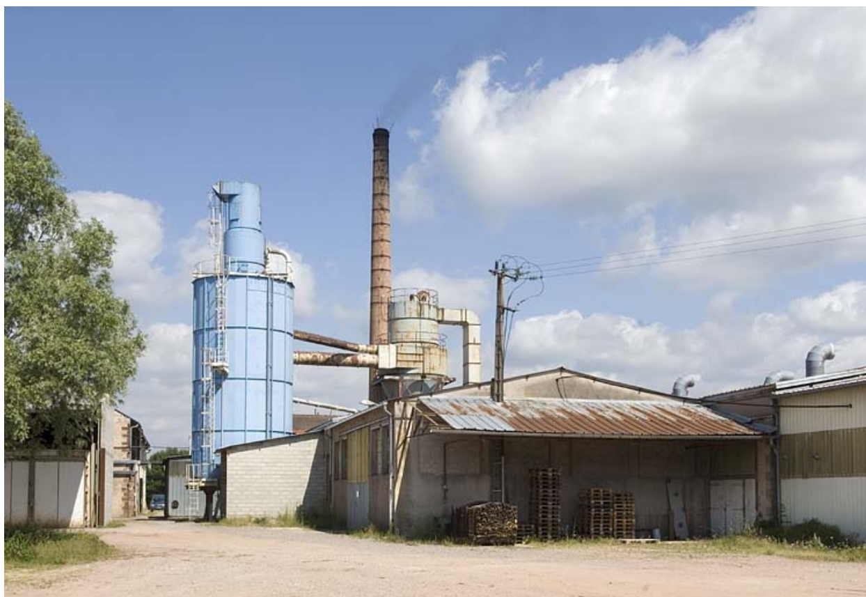
Silo et cheminée. Vue d'ensemble.
