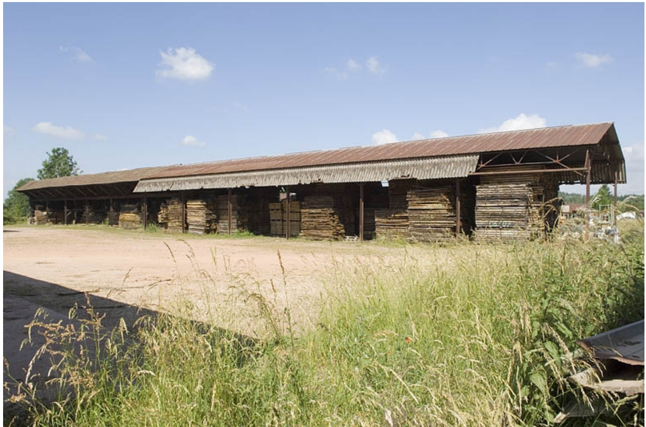
Entrepôt industriel ouest. Vue d'ensemble.
