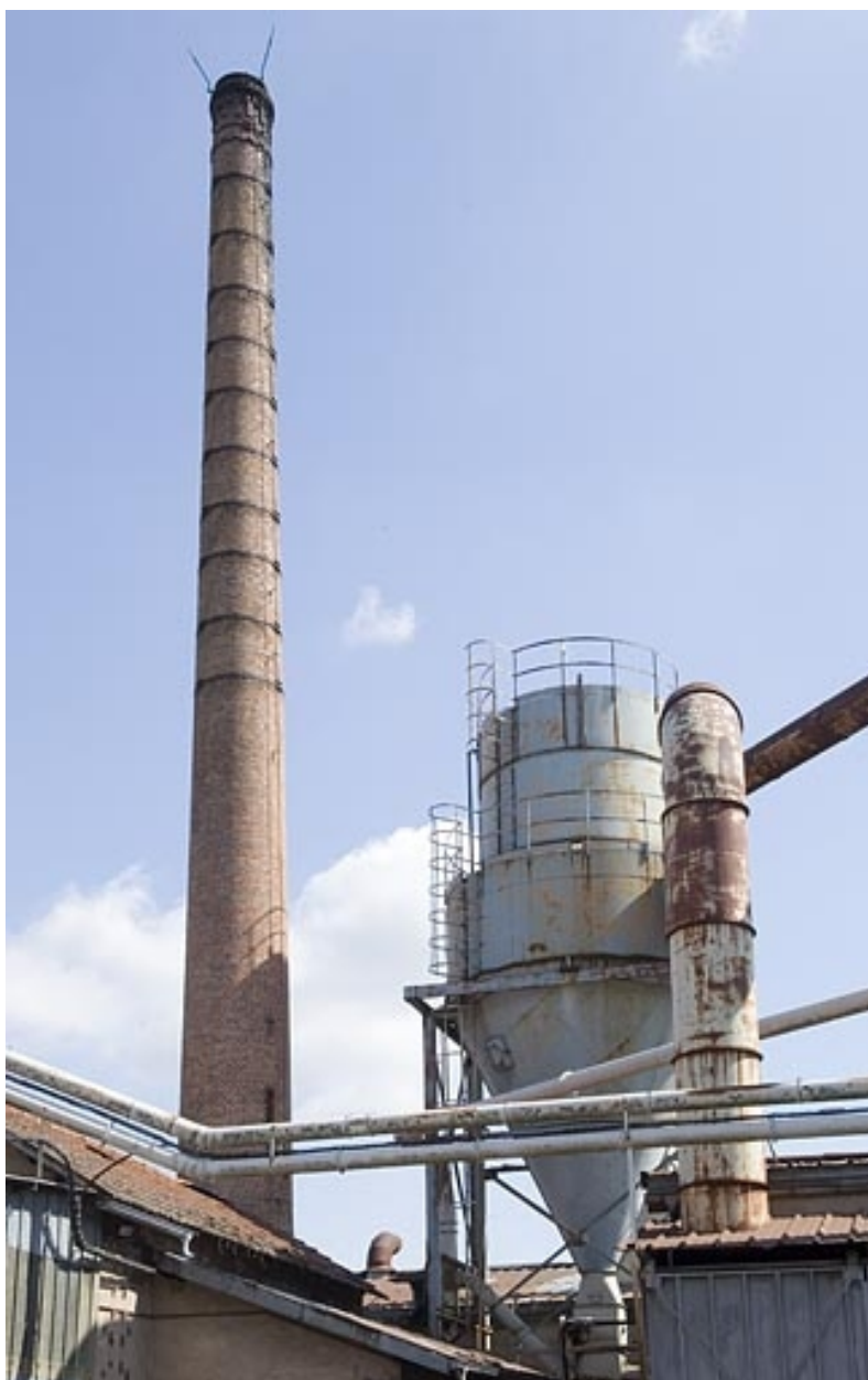
Cheminée et silo. Vue rapprochée.
