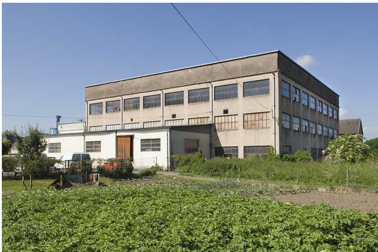
Atelier de fabrication nord.
