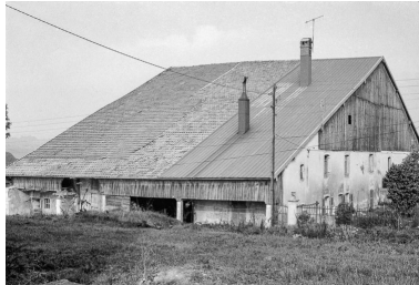
Façades antérieure et latérale gauche sur rue. Phot. Gilbert Poinot IVR43_19752501413Z
