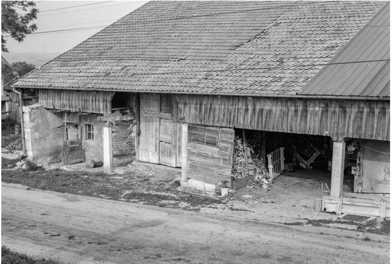
Façade latérale gauche sur rue : partie gauche.
