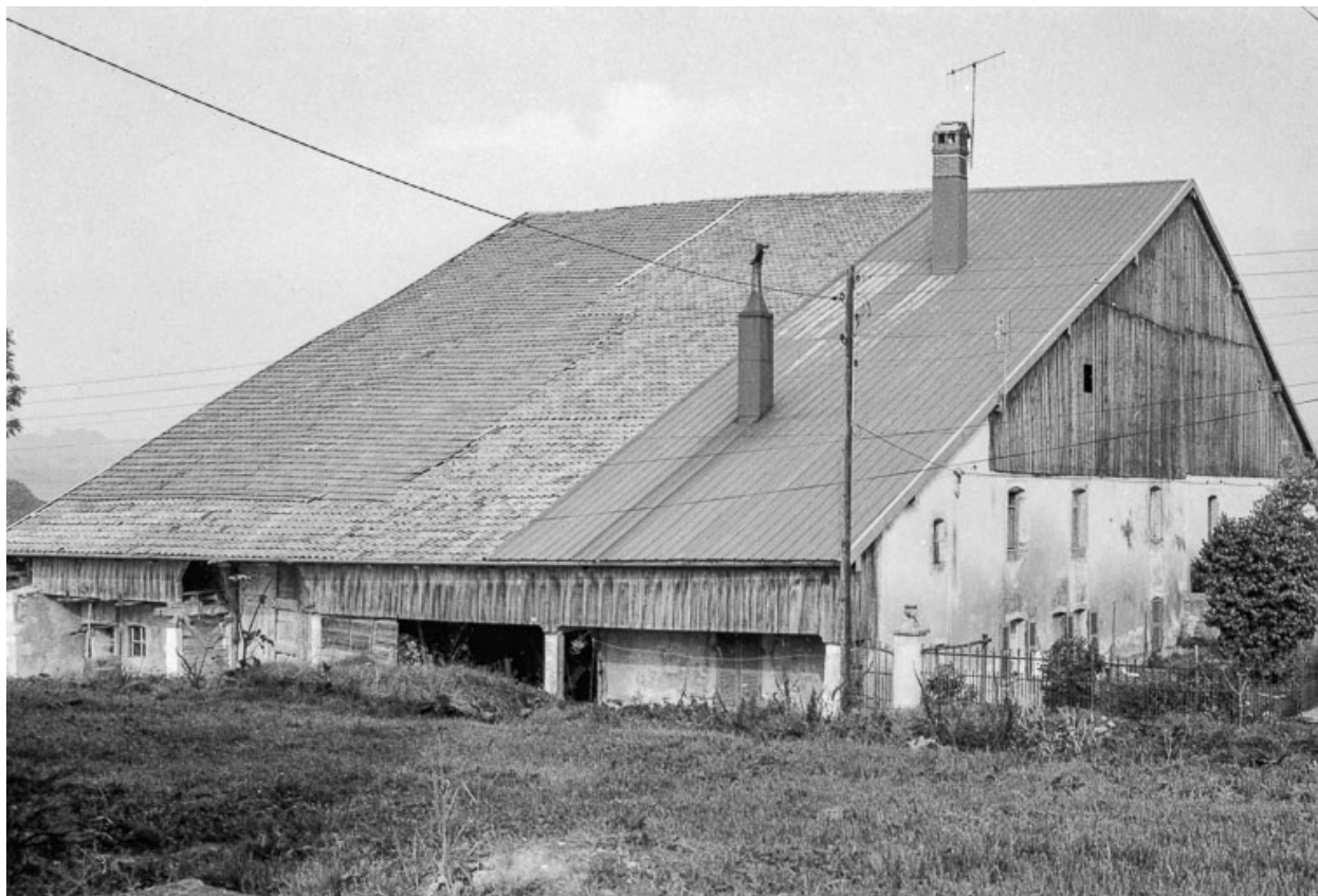
Façades antérieure et latérale gauche sur rue.
