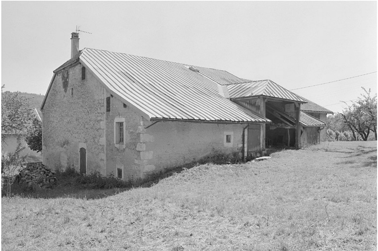
Façade postérieure et face droite.
