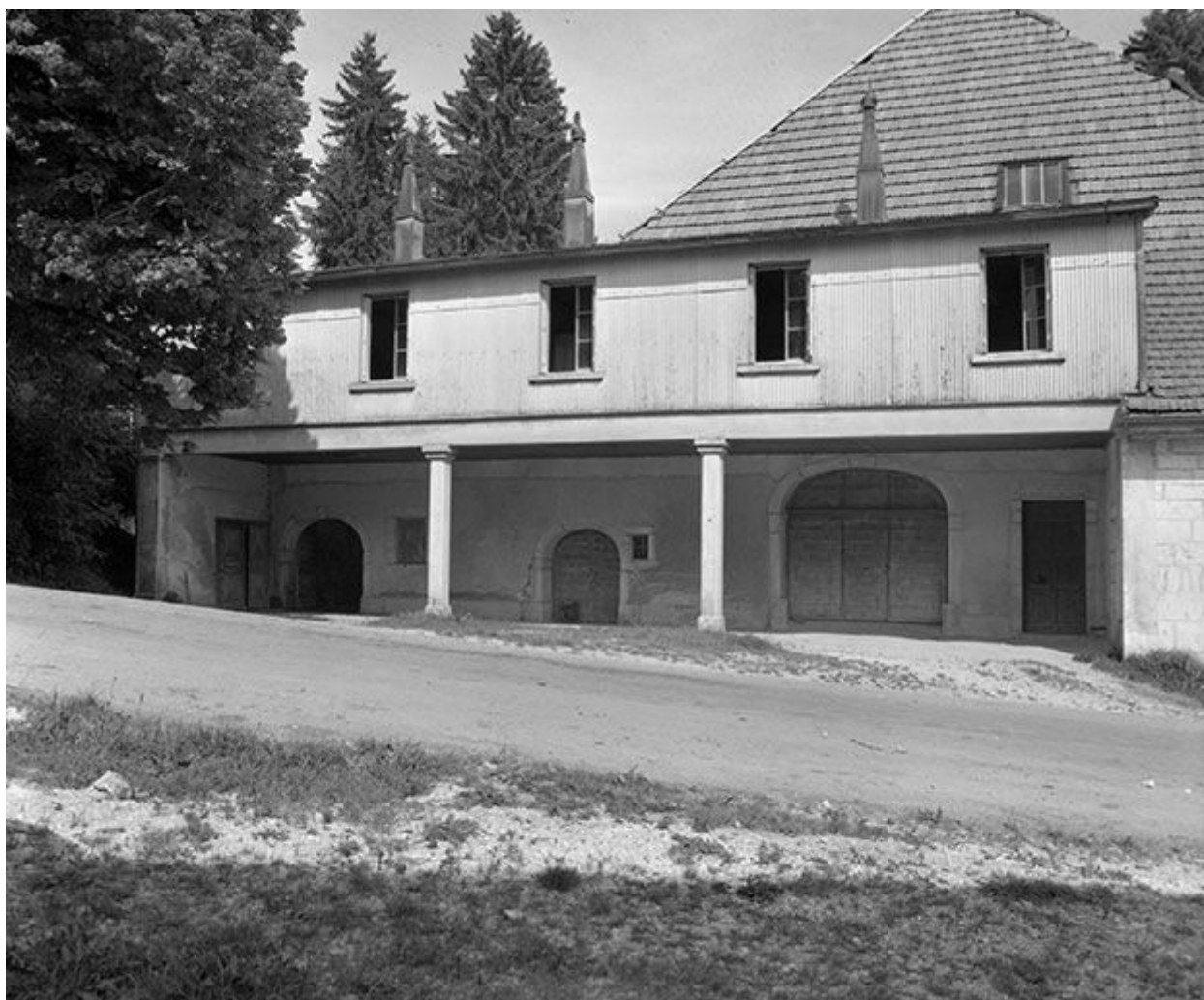
Les portes d'entrées sur le mur de croupe.
