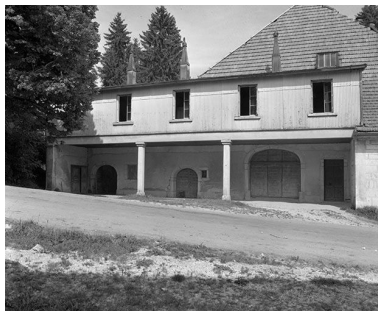
Les portes d'entrées sur le mur de croupe. Phot. Yves Sancey IVR43_19782500522X
