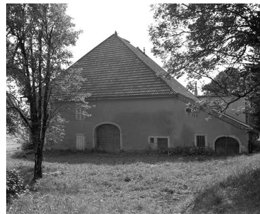
Façade latérale, vue depuis le parc. Phot. Yves Sancey IVR43_19782500523X
