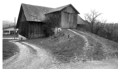
Partie agricole : façade postérieure. Phot. Bernard Lardière IVR43_19829000218Z
