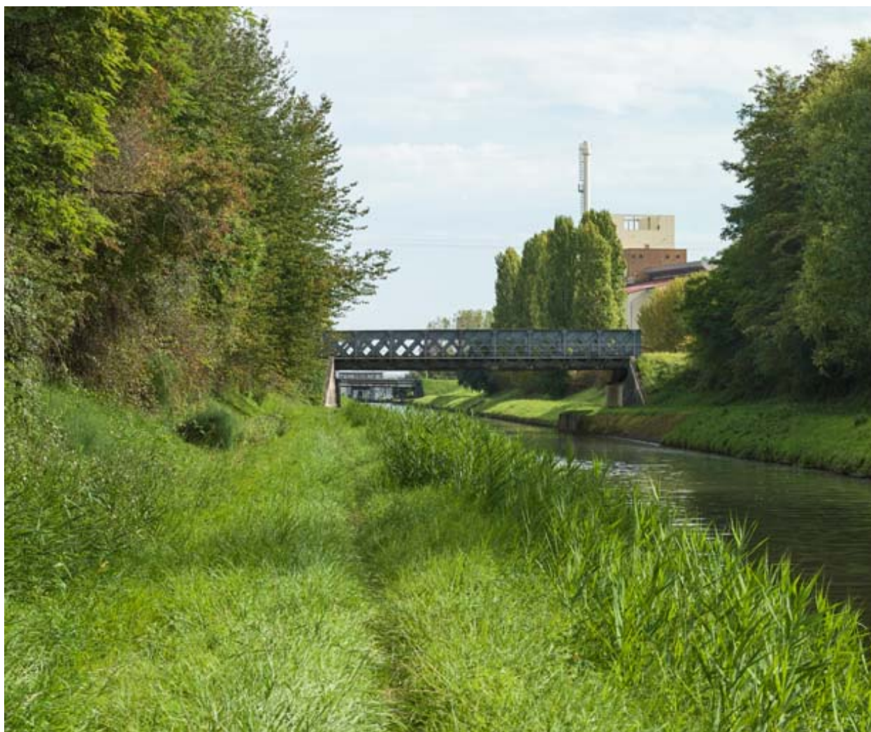
Vue d'ensemble du pont.
