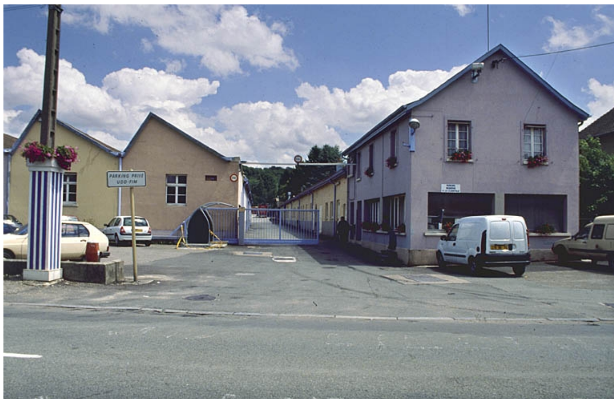
Entrée de l'usine.
