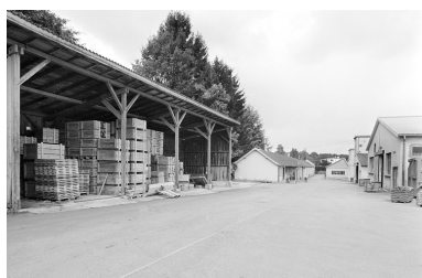
Entrepôt industriel et ateliers divers au sud. Phot. Yves Sancey IVR43_20019000398X
