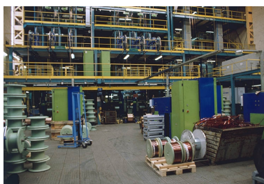
Intérieur de l'atelier d'émaillage. Phot. Yves Sancey IVR43_20019000416ZA
