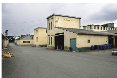
Atelier de fabrication, bureau d'études et transformateur. Phot. Yves Sancey IVR43_20019000394ZA
