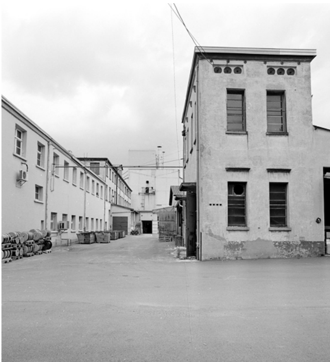
Bureau d'études (à gauche) et transformateur.
