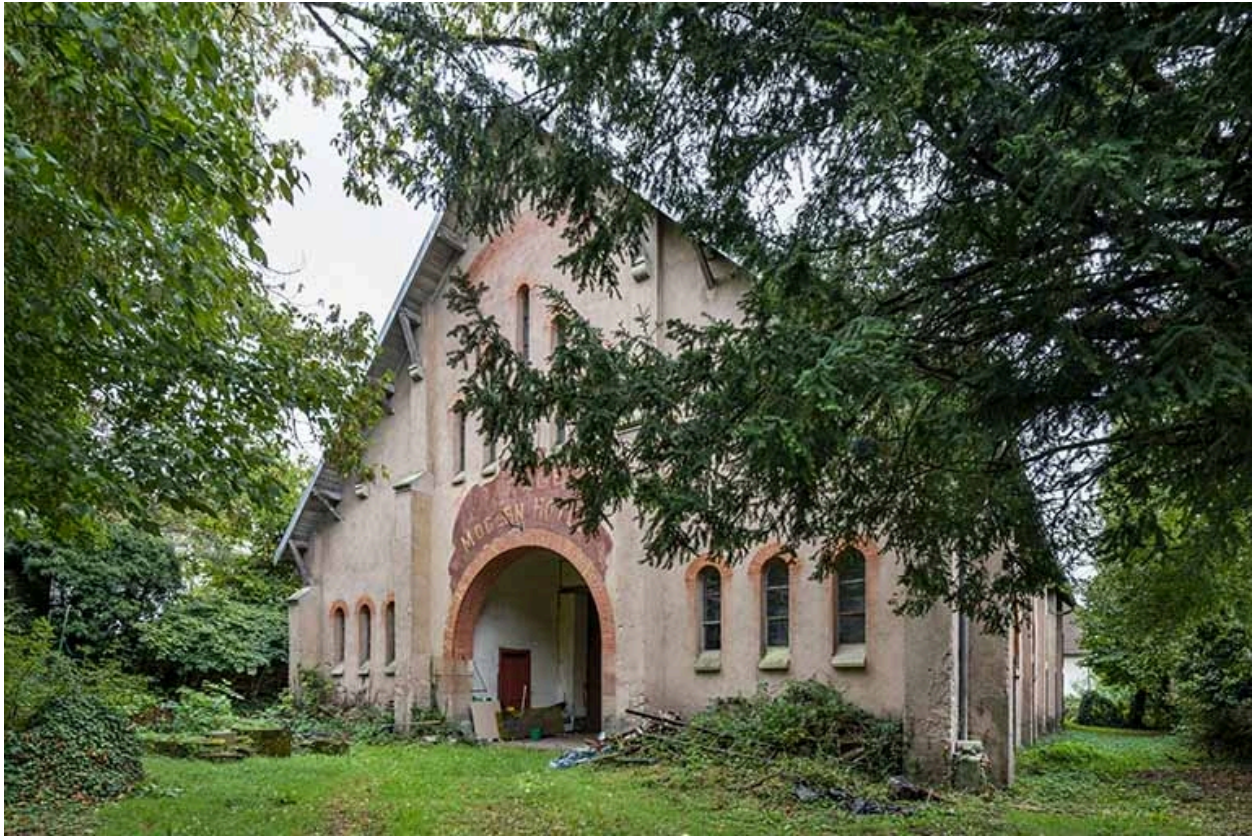
Mur-pignon nord, vue de trois quarts.
