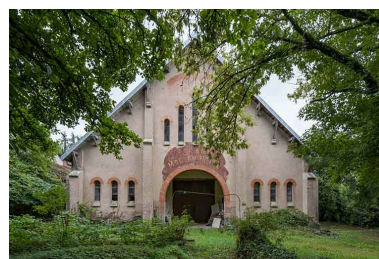
Mur-pignon nord, vue de face. Phot. Jérôme Mongreville IVR43_20207000646NUC4A
