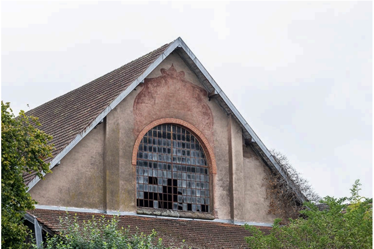
Mur-pignon sud, baie du pignon.
