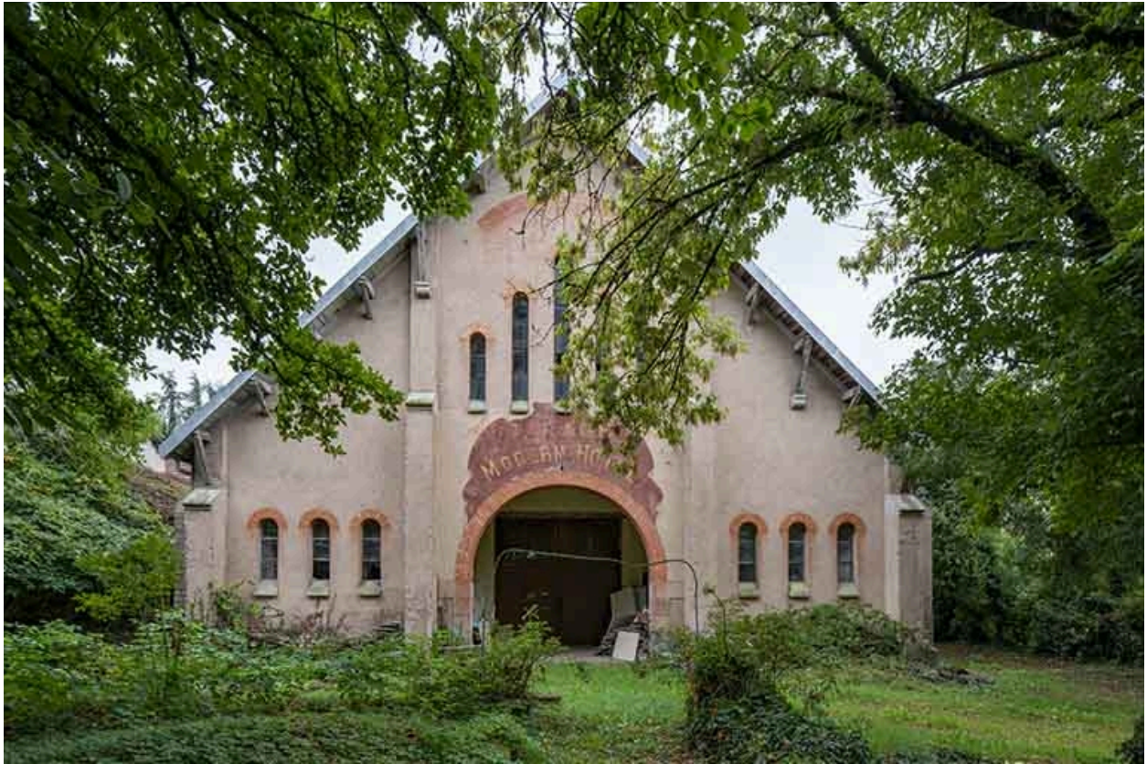
Mur-pignon nord, vue de face.
