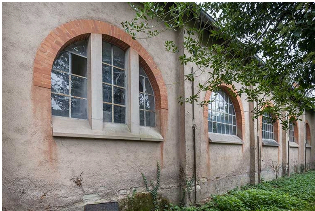
Mur-gouttereau ouest, fenêtre thermique.
