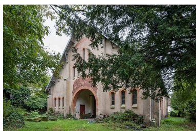
Mur-pignon nord, vue de trois quarts. Phot. Jérôme Mongreville IVR43_20207000647NUC4A
