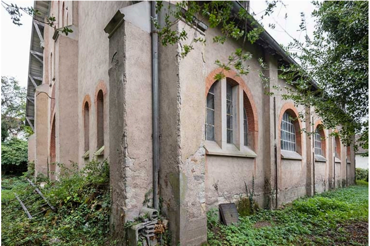
Mur-pignon nord et mur-gouttereau ouest, angle à contreforts.
