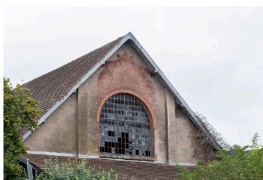
Mur-pignon sud, baie du pignon. Phot. Jérôme Mongreville IVR43_20207000650NUC4A
