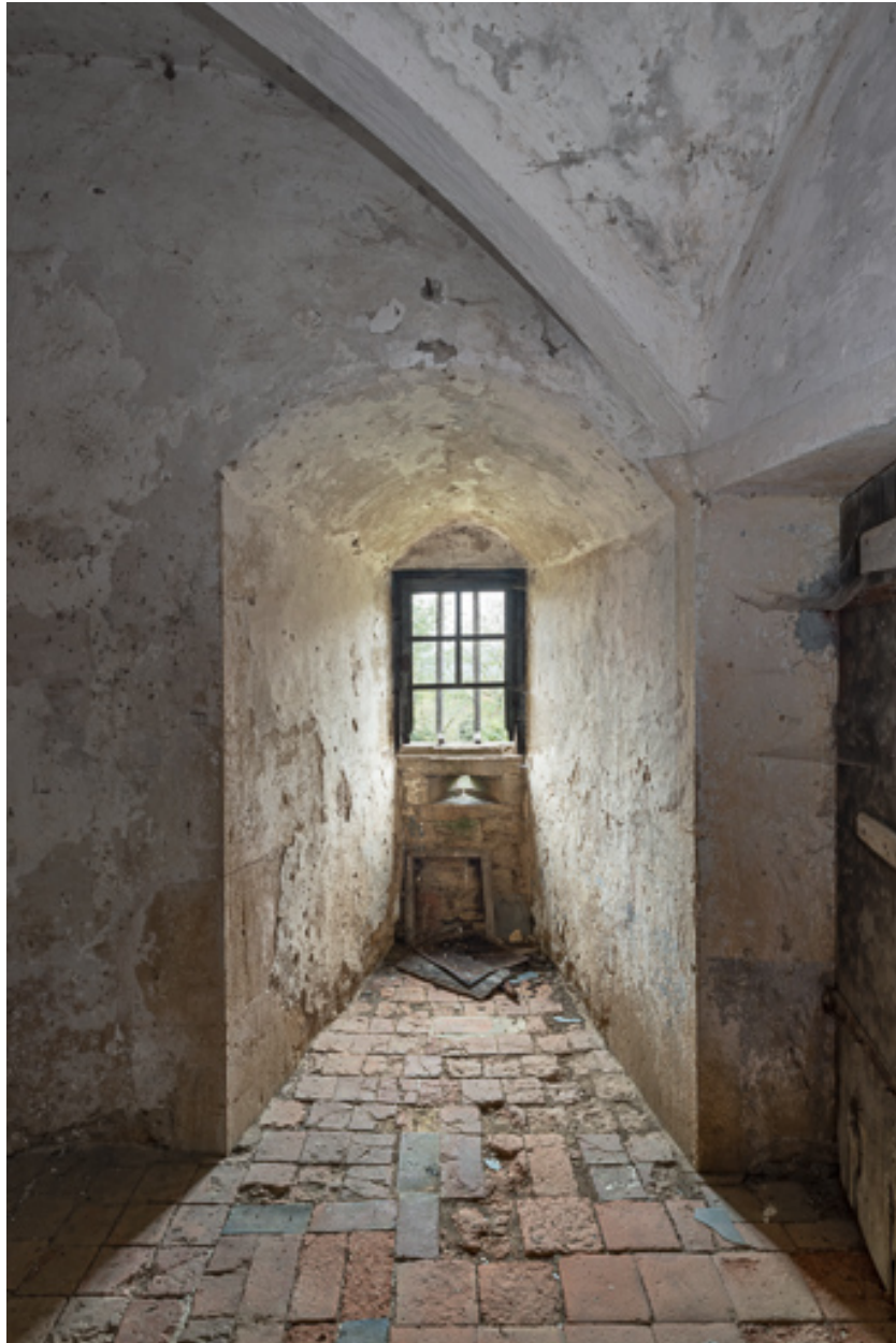
Embrasure et fenêtre dans la pièce principale du premier étage de la tour
