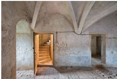
Vue de la pièce principale du premier étage de la tour avec les portes d'accès à l'escalier en vis (à gauche) et à une pièce annexe (à droite) Phot. Pierre-Marie Barbe-Richaud IVR26_20197100379NUC4A
