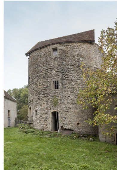
Vue de la tour de Chassagne au sud Phot. Pierre-Marie Barbe-Richaud IVR26_20197100375NUC4A
