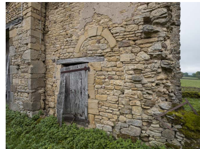
Extrémité de la grange, à l'est de la cour. La maçonnerie conserve l'arc en plein cintre (avec agrafe) qui couvrait l'ancienne porte de la chapelle et les traces d'arrachements d'un mur qui devait clôturer la cour intérieure du château. Phot. Pierre-Marie Barbe-Richaud IVR26_20197100390NUC4Q
