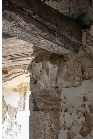
Culot marquant le départ de la voûte d'ogives qui couvrait à l'origine le second étage de la tour Phot. Pierre-Marie Barbe-Richaud IVR26_20197100385NUC4A
