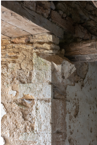
Culot marquant le départ de la voûte d'ogive qui couvrait à l'origine le second étage de la tour Phot. Pierre-Marie Barbe-Richaud IVR26_20197100384NUC4A
