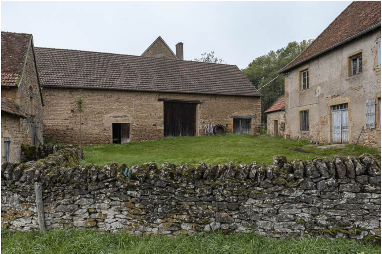
Autre vue de la ferme construite dans les années 1860.
