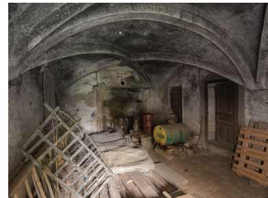
Pièce principale voûtée (ancienne cuisine ?) du rez-de-chaussée de la tour Phot. Pierre-Marie Barbe-Richaud IVR26_20197100386NUC4AQ
