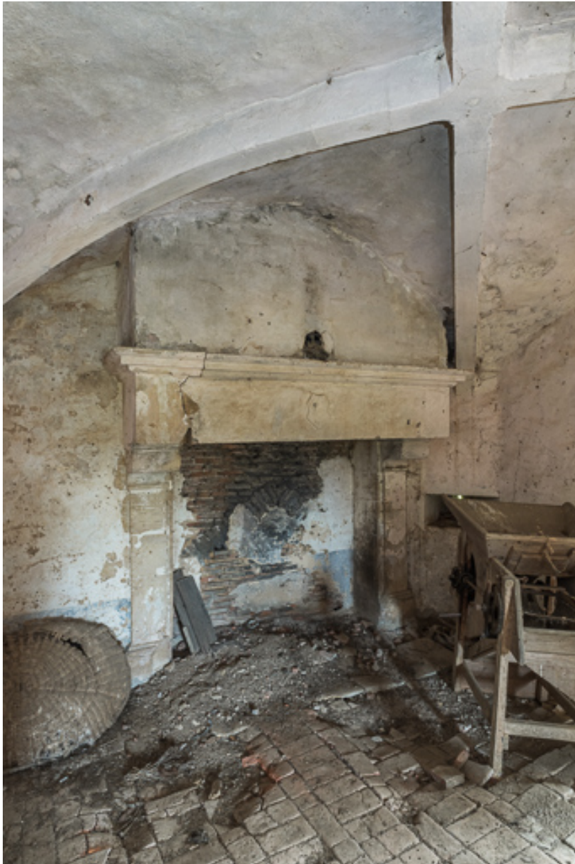
Cheminée de la pièce principale du rez-de-chaussée de la tour
