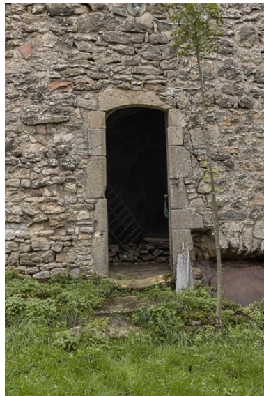
Porte d'accès au rez- de-chaussée de la tour Phot. Pierre-Marie Barbe-Richaud IVR26_20197100376NUC4A
