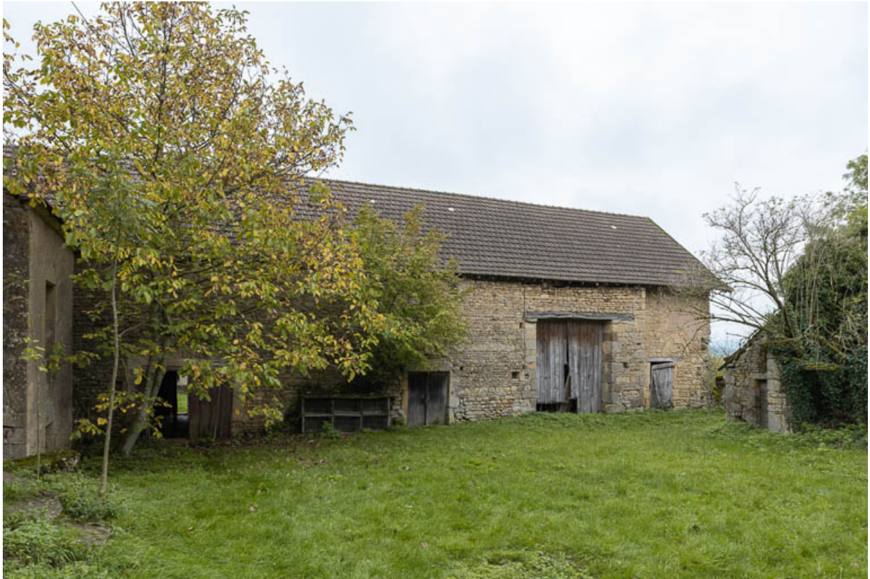
Grange, fermant la cour à l'est et abritant à son extrémité l'ancienne chapelle castrale
