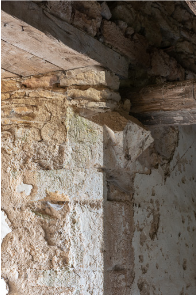
Culot marquant le départ de la voûte d'ogive qui couvrait à l'origine le second étage de la tour
