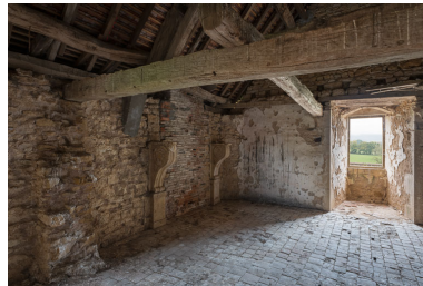
Vue du second étage de la tour, partiellement arasé Phot. Pierre-Marie Barbe-Richaud IVR26_20197100382NUC4A
