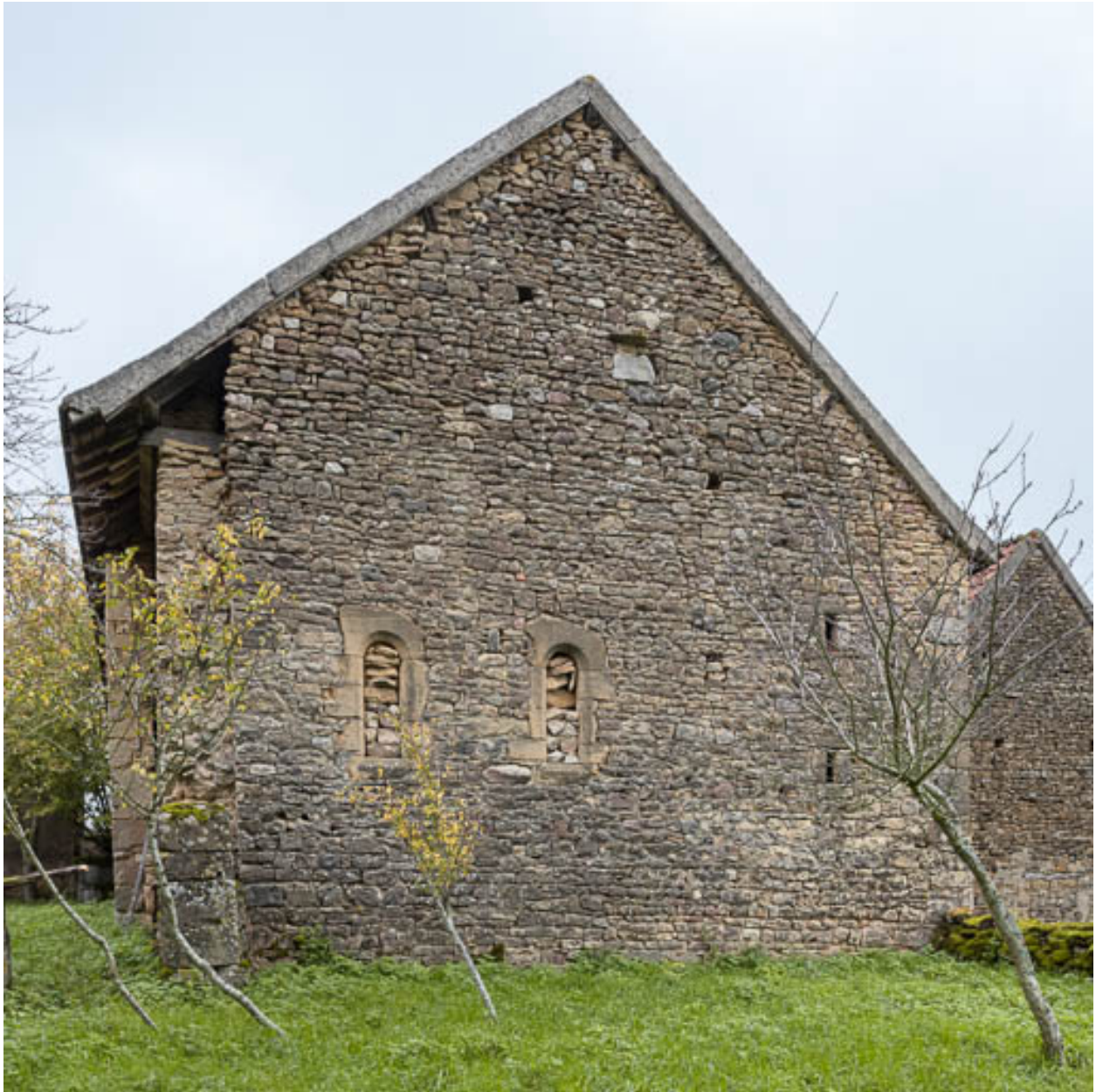
Mur-pignon sud de la grange. Deux anciennes baies cintrées, aujourd'hui bouchées, éclairaient à l'origine l'intérieur de la chapelle.
