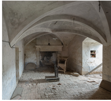
Vue de la pièce principale voûtée du premier étage de la tour Phot. Pierre-Marie Barbe-Richaud IVR26_20197100378NUC4AQ
