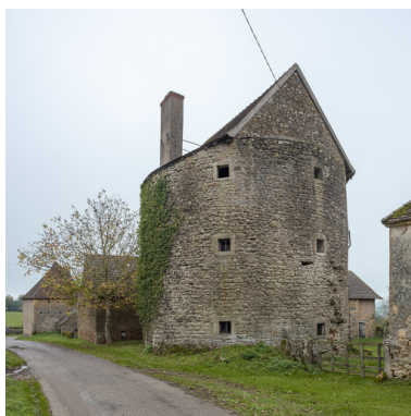
Vue de la tour de Chassagne et des bâtiments de ferme environnants au nord-ouest, depuis la voie communale n°3 Phot. Pierre-Marie Barbe-Richaud IVR26_20197100397NUC2A
