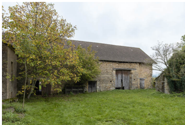
Grange, fermant la cour à l'est et abritant à son extrémité l'ancienne chapelle castrale Phot. Pierre-Marie Barbe-Richaud IVR26_20197100389NUC4A
