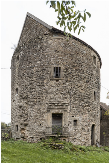
Vue de la tour de Chassagne à l'ouest Phot. Pierre-Marie Barbe-Richaud IVR26_20197100373NUC4A
