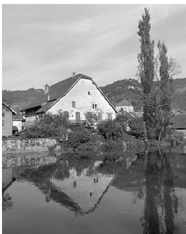
Maison située route de Besançon. Phot. Yves Sancey IVR43_19802501362X
