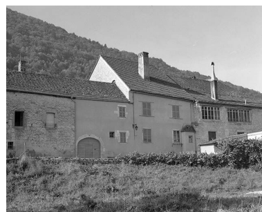
Maisons située rue Gérard. Phot. Yves Sancey IVR43_19802501350X
