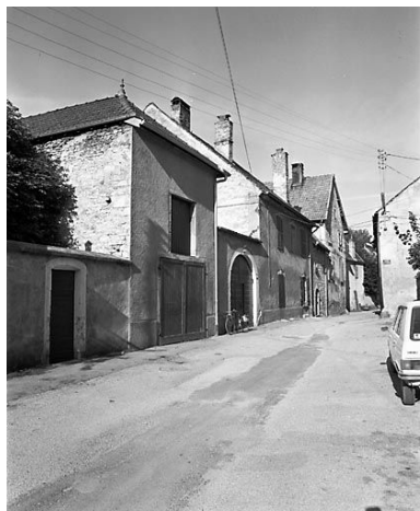
Maison située 3 rue Carnot. Phot. Yves Sancey IVR43_19802501370X
