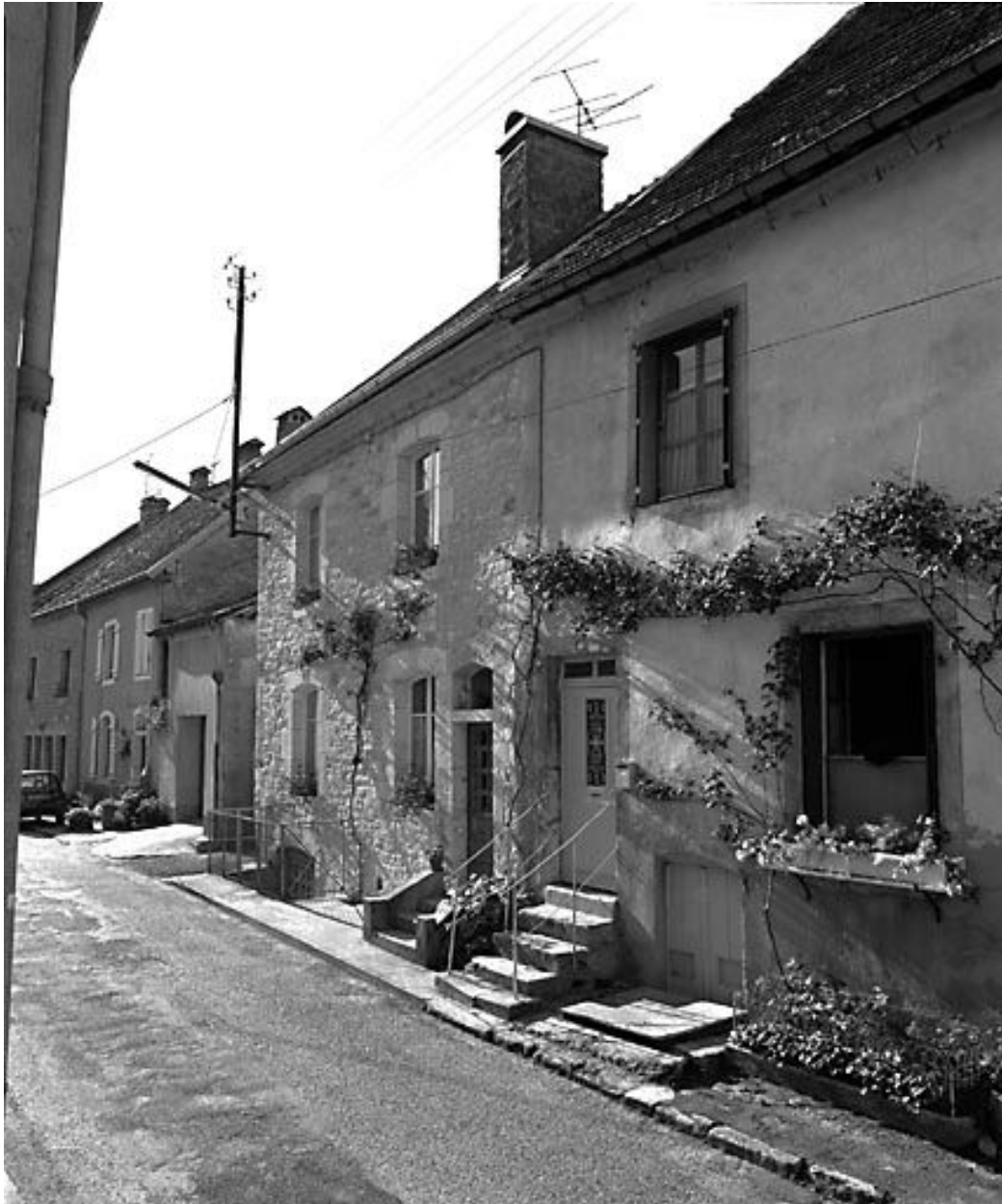
Maison de vigneron située 4 Grande Rue.
