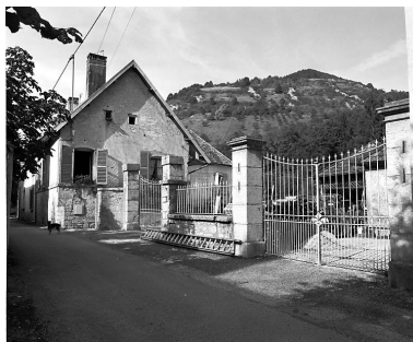
Maison située 14 rue Carnot. Phot. Yves Sancey IVR43_19802501369X
