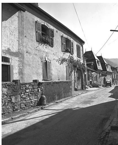
Maison de vigneron située 1 Grande Rue. Phot. Yves Sancey
