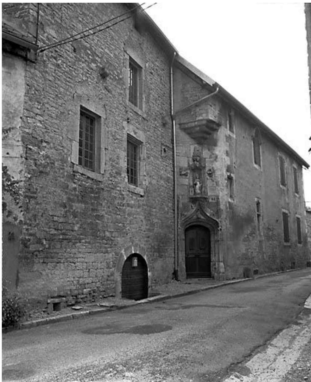
Maison de Balthazar Gérard située 3 rue Gérard.
