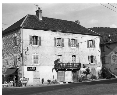
Maison située route de Pontarlier. Phot. Yves Sancey IVR43_19802501406X
