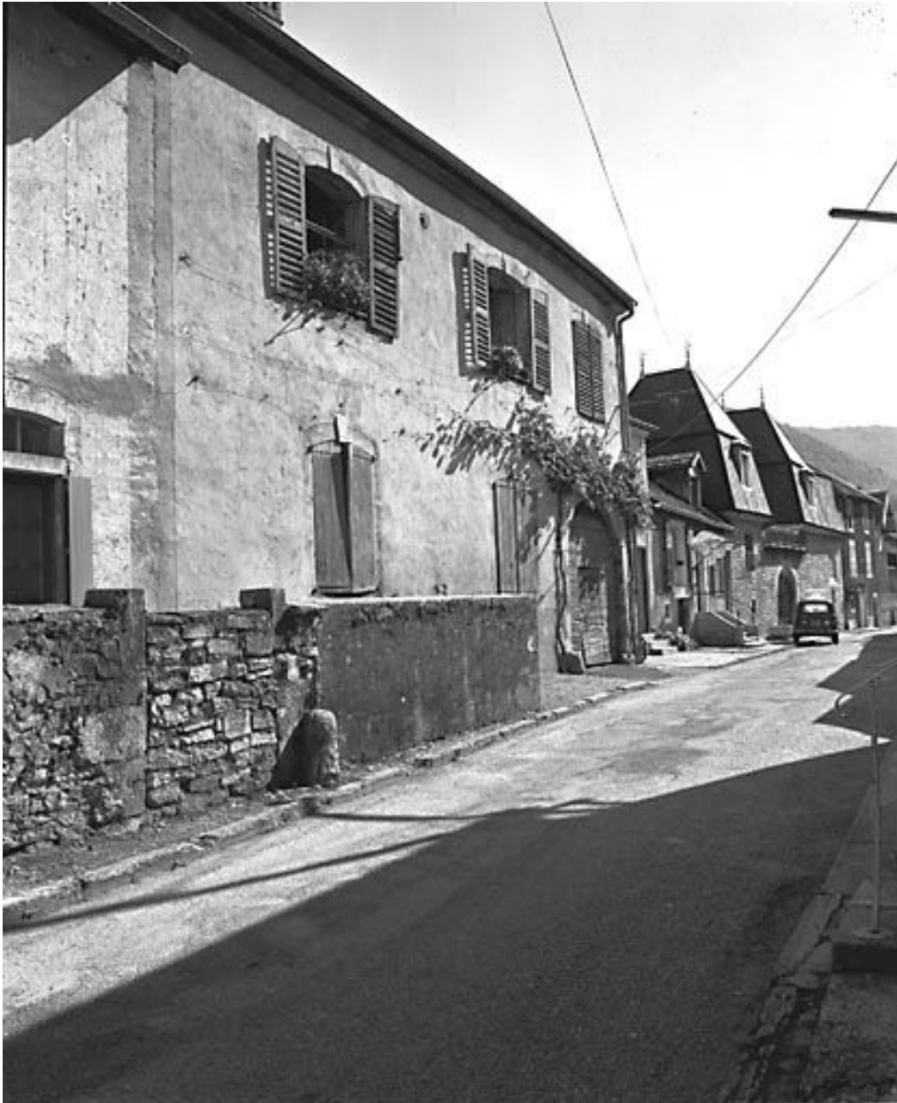
Maison de vigneron située 1 Grande Rue.
