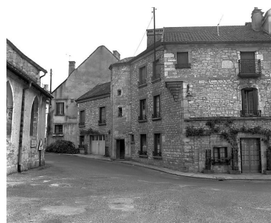
Maison de vigneron située place Saint-Vernier. Phot. Yves Sancey IVR43_19802501396X
