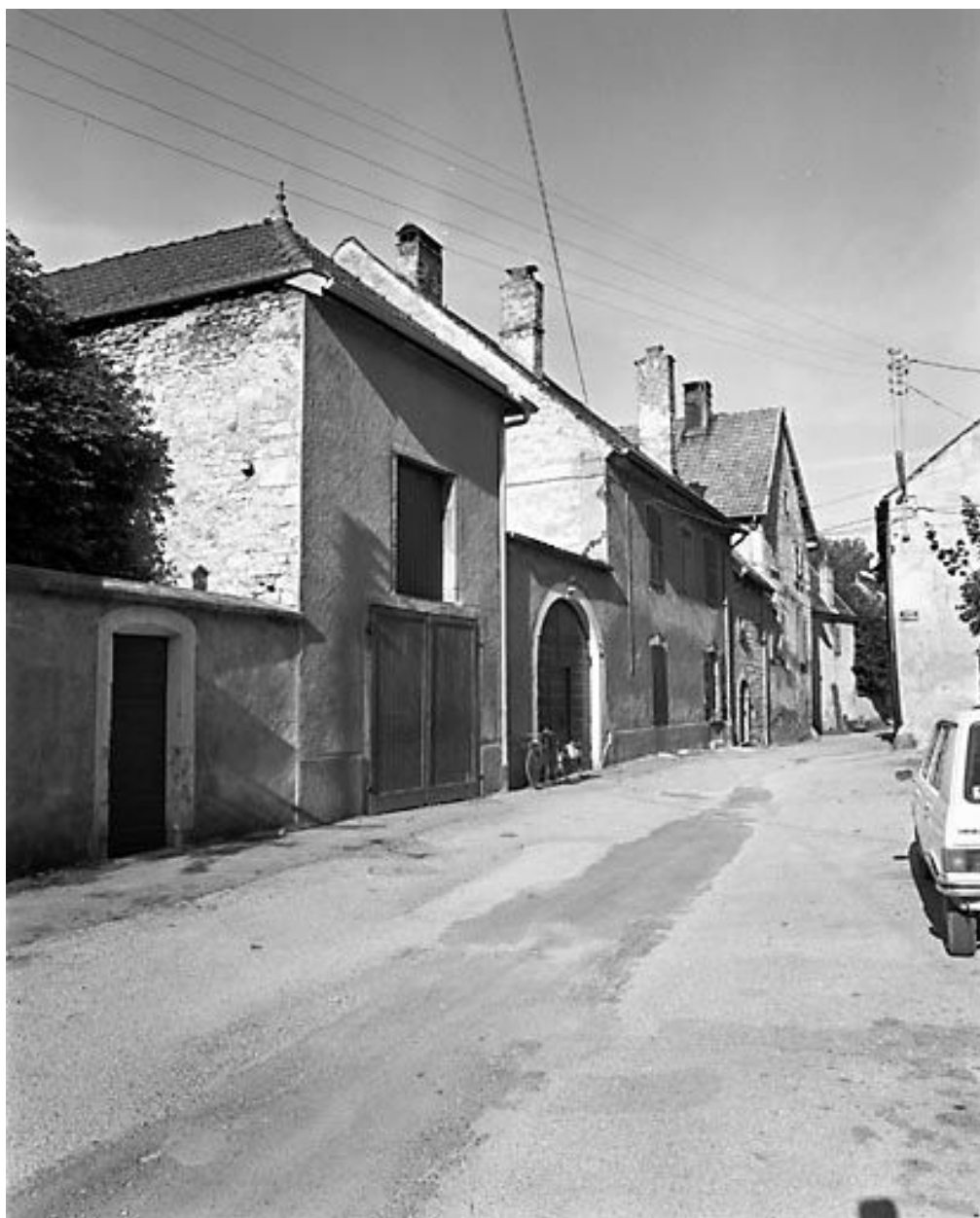
Maison située 3 rue Carnot.
