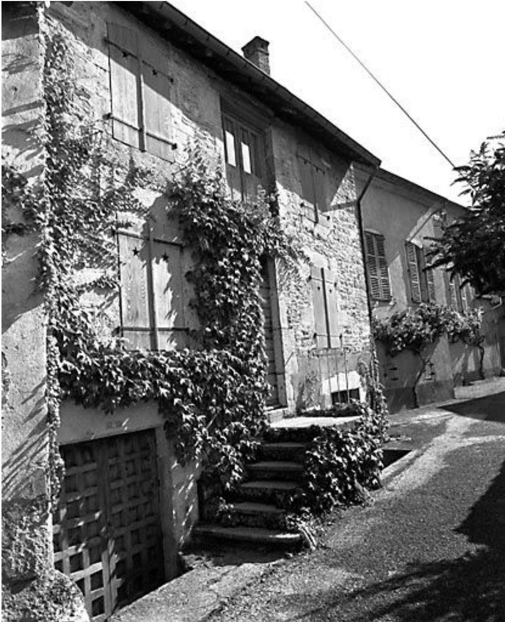
Maison de vigneron située 4 rue du Téméraire.
