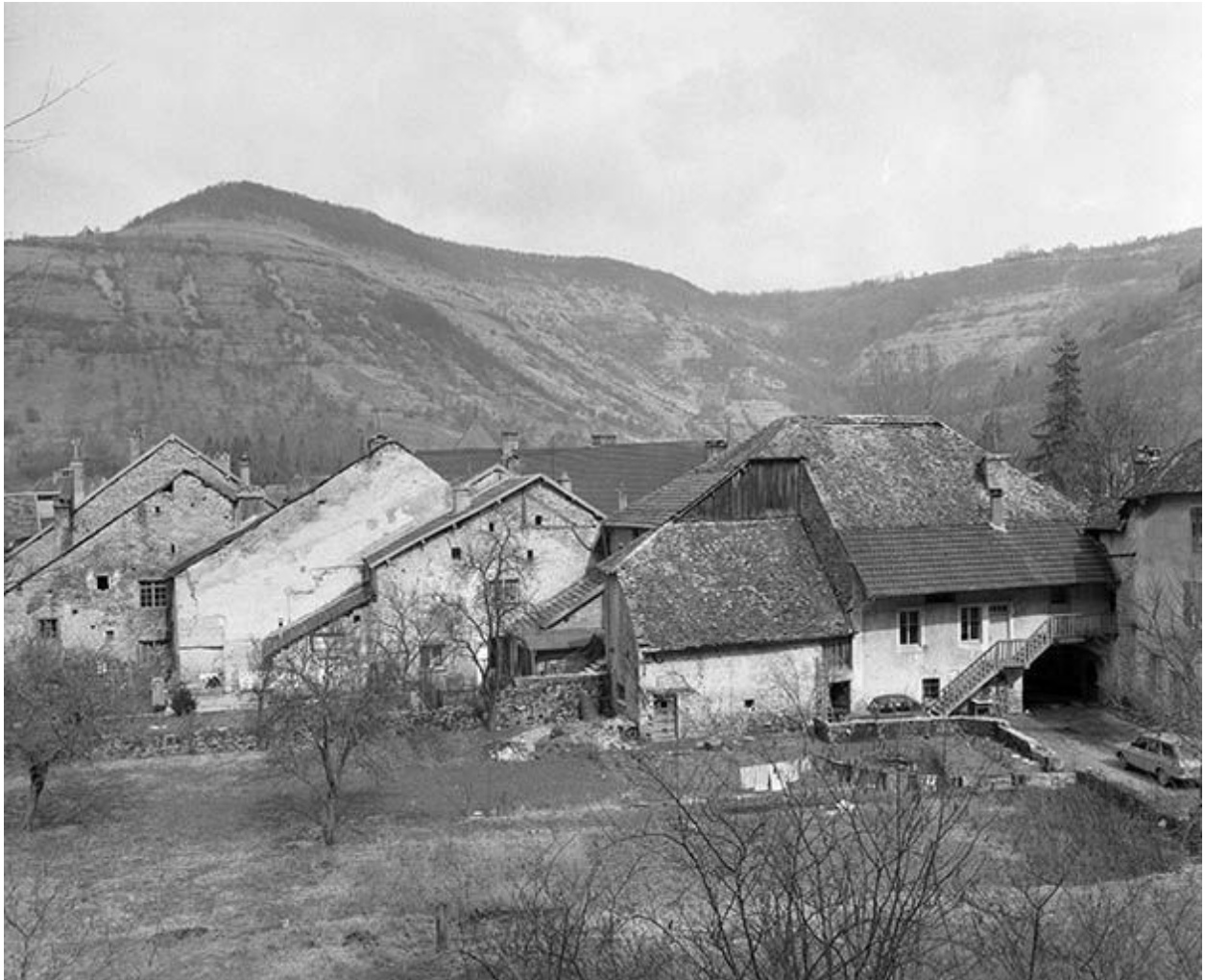
Vue d'ensemble du revers des maisons et des fermes de la rue Gérard.
