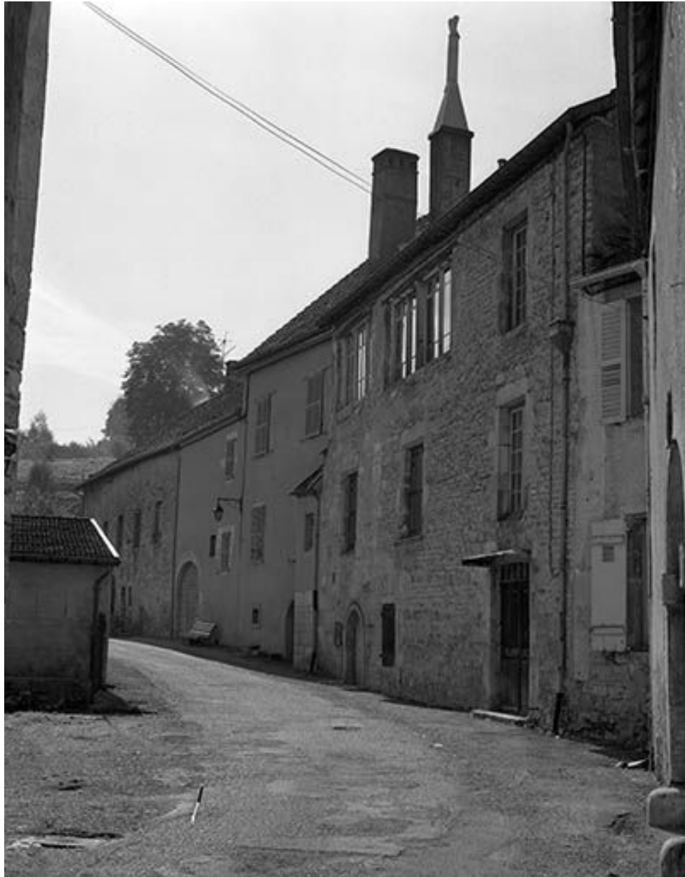
Vue d'ensemble des façades antérieures des maisons et des fermes de la rue Gérard.
