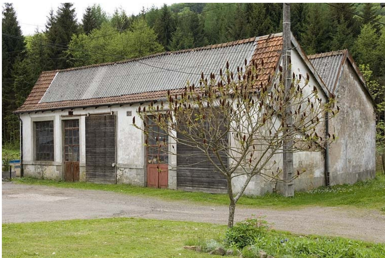
Atelier de réparation (menuiserie, forge).
