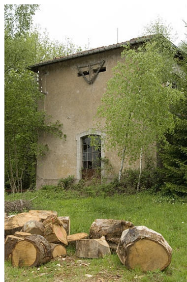
Transformateur. Phot. Jérôme Mongreville IVR43_20067000393NUCA
