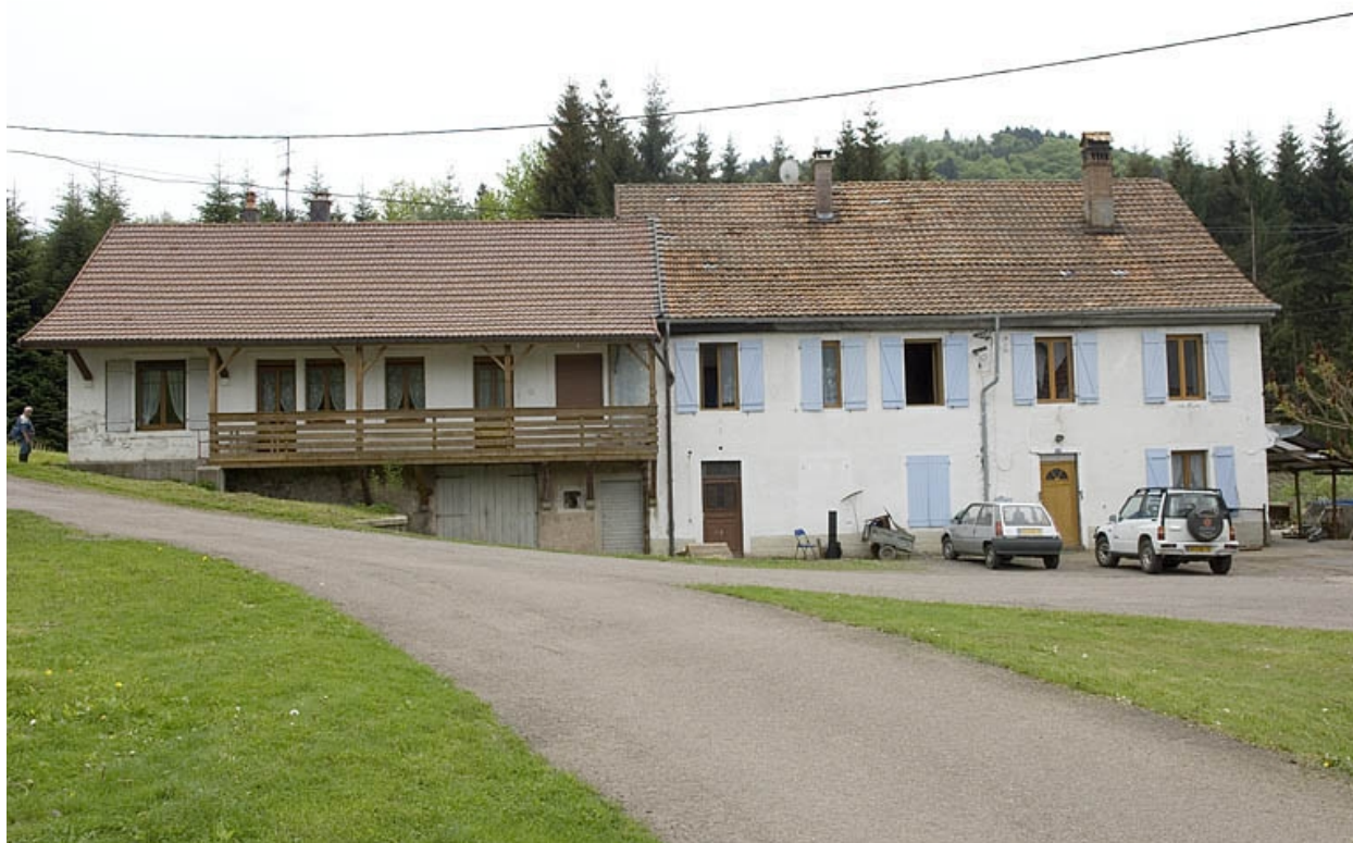
Logement ouvrier et patronal.
