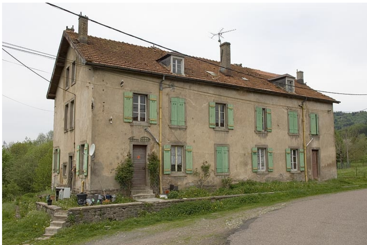
Logement ouvrier collectif.
