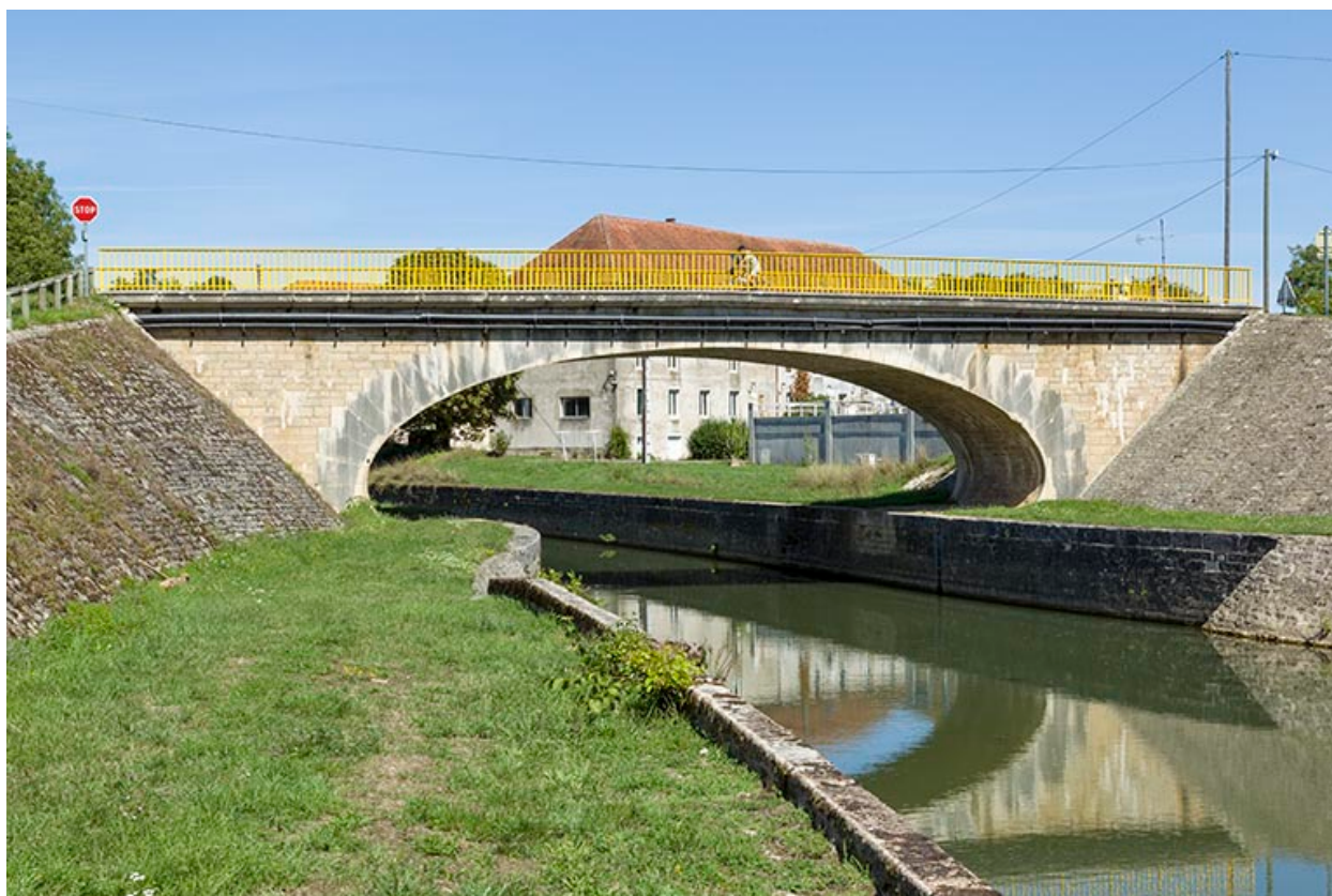
Pont de Soing.
