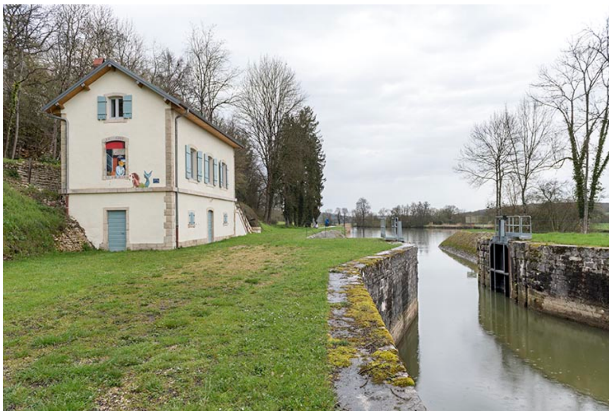
Vue depuis l'aval du site d'écluse.
