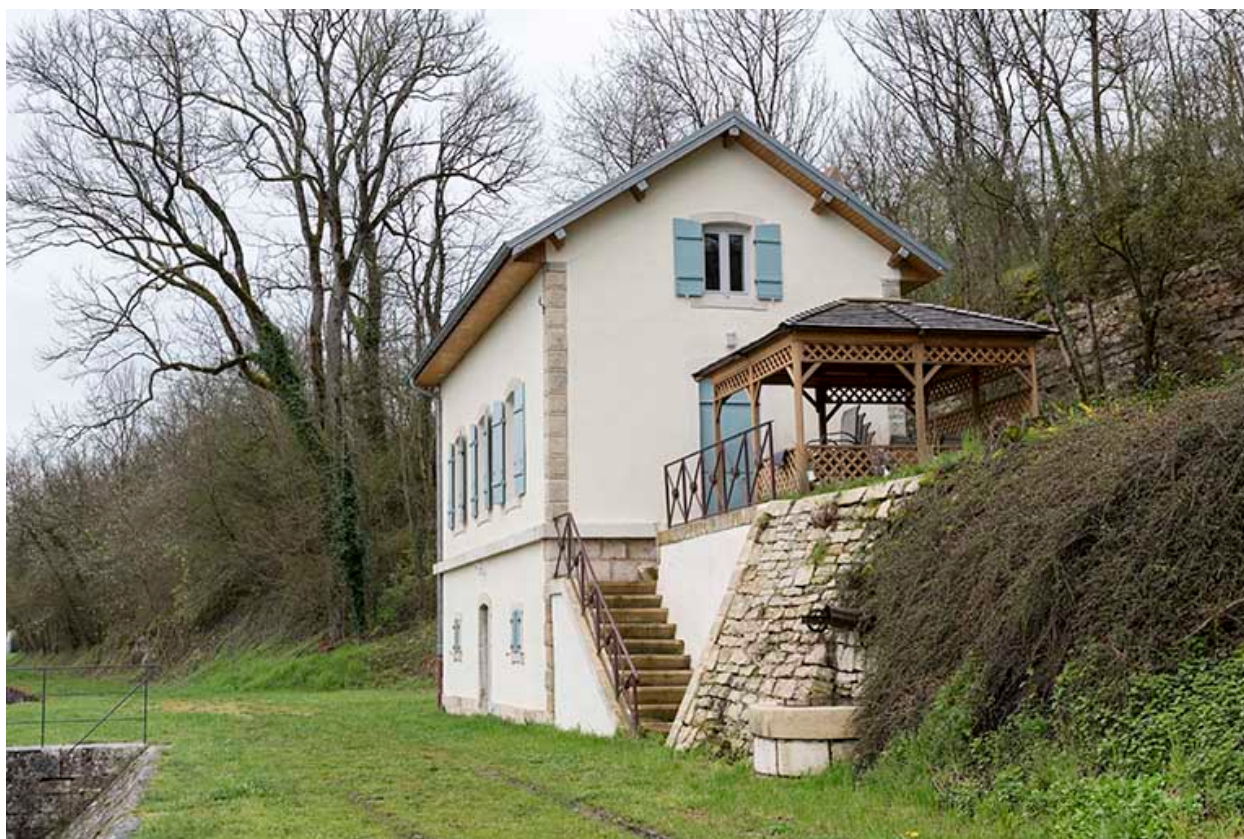
La maison d'éclusier.
