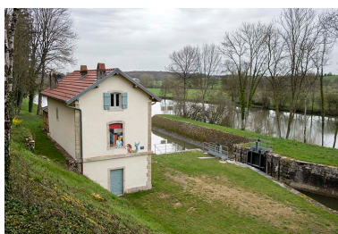
le site d'écluse, vue d'ensemble. Phot. Sonia Dourlot IVR43_20157001549NUC4A
