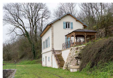
La maison d'éclusier. Phot. Sonia Dourlot IVR43_20157001544NUC4A
