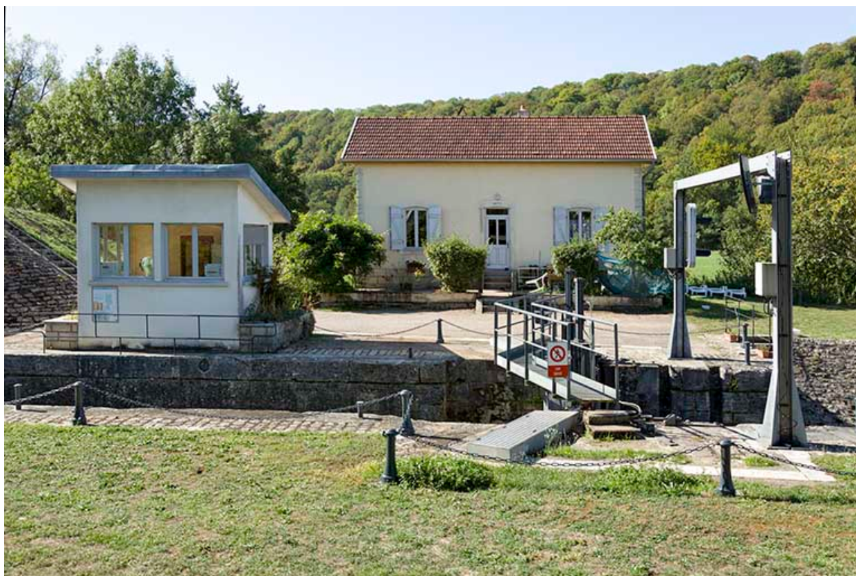
Le site d'écluse de Soing, dernier ouvrage du bief de Soing.
