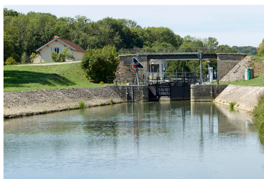
Entrée amont de l'écluse à sas de Soing. Phot. Sonia Dourlot IVR43_20157000812NUC2A
