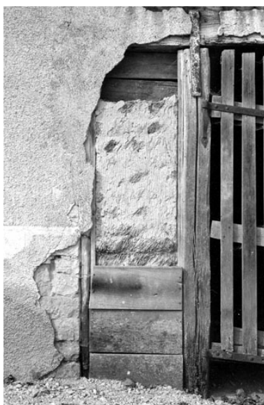
Détail : matériaux de construction. Phot. Bernard Lardière IVR43_19797000020Z
