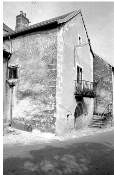
Façade sur rue. Phot. Bernard Lardière IVR43_19797000017Z
