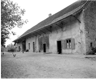
Façade antérieure, vue générale. Phot. Yves Sancey IVR43_19793900241X
