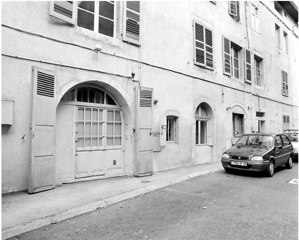
Elévation postérieure : baies du rez-de-chaussée.
