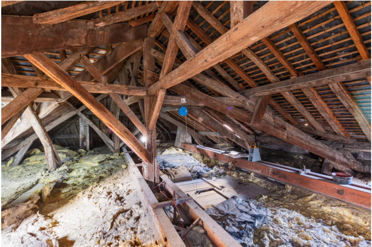
Comble à surcroît.
