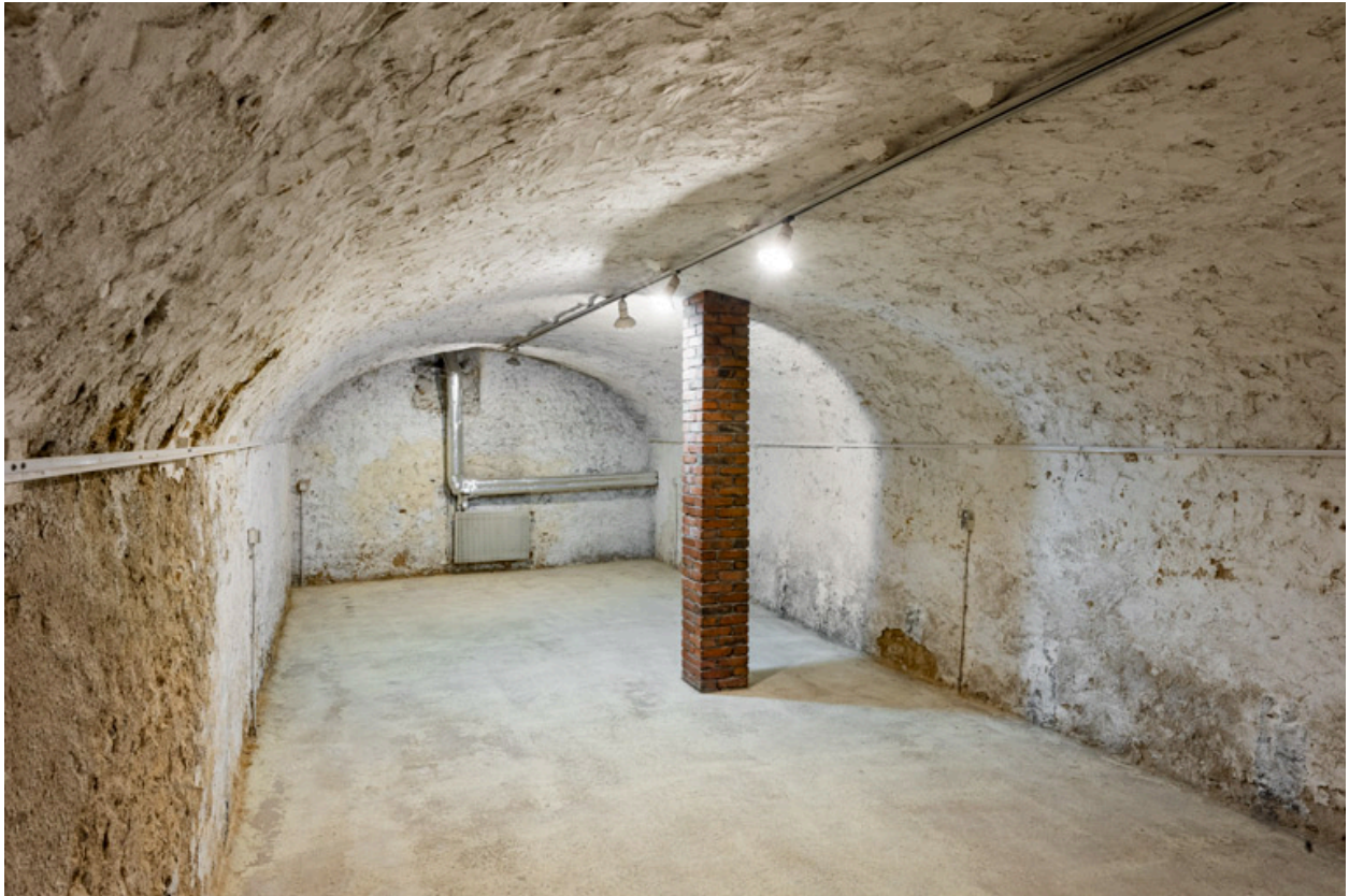
Cave voûtée en sous-sol.
