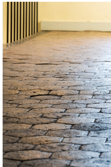
Sol de tomettes du couloir desservant le balcon et l'étage en surcroît.
