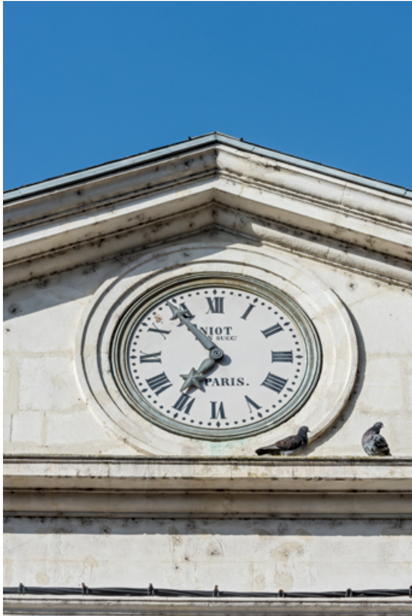
Façade antérieure, avant-corps central : horloge Niot.
