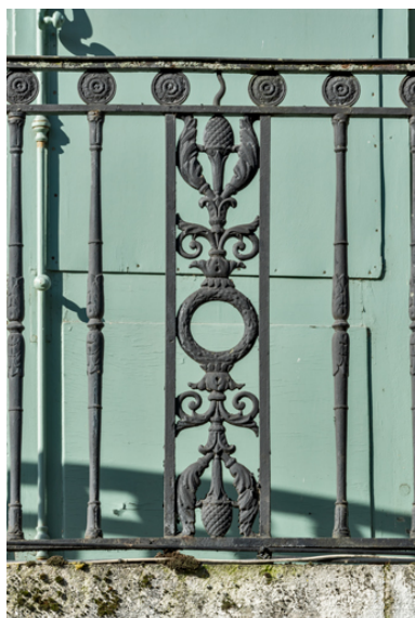
Façade antérieure, avant- corps central : détail du garde- corps en fonte du balcon. Phot. Pierre-Marie Barbe-Richaud IVR26_20238900315NUC4A
