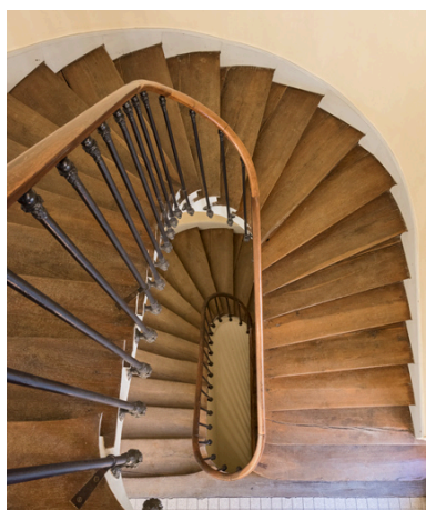
Escalier, vu du palier du comble à surcroît. Phot. Pierre-Marie Barbe-Richaud IVR26_20238900330NUC4A
