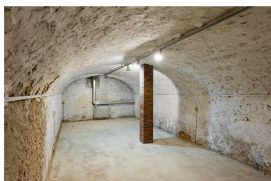
Cave voûtée en sous-sol. Phot. Pierre-Marie Barbe-Richaud IVR26_20238900338NUC4A
