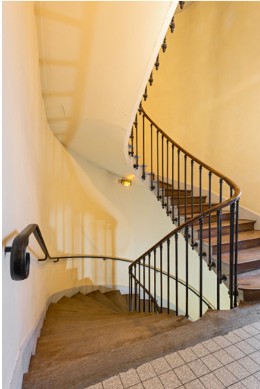
Escalier, au palier de l'étage carré.
