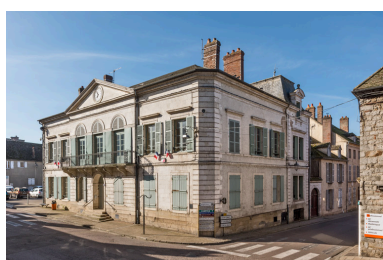
Vue d'ensemble, de trois quarts droite. Phot. Pierre-Marie Barbe-Richaud IVR26_20238900317NUC4A
