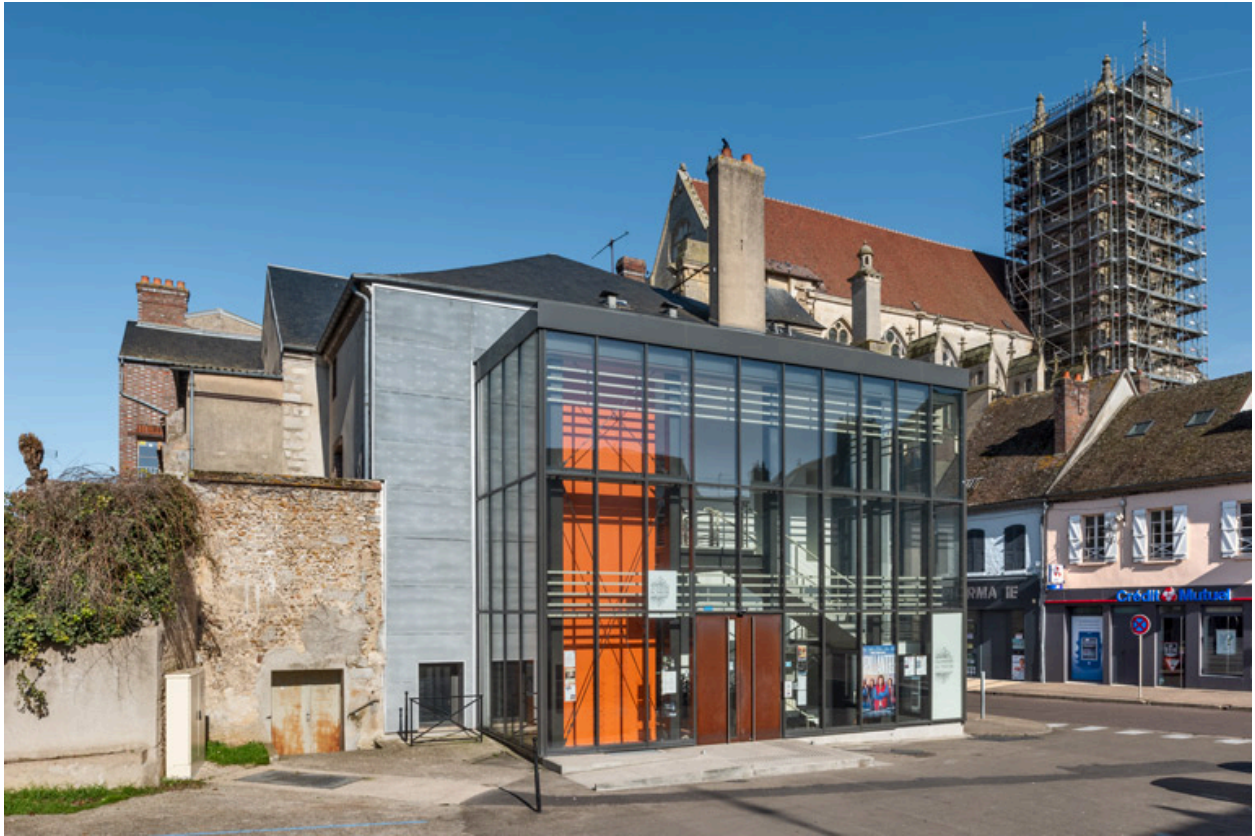
Façade latérale gauche, de trois quarts gauche.
