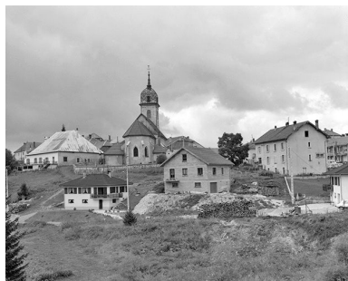
Vue d'ensemble du côté du chevet. Phot. Yves Sancey IVR43_19782500492X
