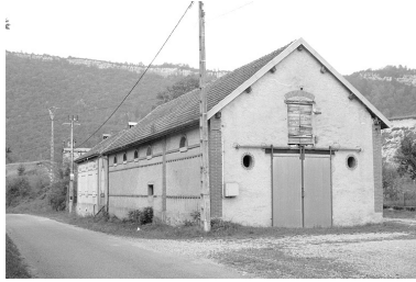
Les dépendances agricoles vues depuis la route. Phot. Laurent Poupard IVR43_19903900503Z
