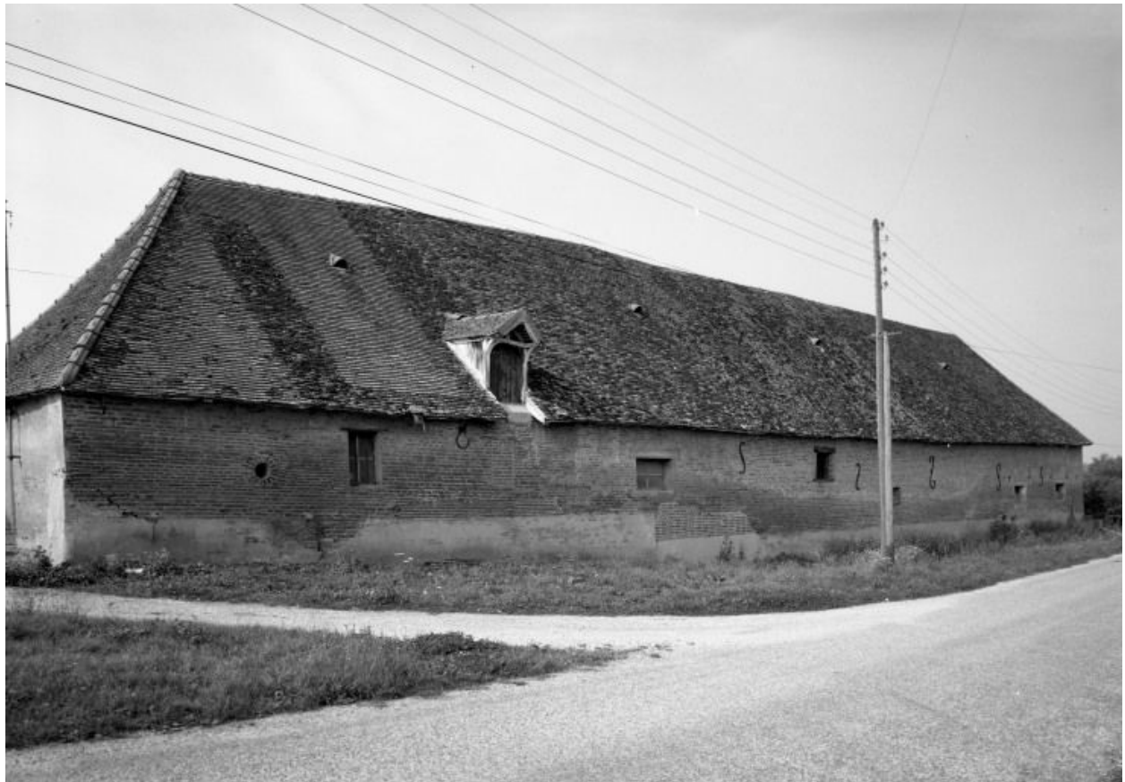
Elévation postérieure des dépendances.
