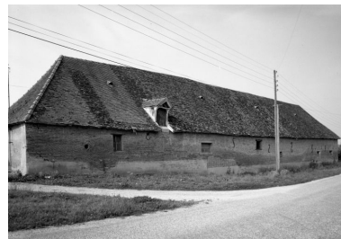
Elévation postérieure des dépendances. Phot. Michel Rosso IVR26_19852101081V
