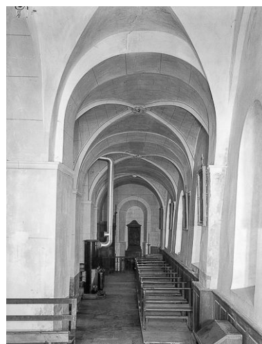
Intérieur : collatéral gauche. Phot. Yves Sancey IVR43_19743901114V
