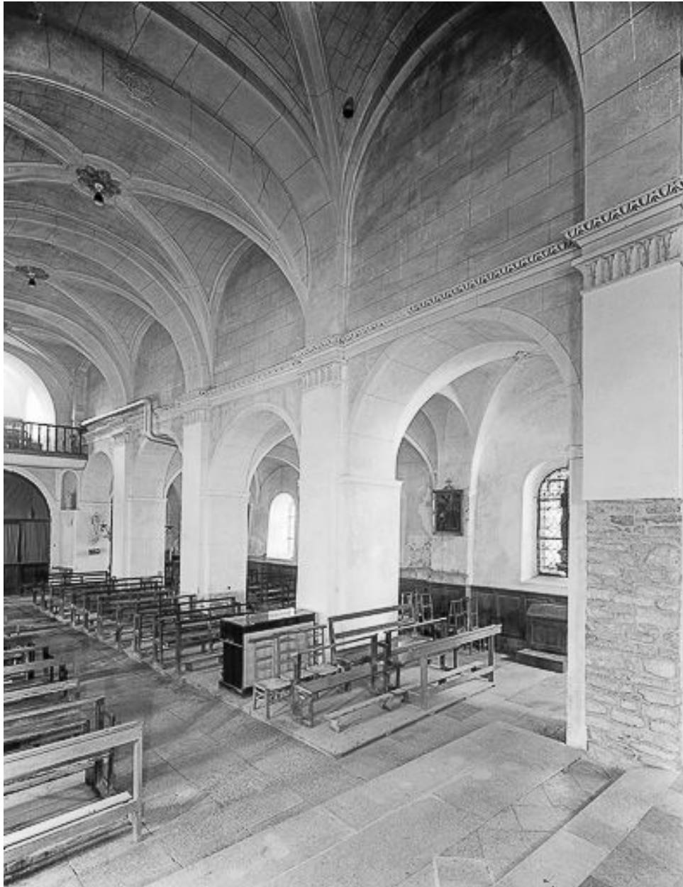
Intérieur : nef, élévation gauche, vue du chœur.
