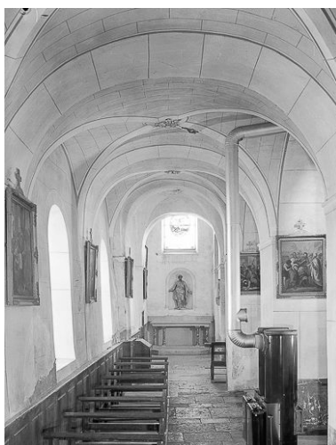
Intérieur : collatéral gauche. Phot. Yves Sancey IVR43_19743901113V
