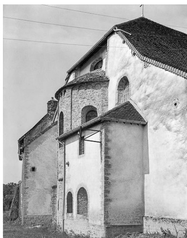
Eglise : abside et sacristie. Phot. Yves Sancey IVR43_19743901105V
