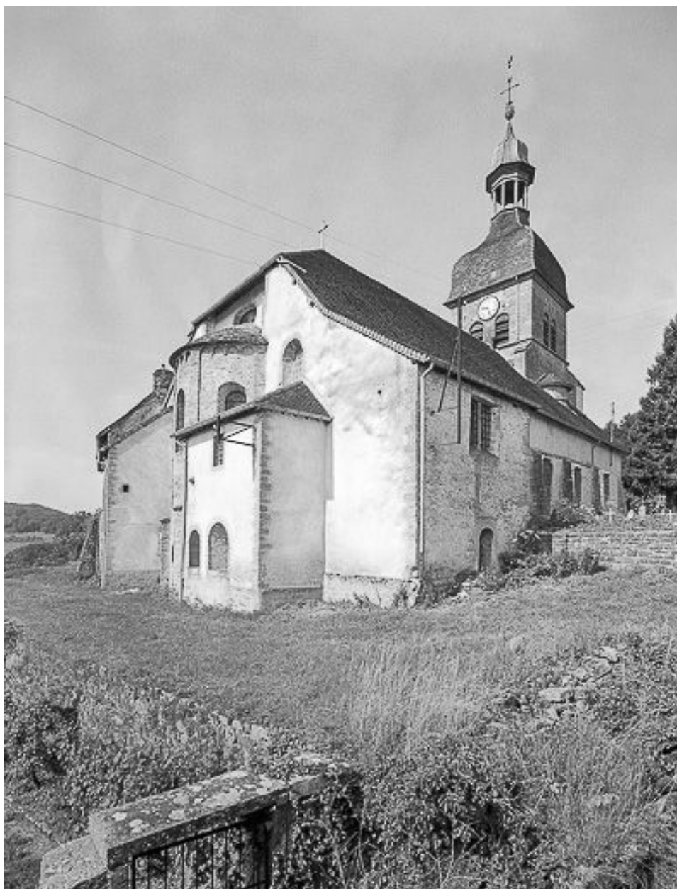
Eglise : façades postérieure et latérale gauche.
