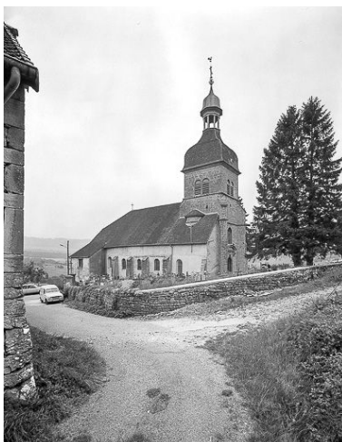
Eglise : façades antérieure et latérale gauche. Phot. Yves Sancey IVR43_19743901107V
