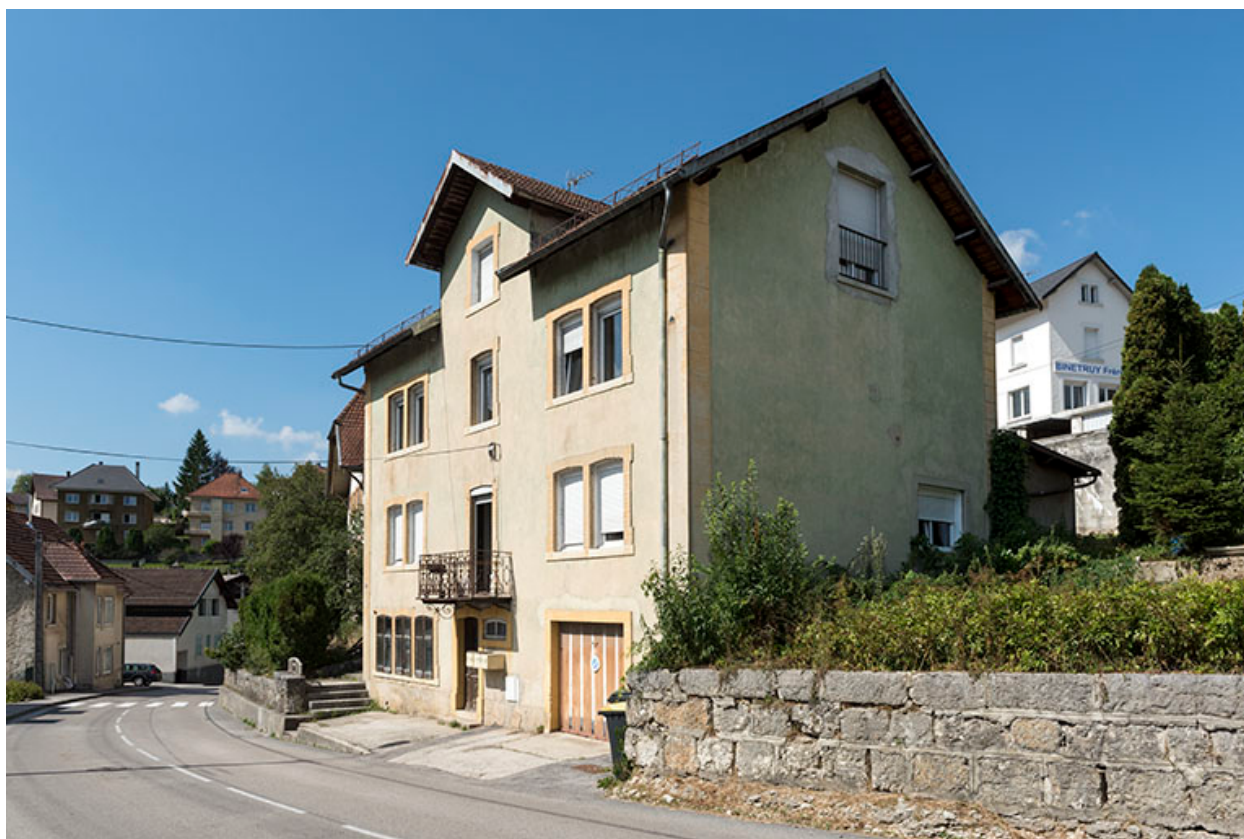
Façades antérieure et latérale droite.
