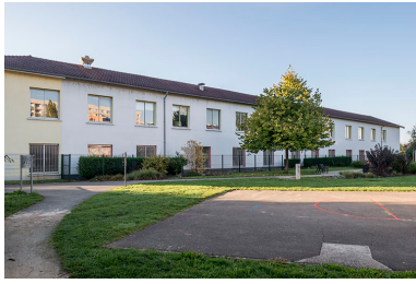
Façade nord de l'agrandissement (milieu 20e siècle). Phot. Jérôme Mongreville IVR43_20172501308NUC4A
