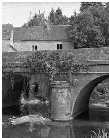
Face aval : la pile. Phot. Yves Sancey IVR43_19843900112X
