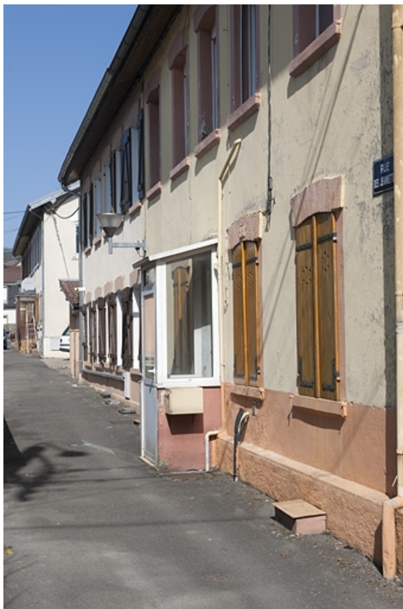
Détail d'une façade d'une habitations à 8 logements.
