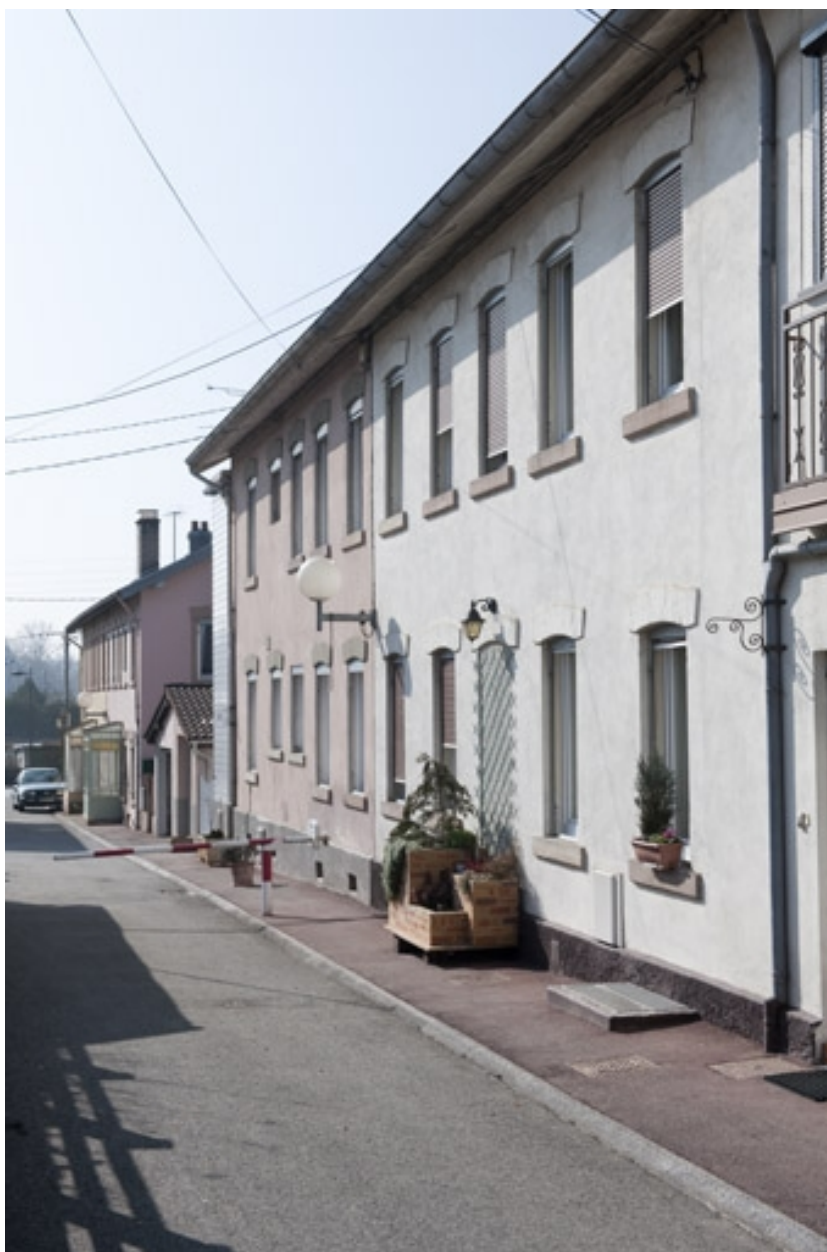
Rue des Campenottes. Habitations à 8 logements.
