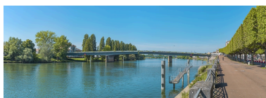
Vue d'ensemble du pont Jean- Richard depuis l'amont, au niveau du quai Gambetta. Phot. Thierry Kuntz IVR26_20217100271NUC4A
