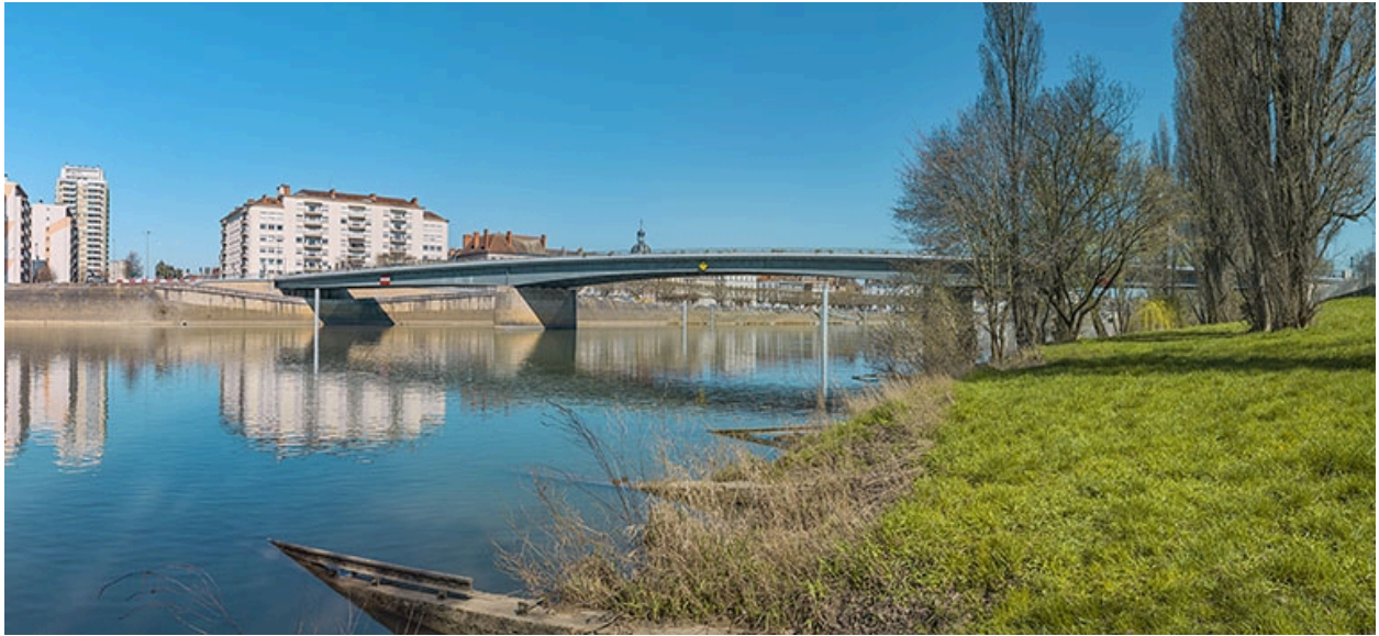
Vue d'ensemble du pont, prise d'aval.
