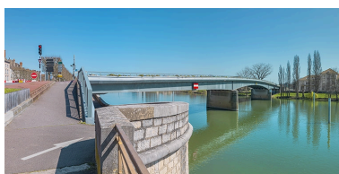
Vue d'ensemble du pont, prise d'aval. Au premier plan : la banquette de halage. Phot. Thierry Kuntz IVR26_20217100073NUC4A
