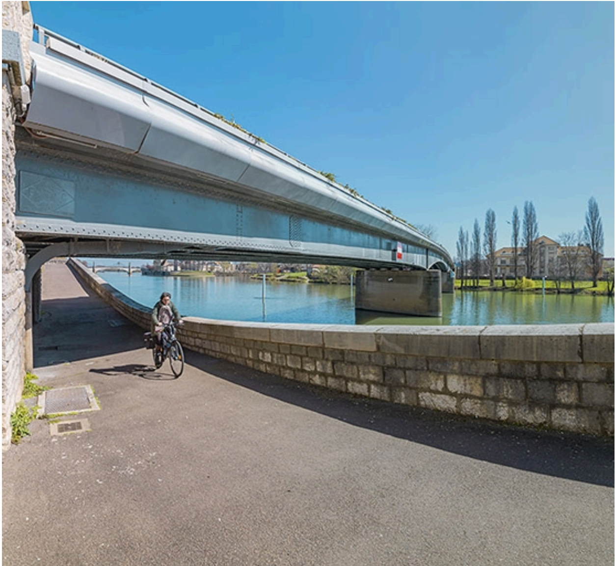
Tablier du pont vu depuis la banquette de halage.
