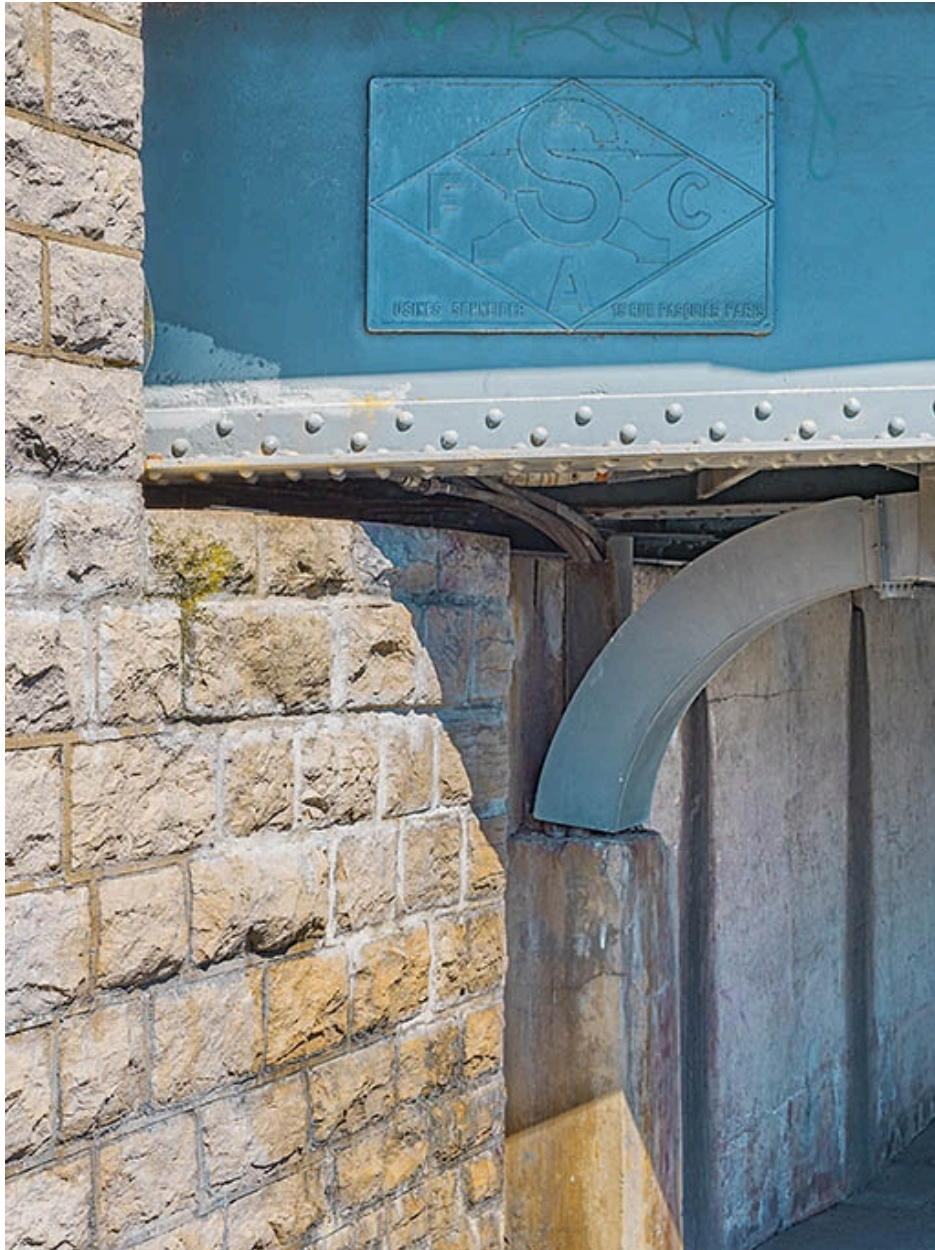
Détail de la plaque sur le tablier du pont.
