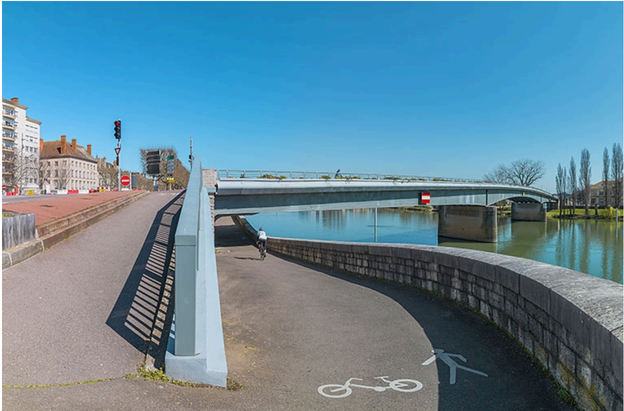
Vue d'ensemble du pont depuis l'aval et la banquette de halage.
