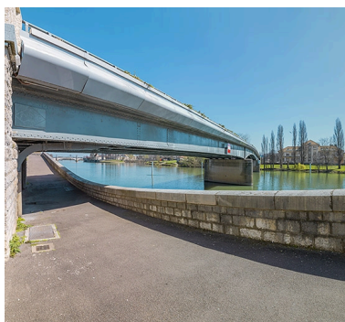
Tablier du pont vu depuis la banquette de halage. Phot. Thierry Kuntz IVR26_20217100077NUC4A
