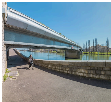
Tablier du pont vu depuis la banquette de halage. Phot. Thierry Kuntz IVR26_20217100076NUC4A
