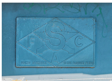
Détail de la plaque sur le tablier du pont. Phot. Thierry Kuntz IVR26_20217100079NUC4A
