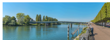
Vue d'ensemble du pont Jean- Richard depuis l'amont, au niveau du quai Gambetta. Phot. Thierry Kuntz IVR26_20217100272NUC4A
