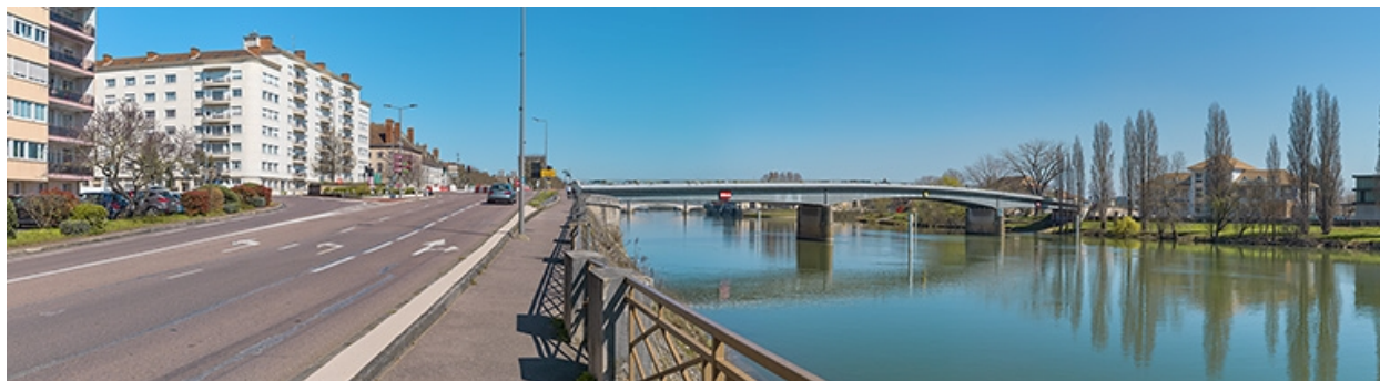
Vue d'ensemble du pont, prise d'aval, rive droite.
