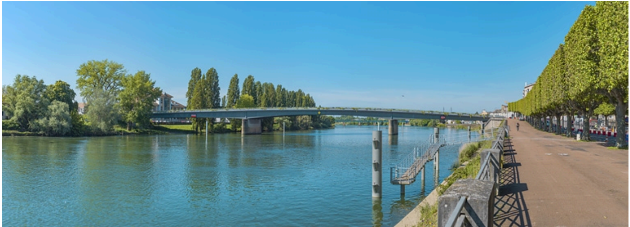
Vue d'ensemble du pont Jean-Richard depuis l'amont, au niveau du quai Gambetta.
