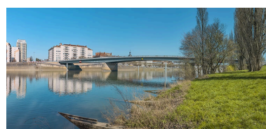
Vue d'ensemble du pont, prise d'aval. Phot. Thierry Kuntz IVR26_20217100070NUC4A
