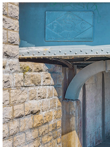
Détail de la plaque sur le tablier du pont. Phot. Thierry Kuntz IVR26_20217100078NUC4A
