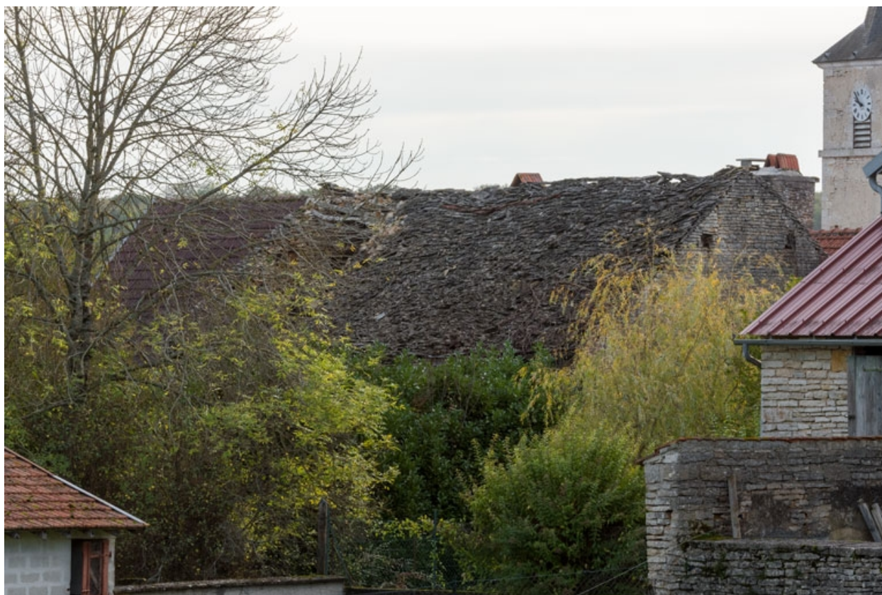
Vue nord de la toiture.
