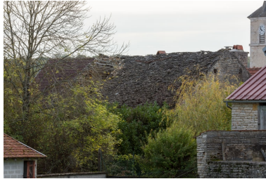
Vue nord de la toiture. Phot. Pierre-Marie Barbe-Richaud IVR26_20222100946NUC2A
