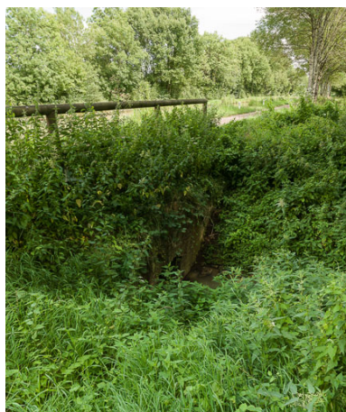
Vue de l'aqueduc.
