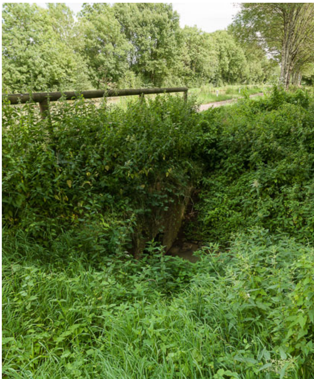
Vue de l'aqueduc.
