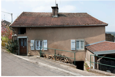
Façade antérieure. Phot. Jérôme Mongreville IVR43_20102500392NUC4A
