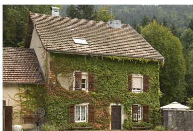
Maison : façade antérieure. Phot. Jérôme Mongreville IVR43_20082501156NUC2A
