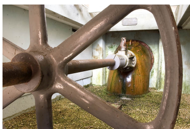
Usine : axe de transmission et volant. Phot. Jérôme Mongreville IVR43_20082501135NUC2A
