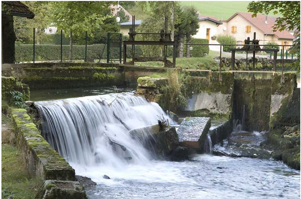
Canal d'amenée : vannes et déversoir.
