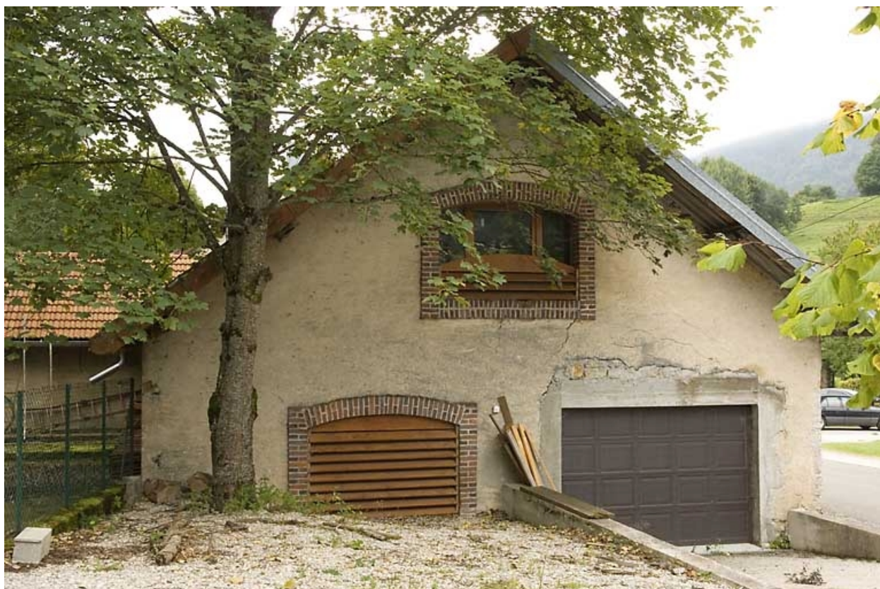
Usine : façade latérale gauche.
