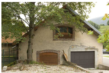
Usine : façade latérale gauche. Phot. Jérôme Mongreville IVR43_20082501143NUC2A
