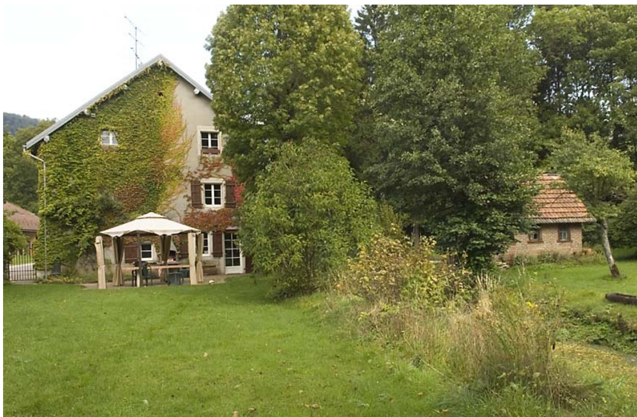
Maison : façade latérale droite.
