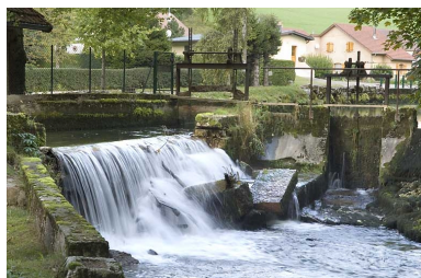
Canal d'amenée : vannes et déversoir. Phot. Jérôme Mongreville IVR43_20082501149NUC2A
