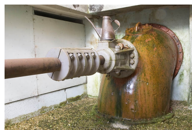
Usine : axe de transmission, sortant d'une conduite forcée. Phot. Jérôme Mongreville IVR43_20082501136NUC2A
