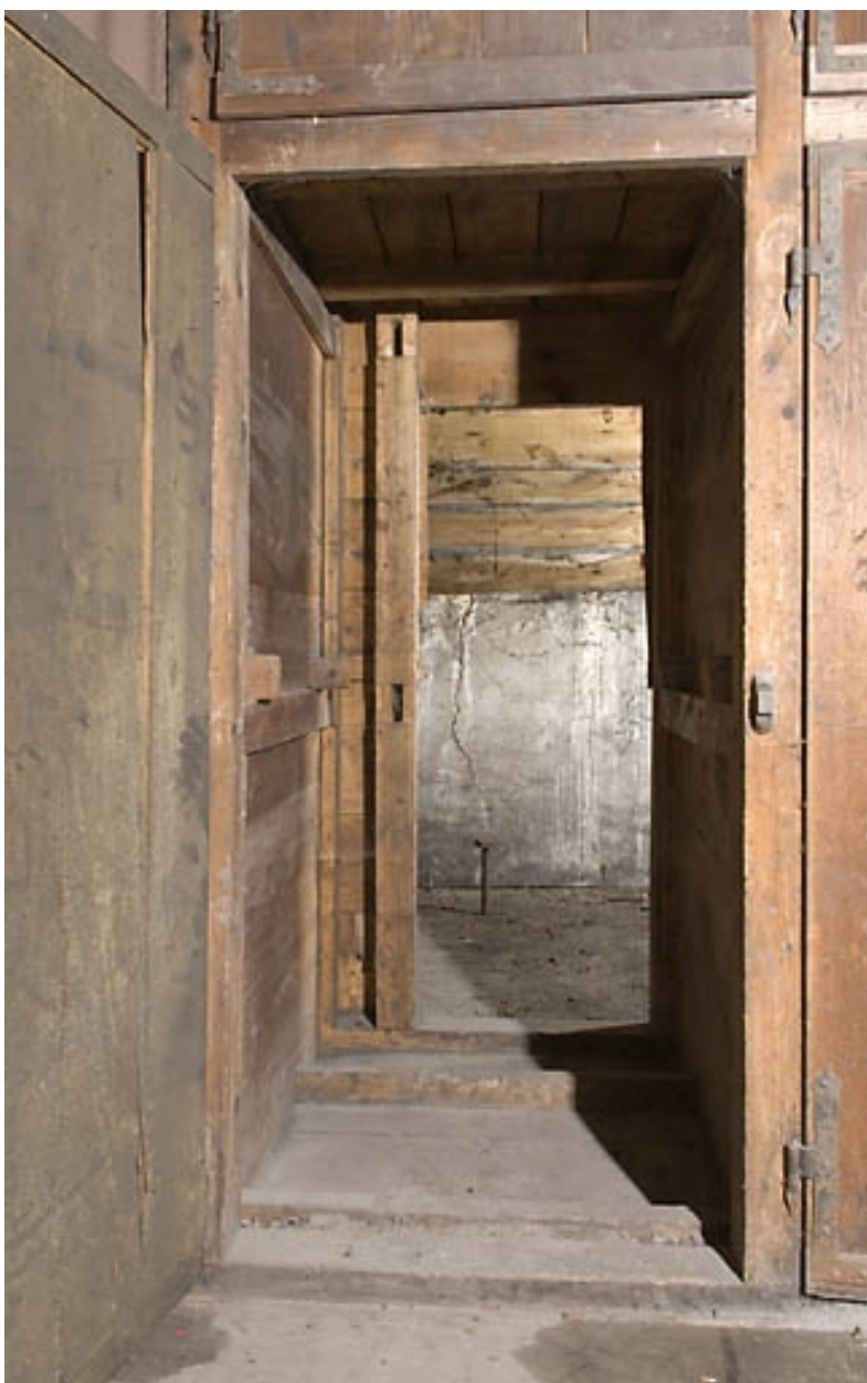
Usine, magasin industriel : placard ouvert.
