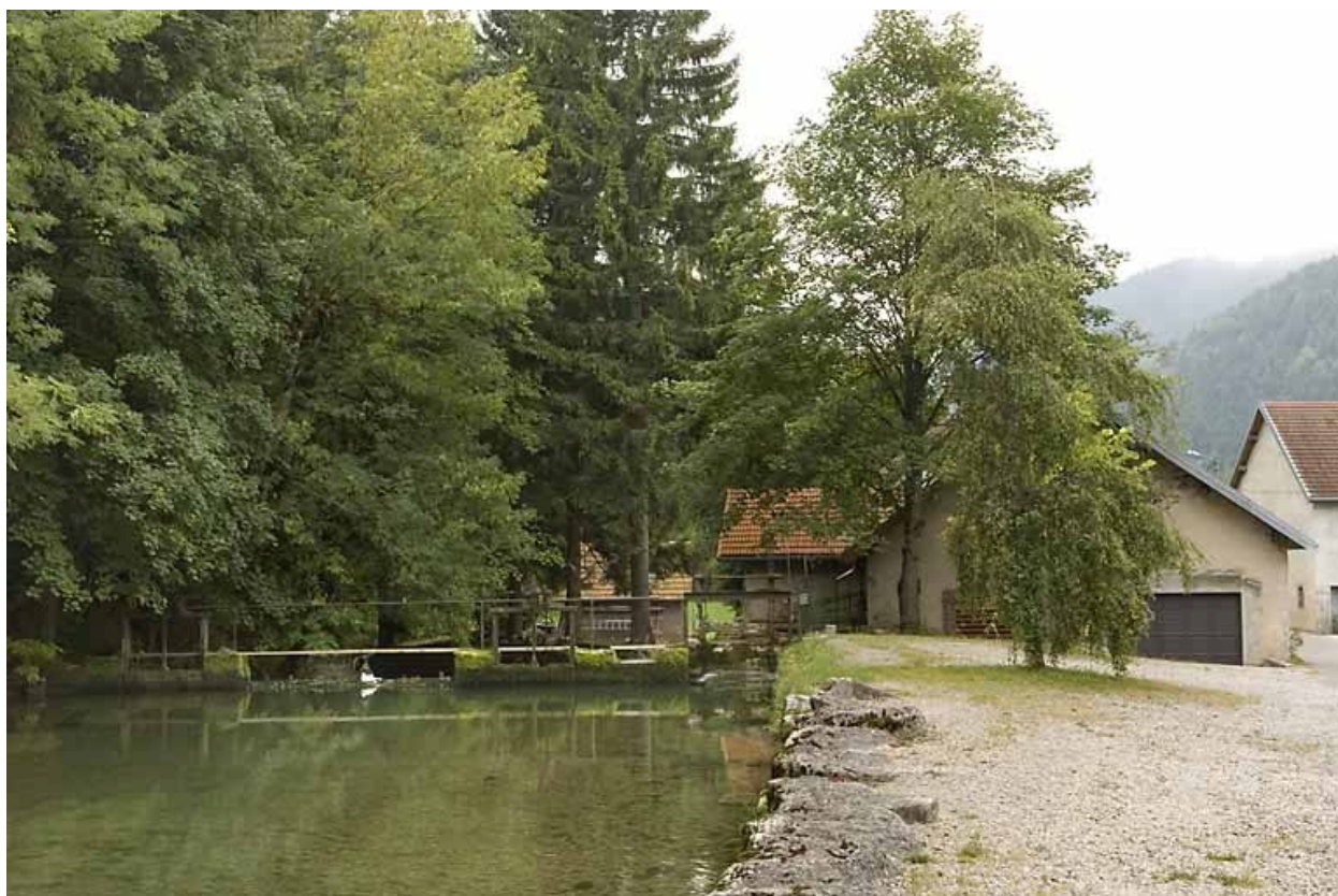
Canal d'amenée, depuis l'amont.
