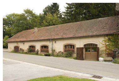
Usine, de trois quarts droite. Phot. Jérôme Mongreville IVR43_20082501146NUC2A
