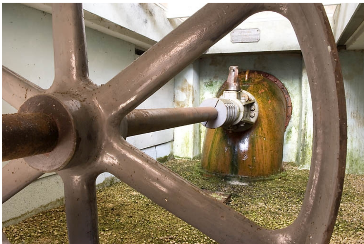
Usine : axe de transmission et volant.
