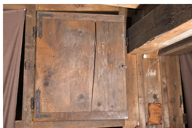
Usine, magasin industriel : placard avec inscriptions. Phot. Jérôme Mongreville IVR43_20082501138NUC2A
