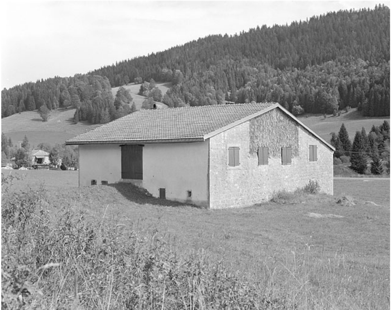
Façade postérieure et face sud-ouest.
