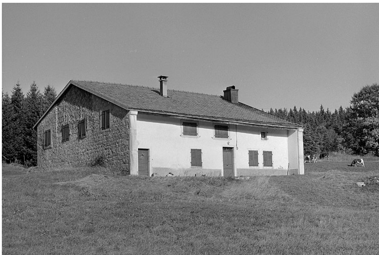
Façade antérieure et face sud-ouest.
