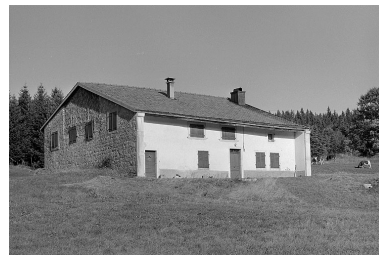
Façade antérieure et face sud-ouest. Phot. Jérôme Mongreville IVR43_19963901390X
