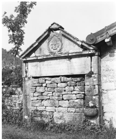
Vue générale. Phot. Yves Sancey IVR43_19793900131X
