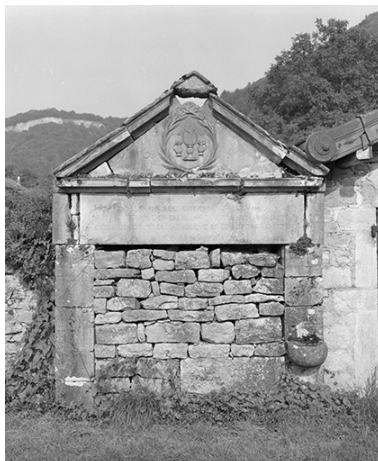
Vue générale. Phot. Yves Sancey IVR43_19793900132X
