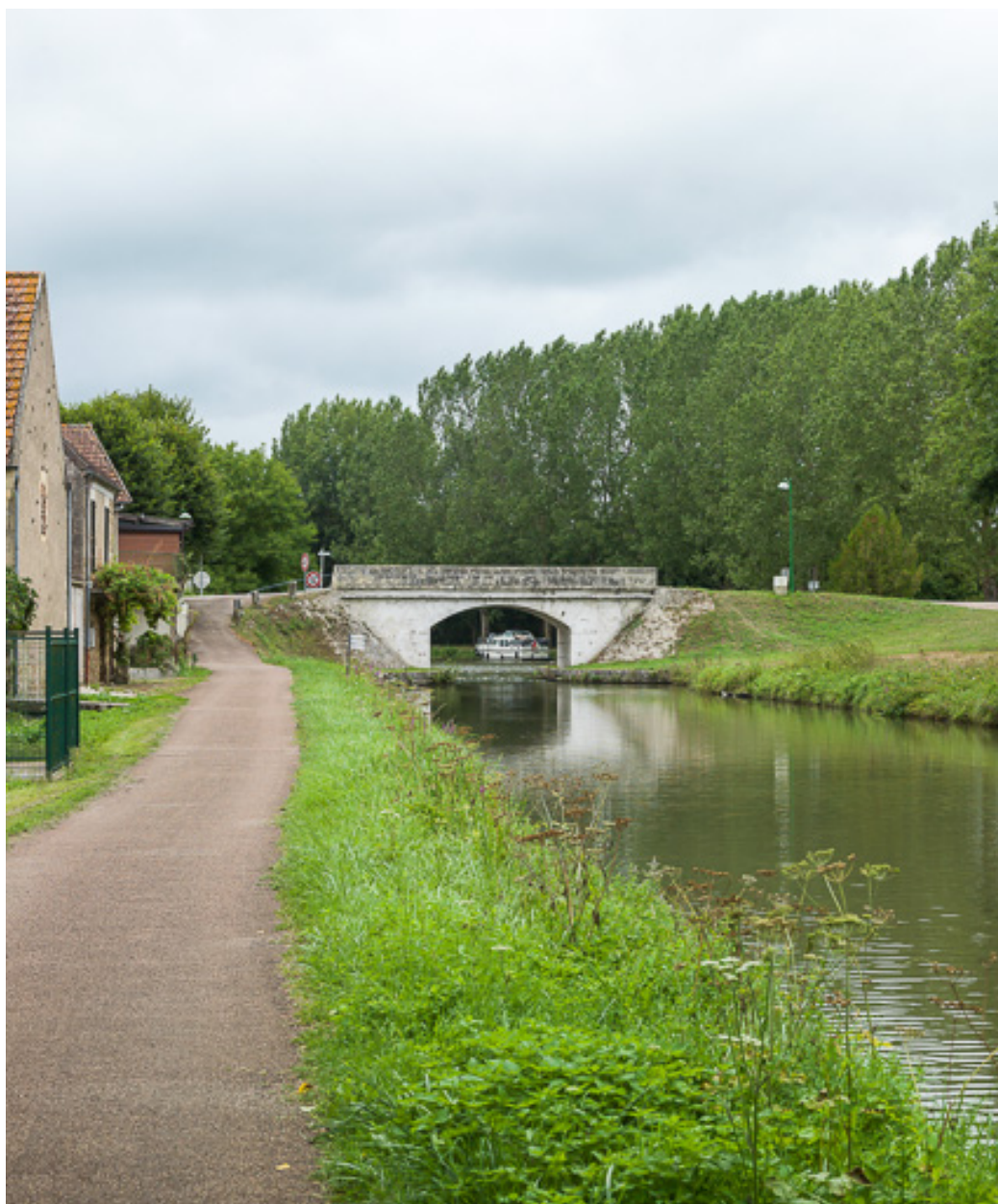
Vue d'ensemble du site et du pont.
