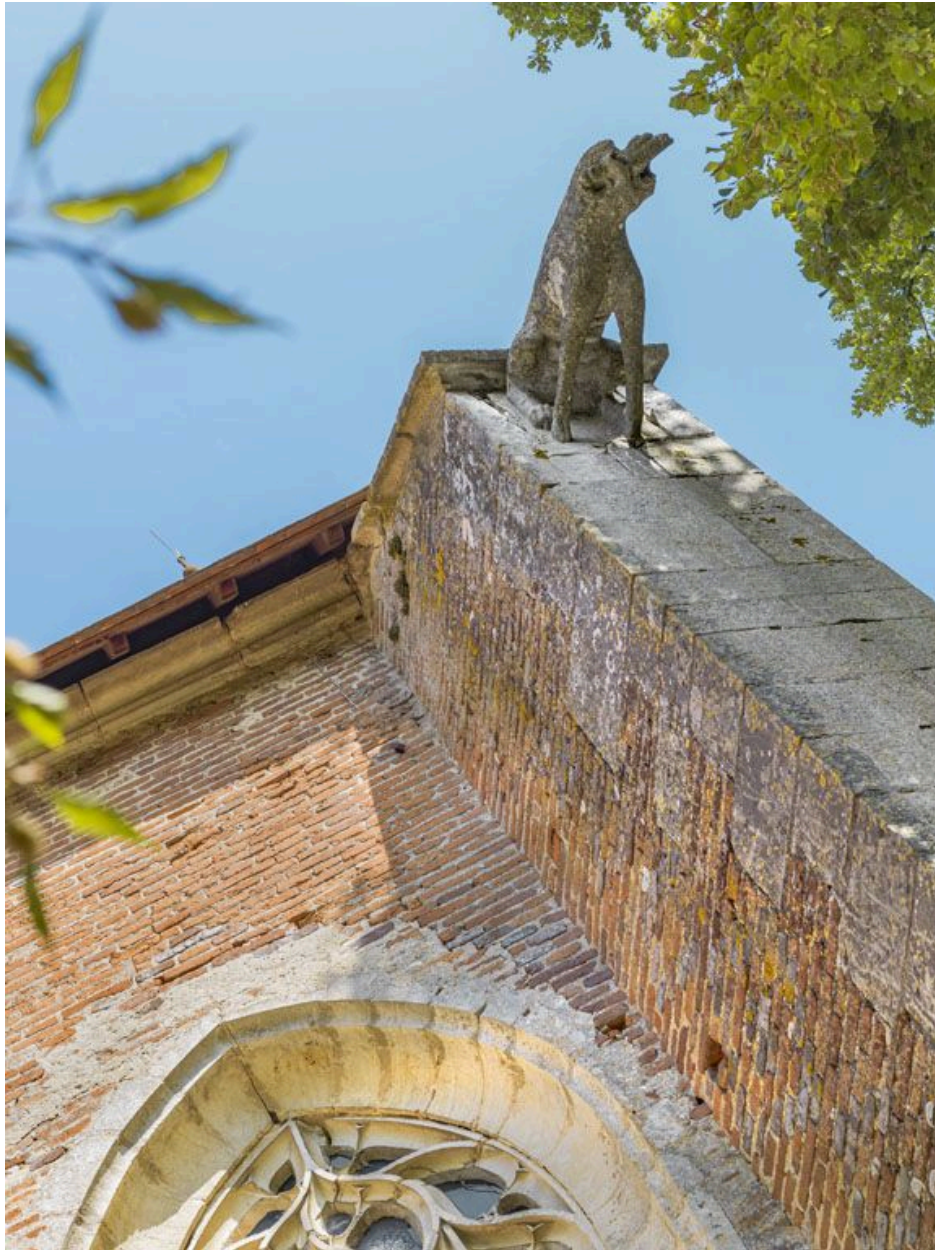
Gargouille sur le contrefort droit du chevet.
