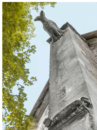
Gargouille sur un contrefort du chevet.
