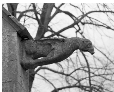
Gargouille sur le contrefort droit de la chapelle droite.
