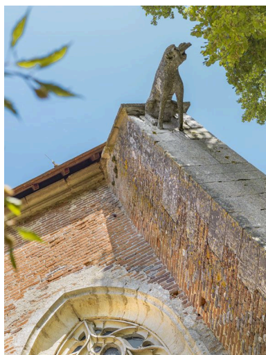
Gargouille sur le contrefort droit du chevet.
