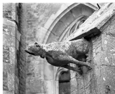
Gargouille sur le contrefort gauche de la chapelle droite.
