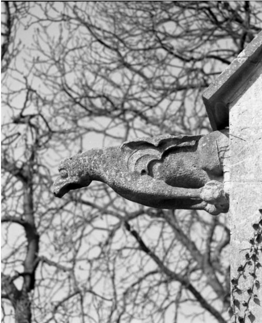
Gargouille sur le contrefort droit de la chapelle droite.
