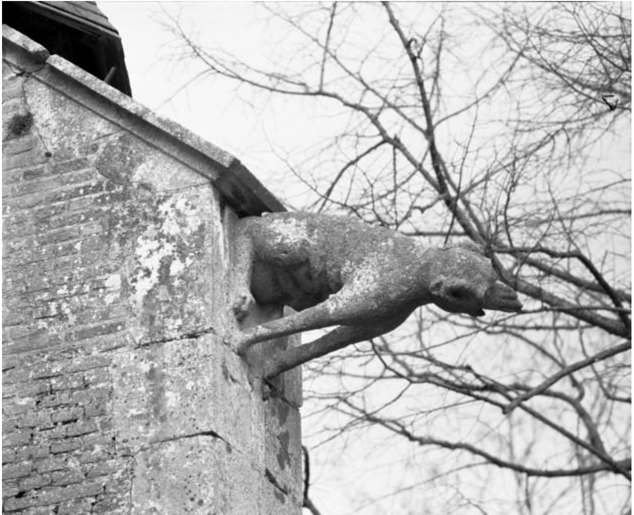
Gargouille sur le contrefort antérieur du choeur.
