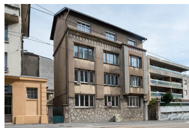
Vue de trois quarts depuis l'avenue. Phot. Jérôme Mongreville IVR43_20172501111NUC4A
