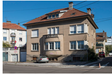
Logement patronal depuis la rue Fontaine-Ecu. Phot. Jérôme Mongreville IVR43_20172501333NUC4A
