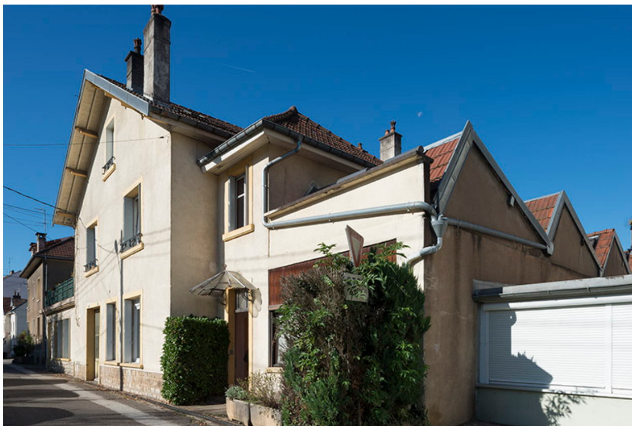
Logement et partie nord de l'atelier.
