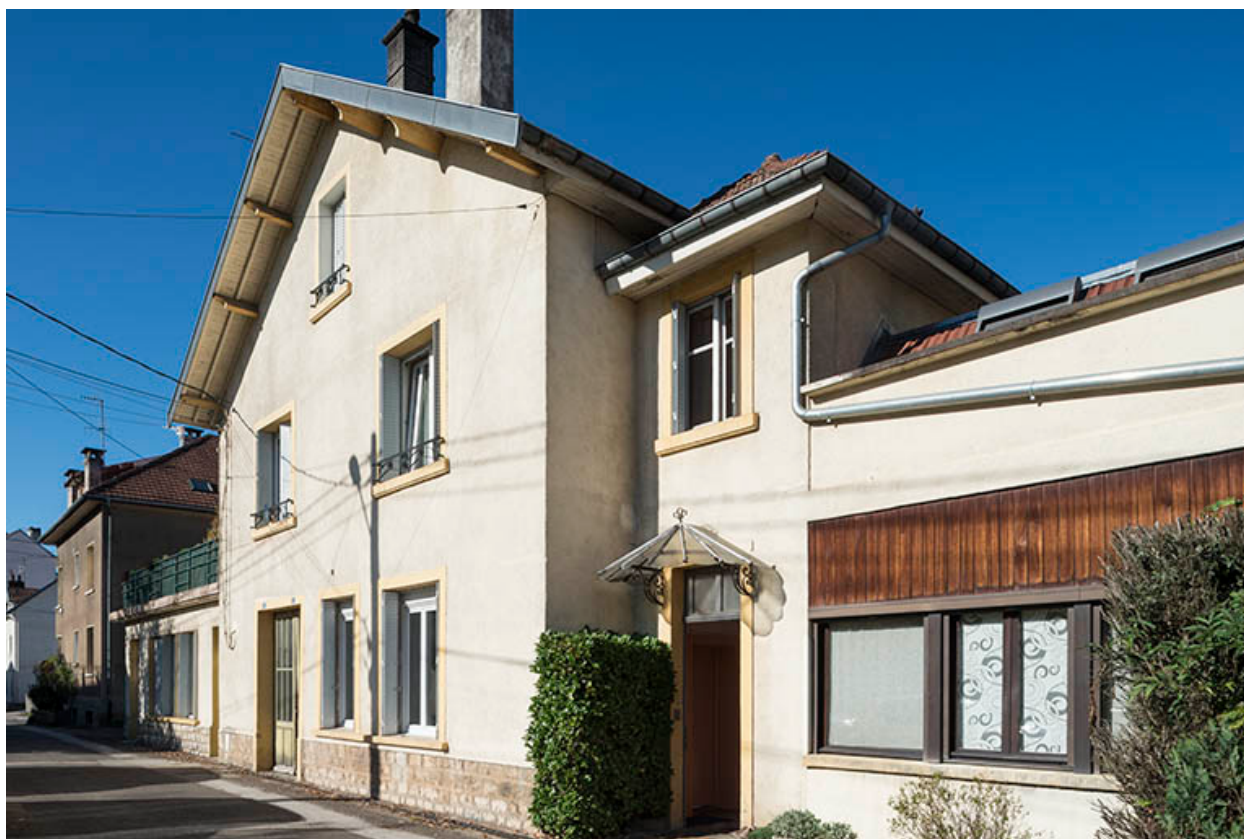
Façades sud vues de trois quarts droite.
