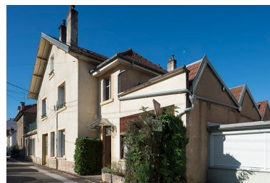
Logement et partie nord de l'atelier. Phot. Jérôme Mongreville IVR43_20172501331NUC4A
