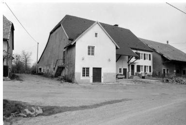
Vue de trois quarts gauche. Phot. Bernard Lardière IVR43_19829000296Z
