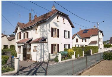
Maisons jumelées. Phot. Jérôme Mongreville IVR43_20112501390NUC4A
