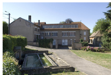
Façades postérieures. Phot. Jérôme Mongreville IVR43_20067000577NUCA
