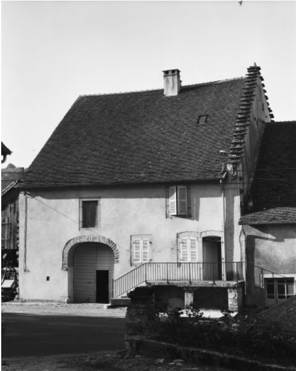
Façade antérieure vue de face.
