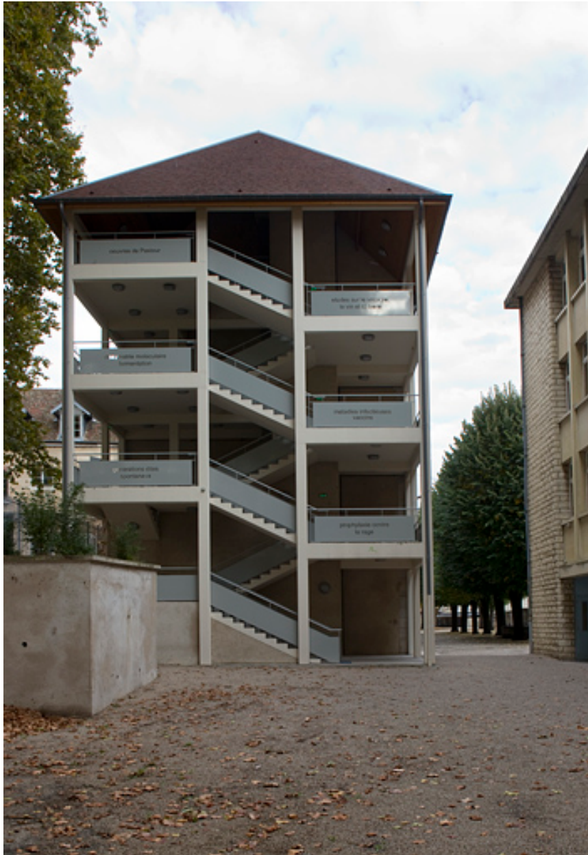
Escalier de distribution extérieur situé à l'extrémité ouest du bâtiment Ducat.
