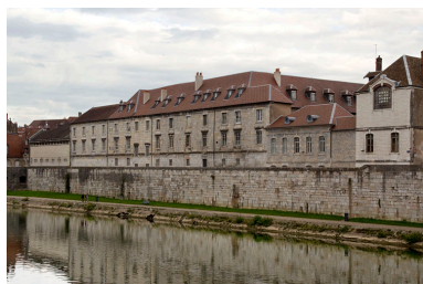
Façades postérieures des bâtiments du lycée depuis les quais. Phot. Yves Sancey IVR43_20112502565NUC2A
