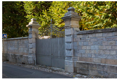
Portail situé dans le mur d'enceinte du lycée, rue Girod de Chantrans, qui permet l'accès à la cour du bâtiment Ducat.
