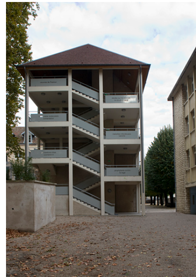
Escalier de distribution extérieur situé à l'extrémité ouest du bâtiment Ducat. Phot. Yves Sancey IVR43_20112502555NUC2A
