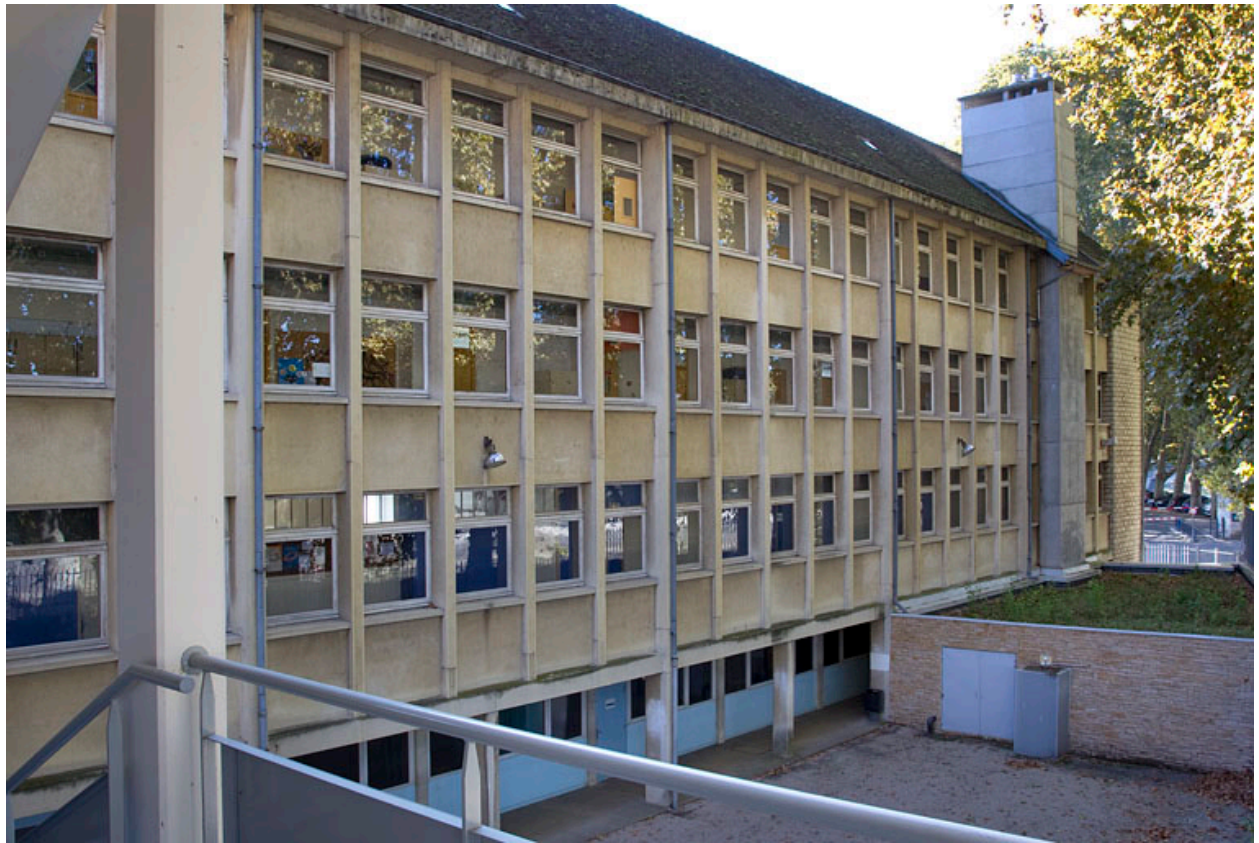
Façade antérieure du bâtiment Chamars.
