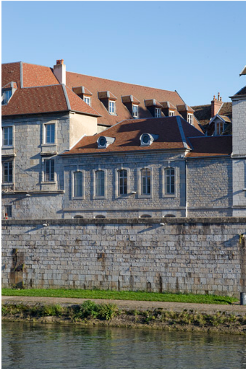
Façade postérieure de l'infirmerie.
