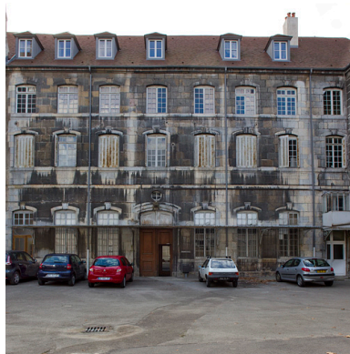
Façade latérale du bâtiment Ducat.
