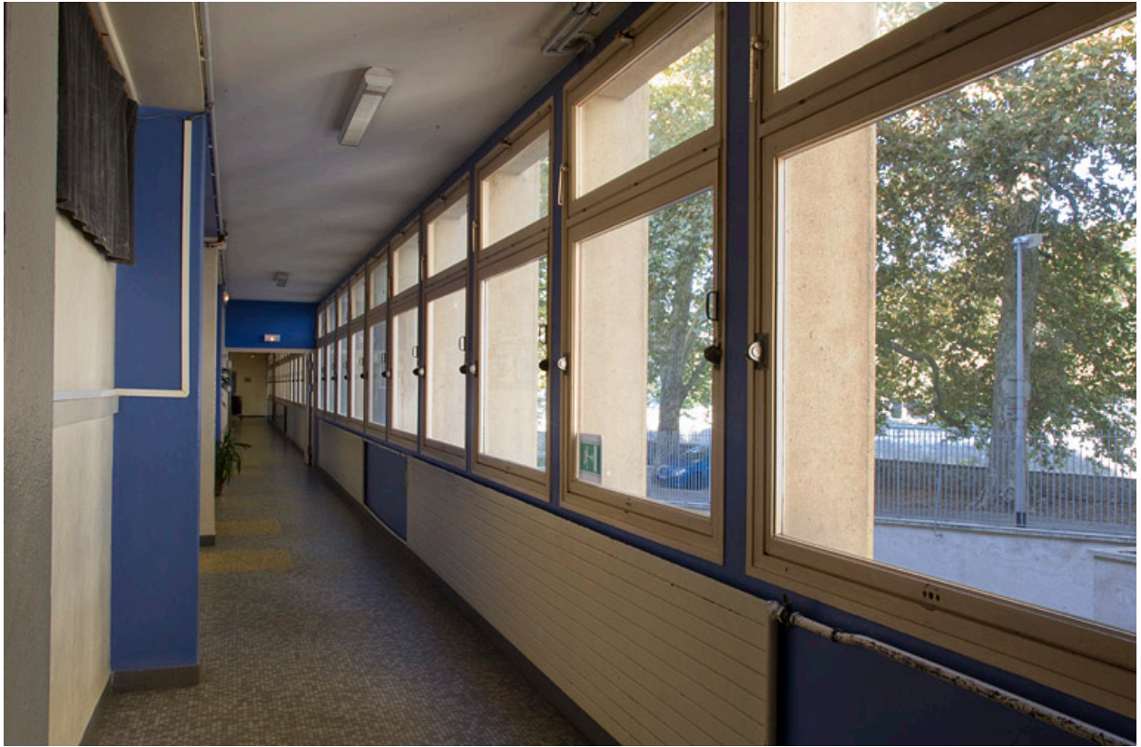
Couloir du bâtiment Chamars.
