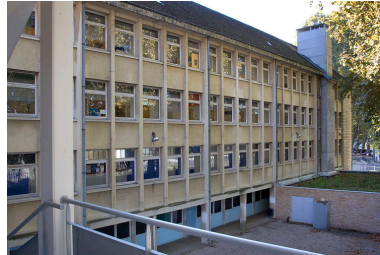
Façade antérieure du bâtiment Chamars.
