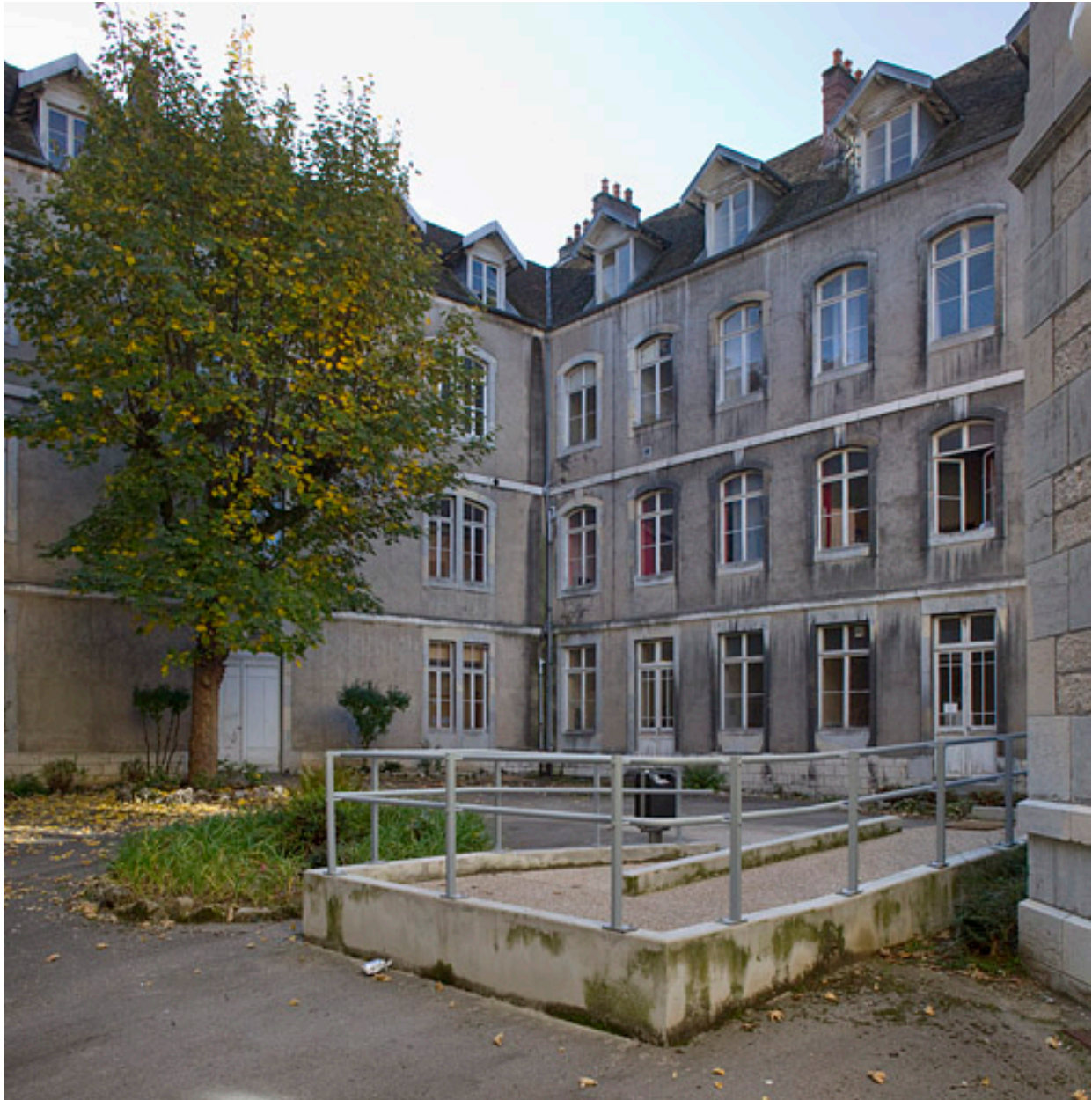
Bâtiments de la cour située dans le bâtiment Ducat.
