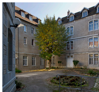
Bâtiments de la cour située dans le bâtiment Ducat. Phot. Yves Sancey IVR43_20112502557NUC2A
