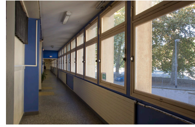
Couloir du bâtiment Chamars.
