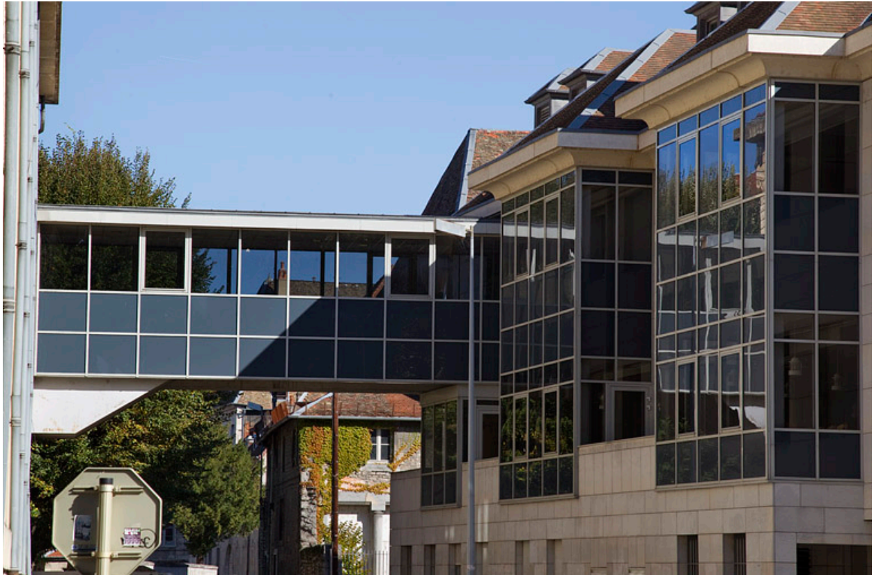
Façade latérale du bâtiment Charvet et passerelle depuis la rue Girod de Chantrans.
