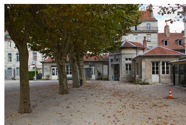
Vue de la loge du lycée formant l'angle des rues du lycée et Girod de Chantrans depuis la cour. Phot. Yves Sancey IVR43_20112502509NUC2A
