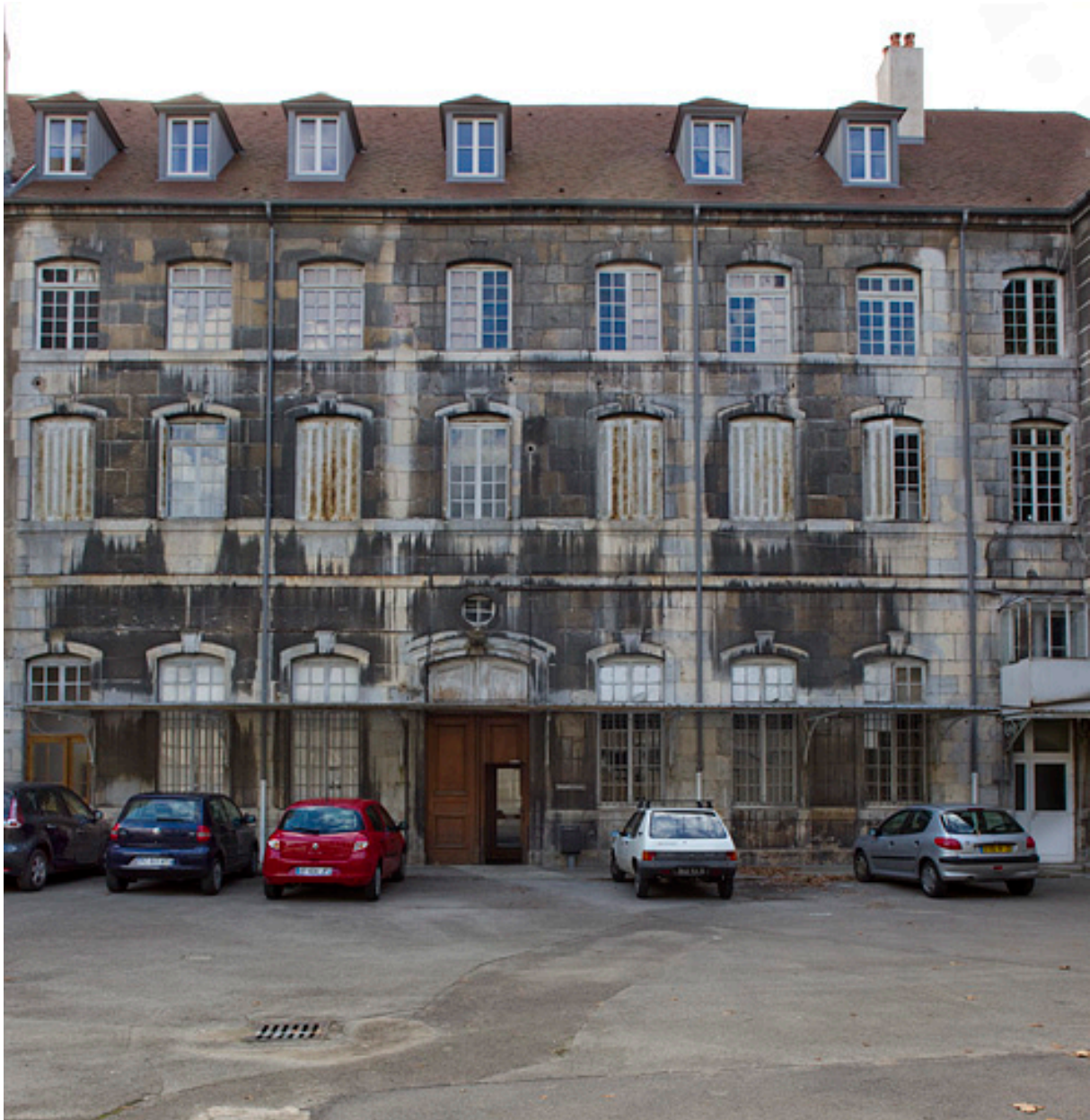
Façade latérale du bâtiment Ducat.
