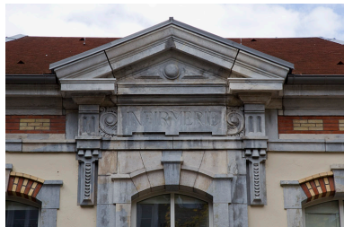
Fronton surmontant la travée centrale de l'infirmierie située dans la deuxième cour du bâtiment Ducat. Phot. Yves Sancey IVR43_20112502561NUC2A
