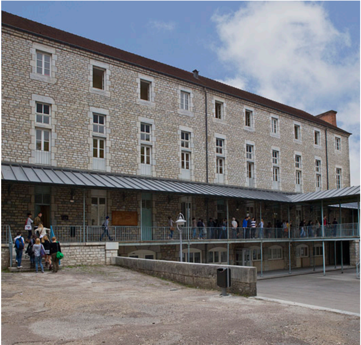
Vue générale de la façade antérieure du bâtiment Girod de Chantrans.
