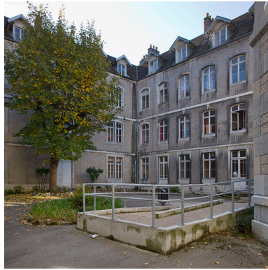
Bâtiments de la cour située dans le bâtiment Ducat. Phot. Yves Sancey IVR43_20112502558NUC2A
