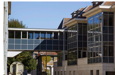
Façade latérale du bâtiment Charvet et passerelle depuis la rue Girod de Chantrans.
