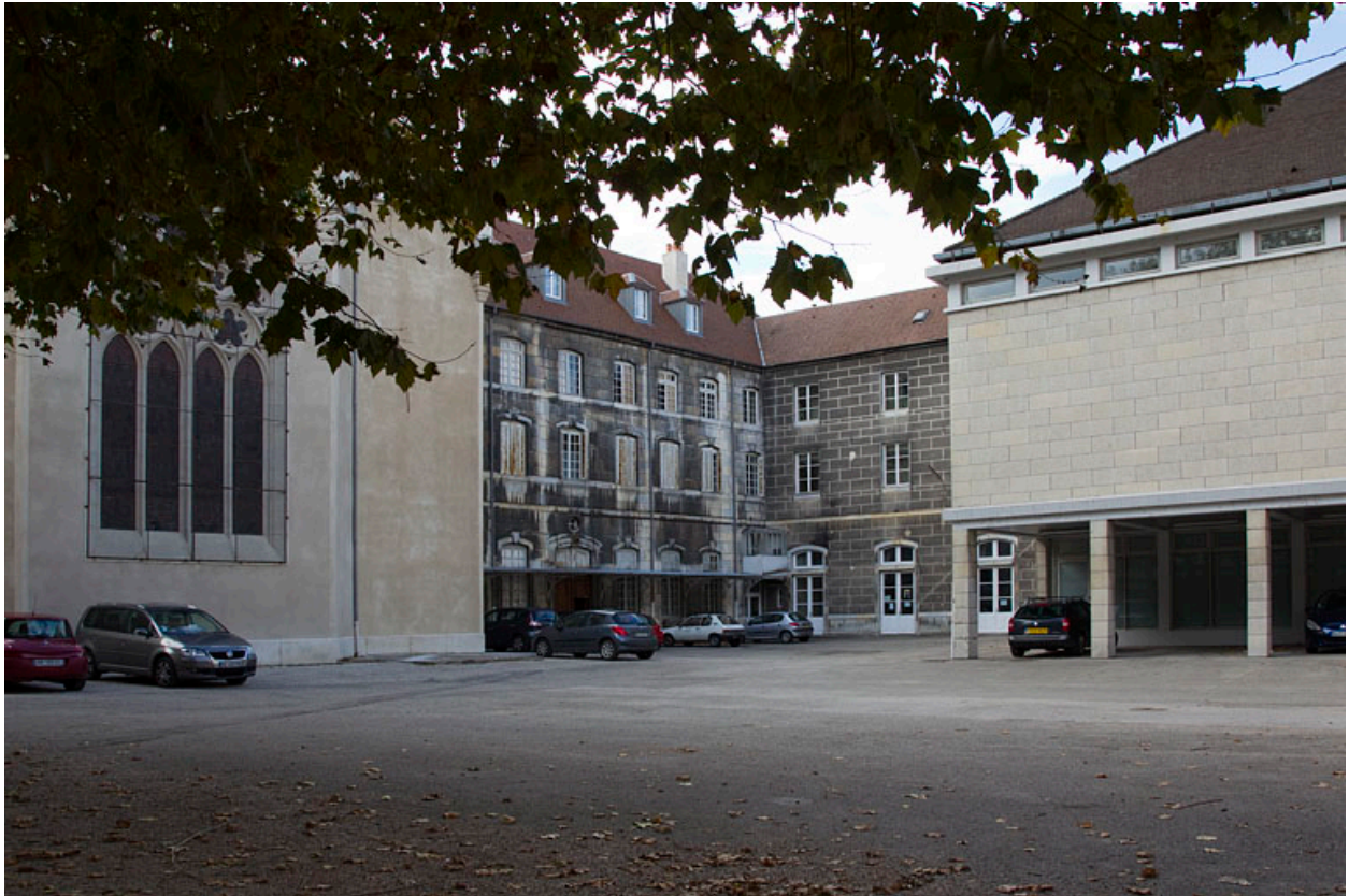
Vue générale de la chapelle, des bâtiments Ducat et Vauban ainsi que du gymnase depuis la cour du lycée.
