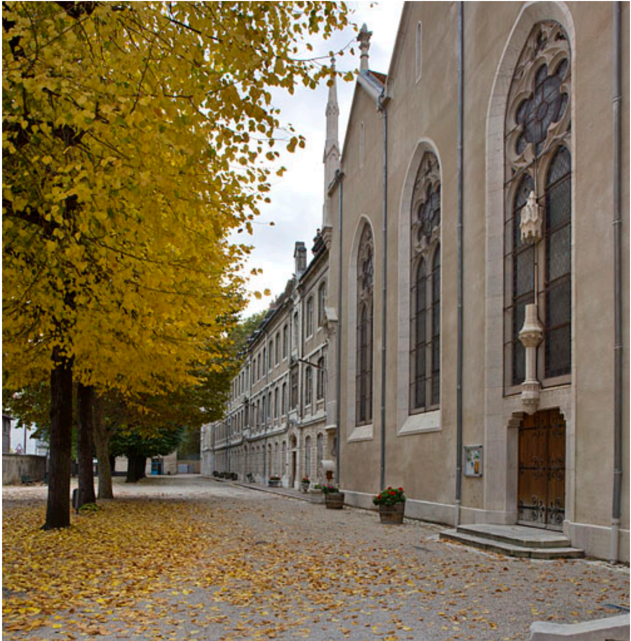
Vue générale de la chapelle prolongeant le bâtiment Ducat.
