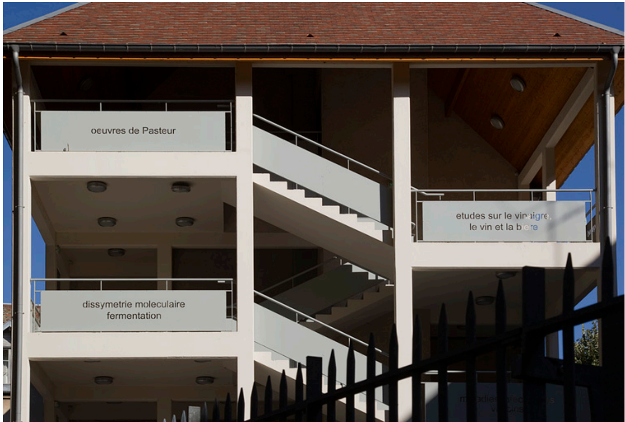
Détail de l'escalier de distribution extérieur situé à l'extrémité ouest du bâtiment Ducat.
