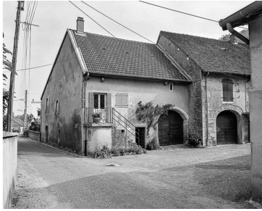
Façades antérieures et latérale gauche.
