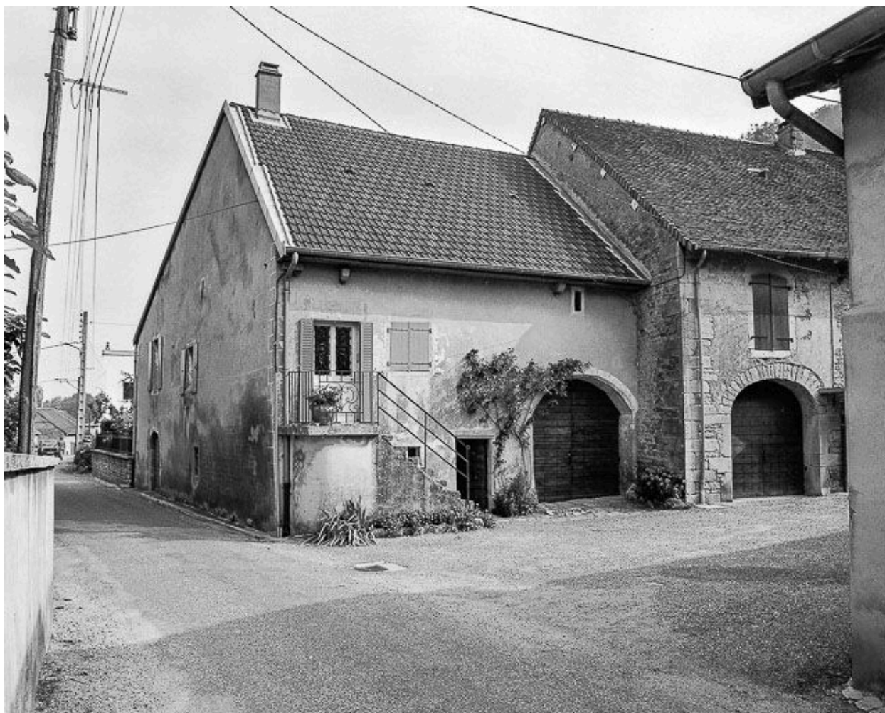
Façades antérieures et latérale gauche.
