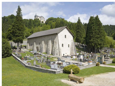
Vue générale depuis le sud-ouest. Phot. Jérôme Mongreville IVR43_20082501130NUC2A
