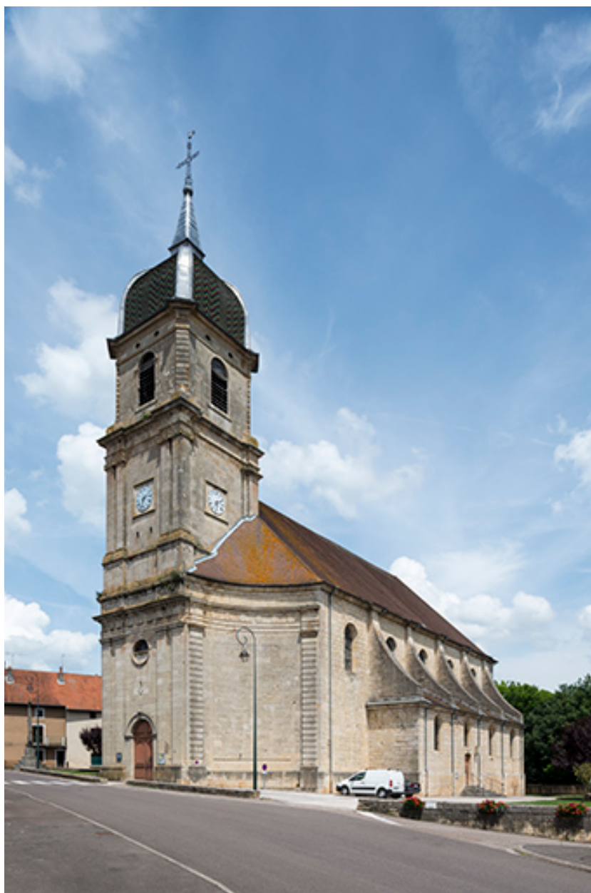
Vue d'ensemble depuis la rue de l'Église.
