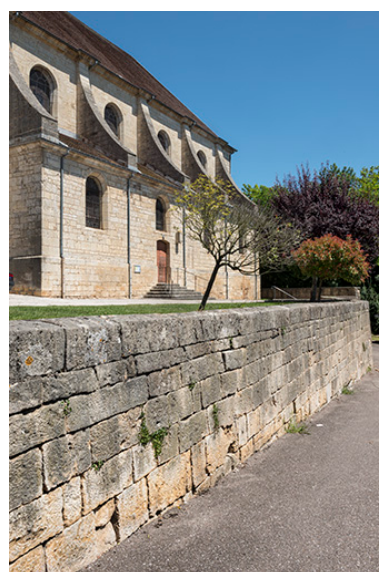
Flanc sud, mur de l'ancien cimetière. Phot. Jérôme Mongreville IVR43_20187000548NUC4A
