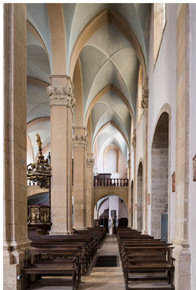
Bas-côté nord, en direction de la tribune. Phot. Jérôme Mongreville IVR43_20187000555NUC4A
