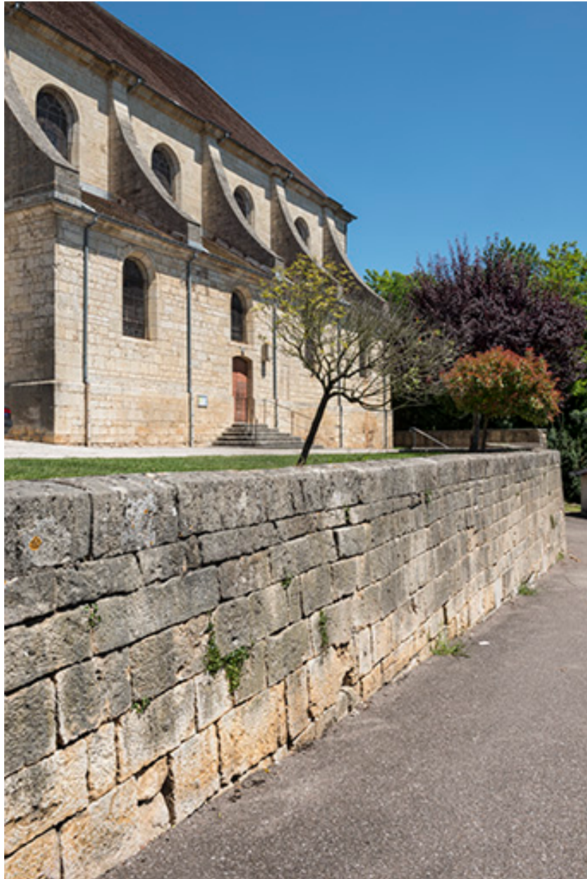
Flanc sud, mur de l'ancien cimetière.
