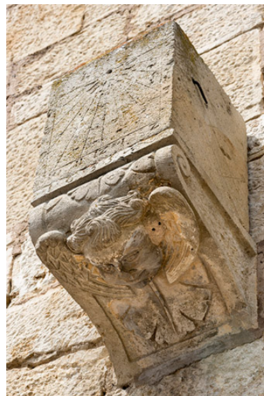
Cadran solaire sur console datée de 1655. Phot. Jérôme Mongreville IVR43_20187000540NUC4A
