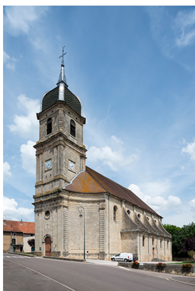
Vue d'ensemble depuis la rue de l'Église. Phot. Jérôme Mongreville IVR43_20187000536NUC4A
