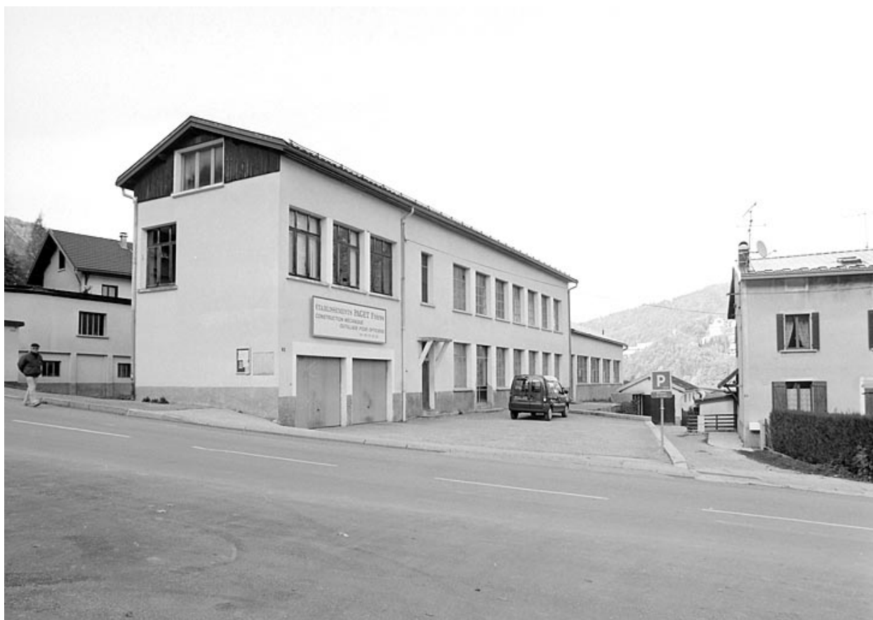
Vue d'ensemble depuis le sud : élévation antérieure.
