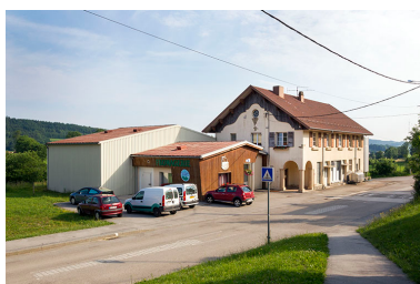
Nouvelle fromagerie : vue d'ensemble, depuis le sud. Phot. Yves Sancey IVR43_20132501454NUC2A
