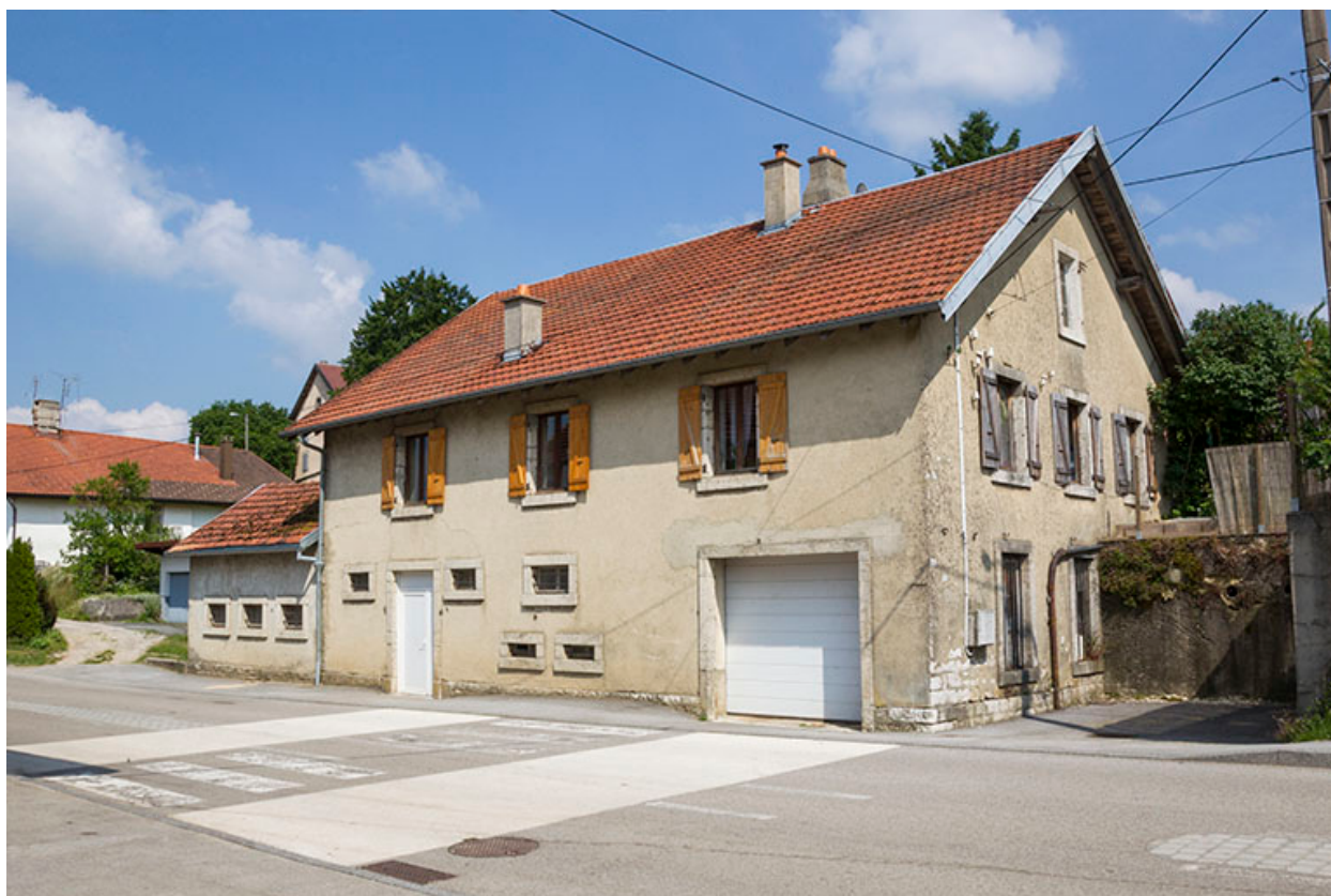
Ancienne fromagerie, de trois quarts droite.
