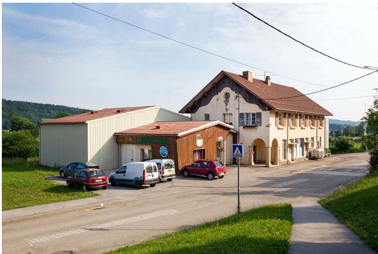
Nouvelle fromagerie : vue d'ensemble, depuis le sud.
