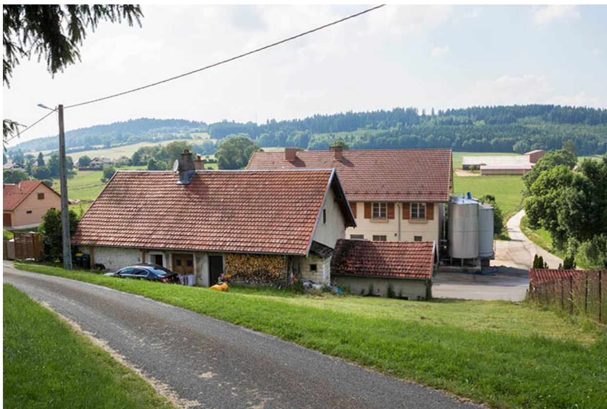
Ancienne fromagerie : façade postérieure (vue du nord-est).
