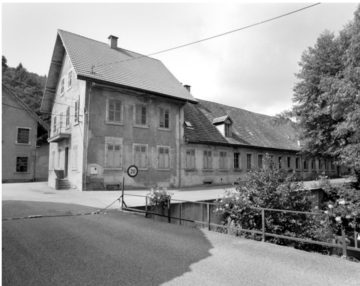
Bureaux et conciergerie depuis l'entrée.
