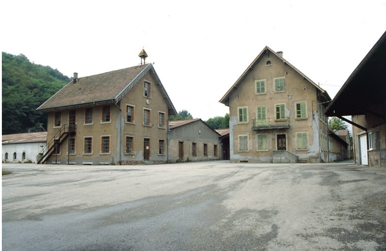
Laboratoire, bureaux et conciergerie depuis le sud.
