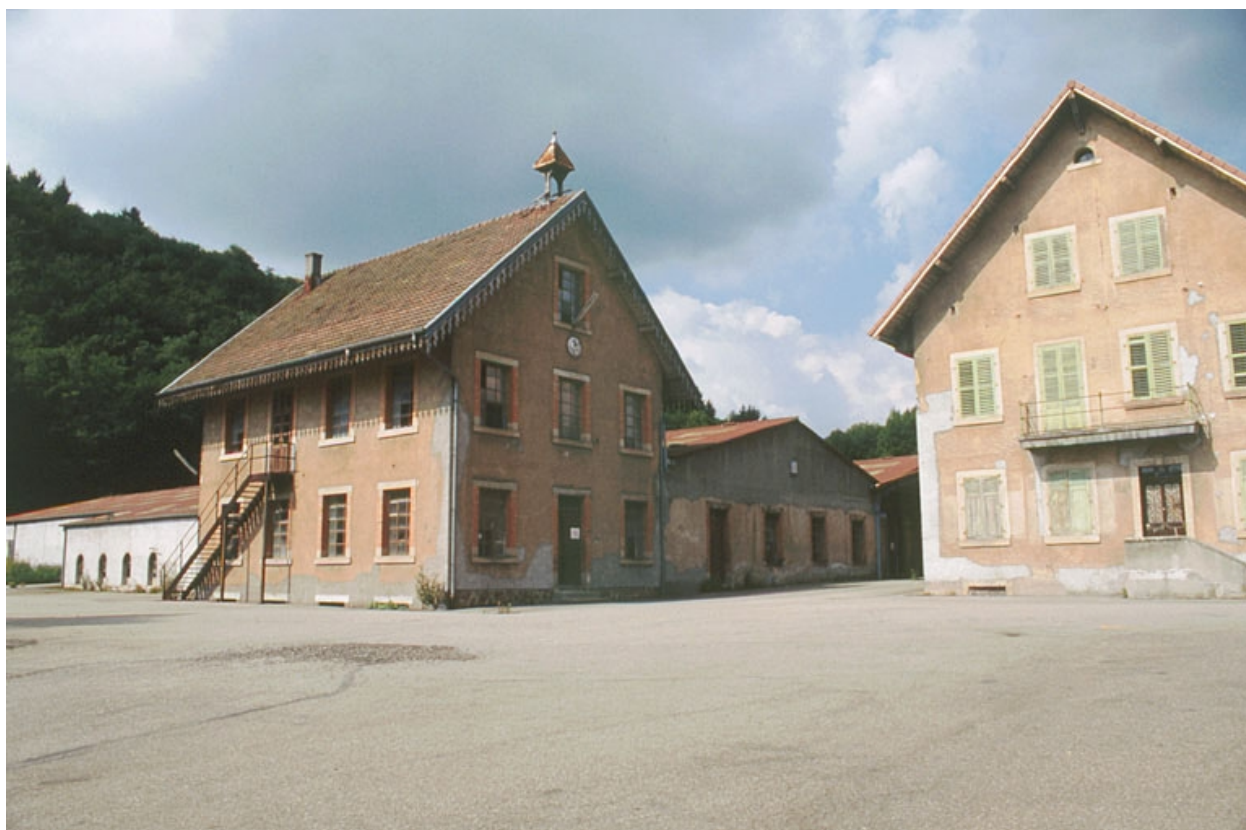
Bâtiments du tissage depuis le sud-est.
