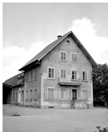
Bureaux et conciergerie. Phot. Yves Sancey IVR43_19999000004X
