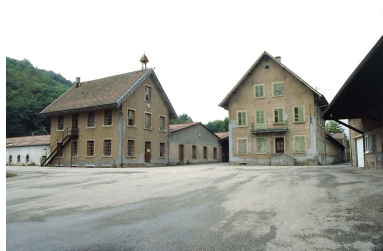
Laboratoire, bureaux et conciergerie depuis le sud. Phot. Yves Sancey IVR43_19999000008ZA
