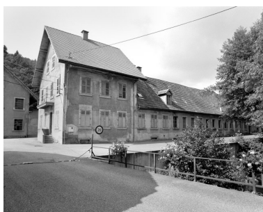
Bureaux et conciergerie depuis l'entrée. Phot. Yves Sancey IVR43_19999000003X
