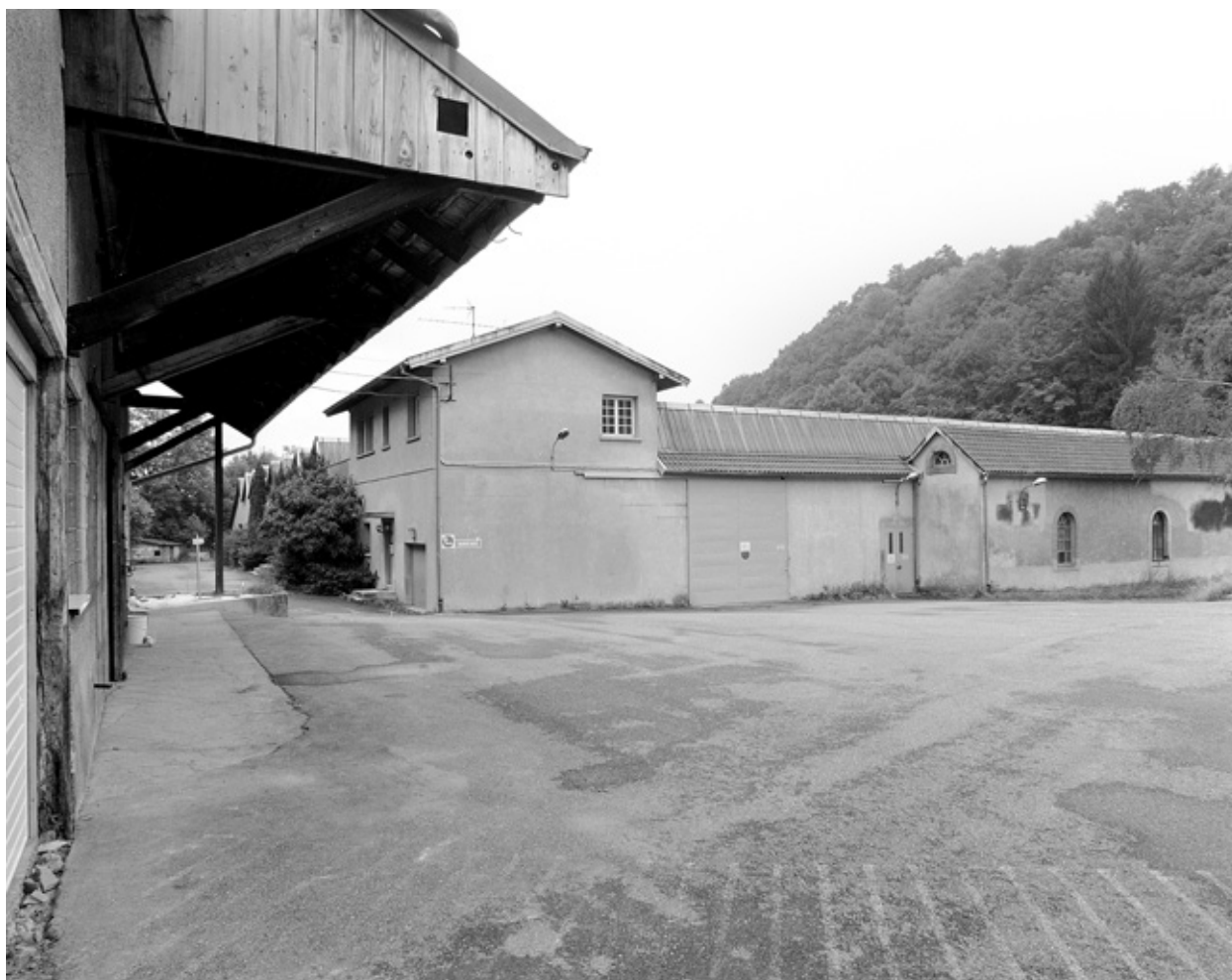
Bâtiments de la filature depuis le nord.
