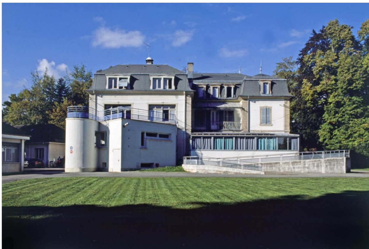
Façade postérieure du logement patronal.
