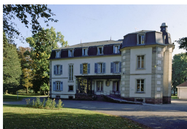
Logement patronal depuis le nord. Phot. Yves Sancey IVR43_19999000023ZA
