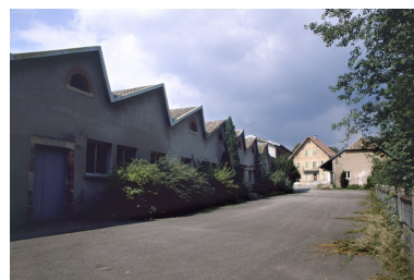
Sheds de l'atelier de filature. Phot. Yves Sancey IVR43_19999000019ZA
