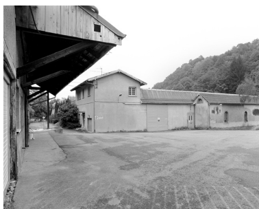
Bâtiments de la filature depuis le nord. Phot. Yves Sancey IVR43_19999000017X
