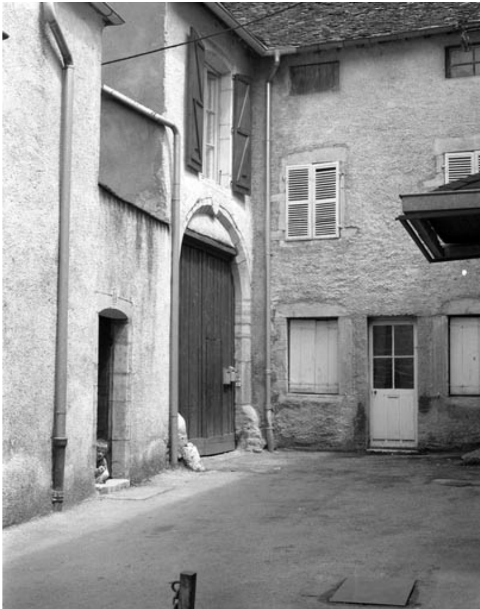
Façade latérale droite : la porte cochère.
