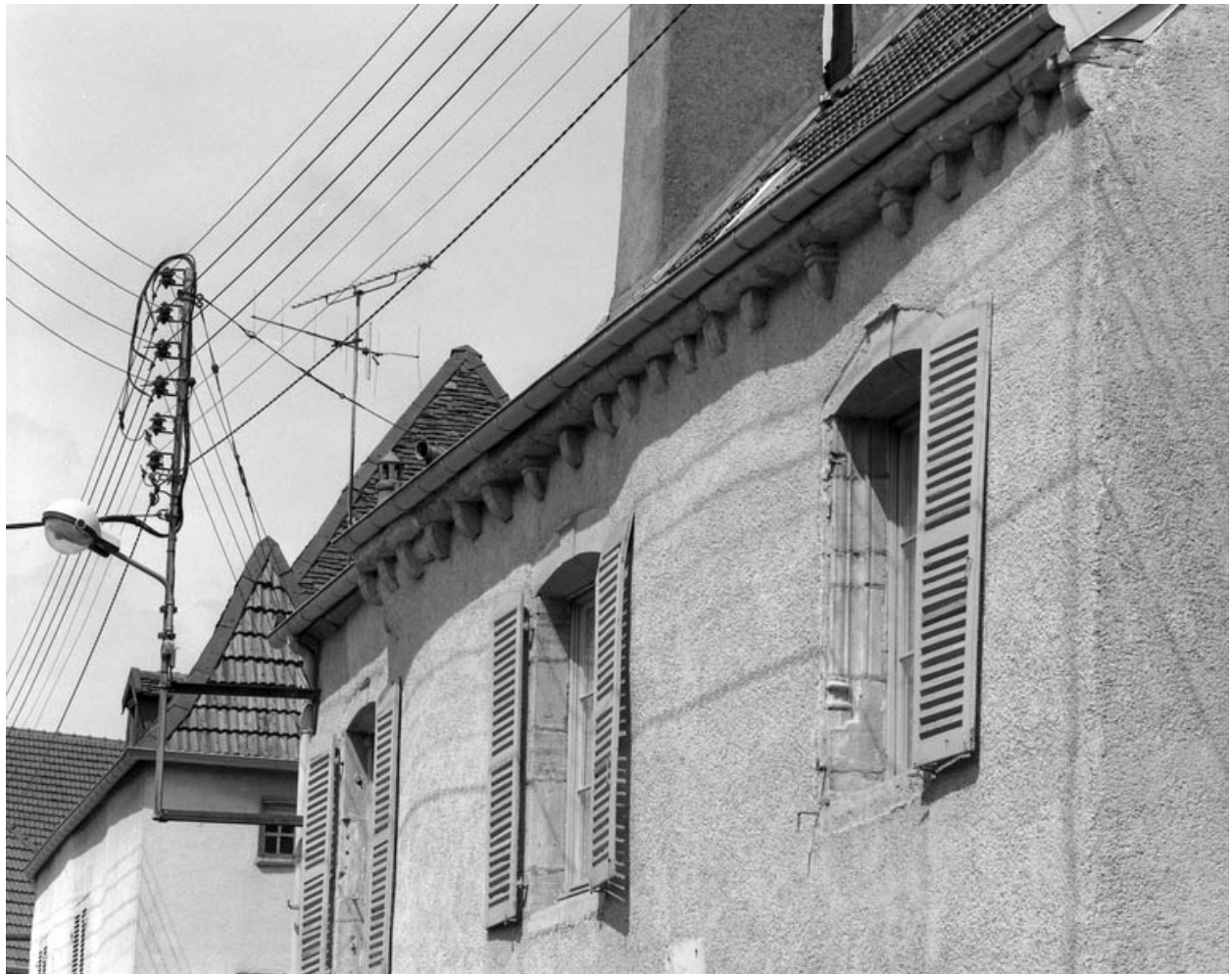
Détail : corniche de la façade antérieure.
