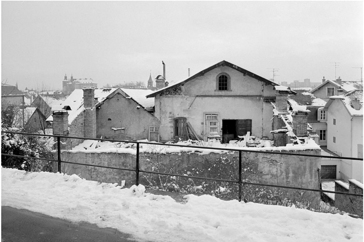
Pignons, côté nord.
