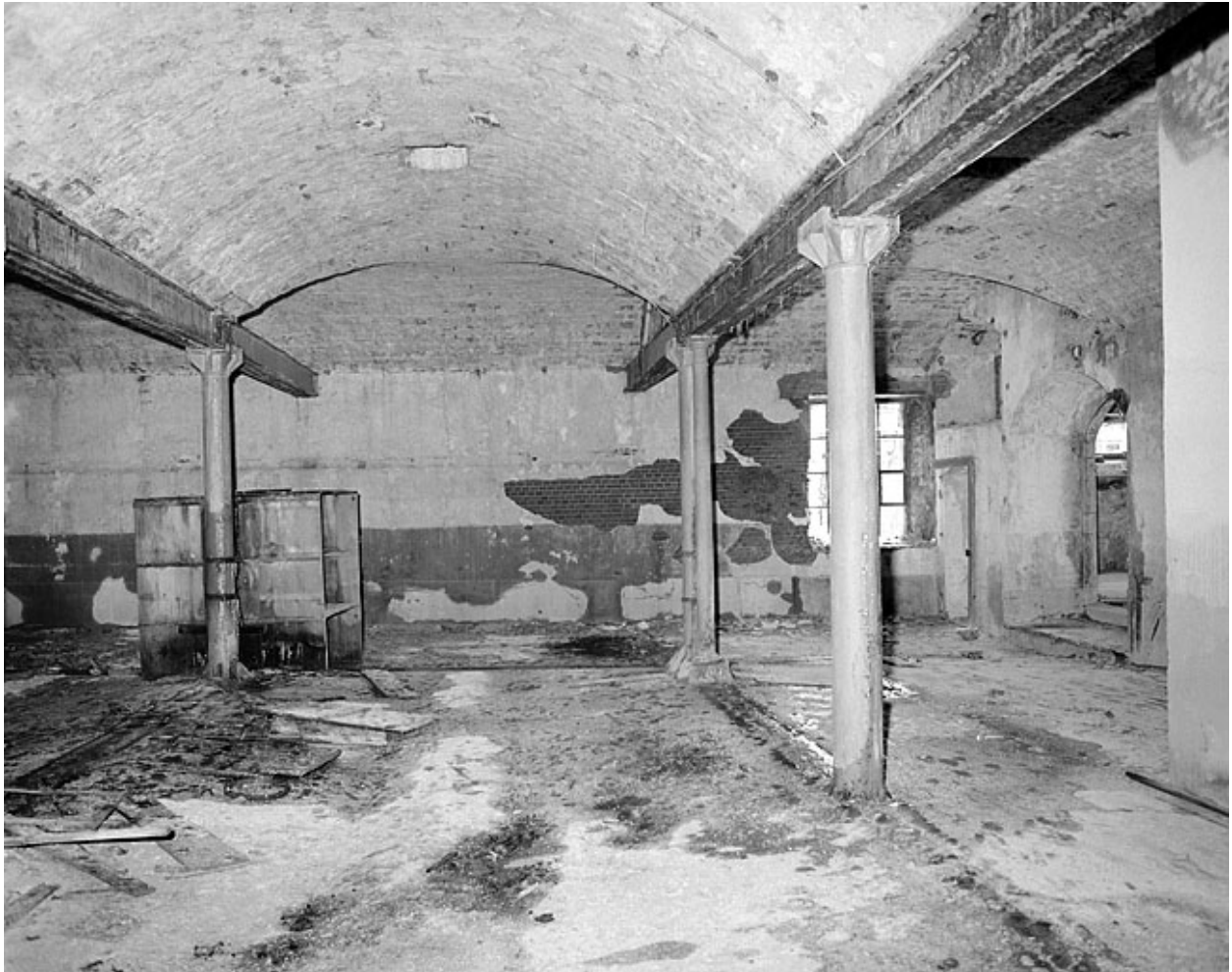
Premier étage, grande salle, côté est.
