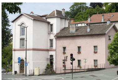
Bâtiments administratifs (?). Vue depuis le sud-est. Phot. Jérôme Mongreville IVR43_20122501862NUC4A
