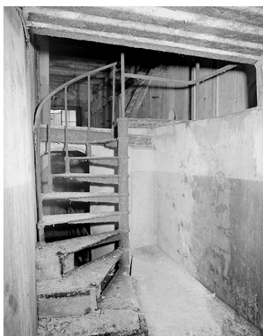
Premier étage, escalier d'accès à la salle des cuves. Phot. Yves Sancey IVR43_19862500013X
