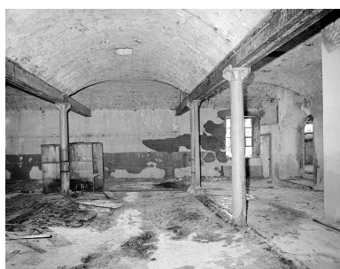
Premier étage, grande salle, côté est. Phot. Yves Sancey IVR43_19862500021X
