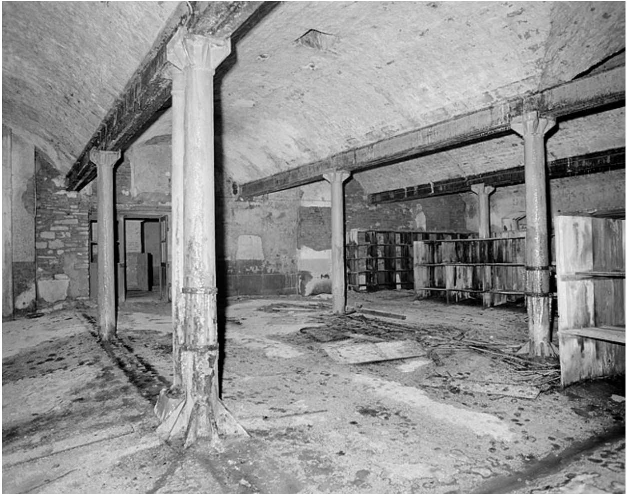
Premier étage, grande salle, côté ouest.
