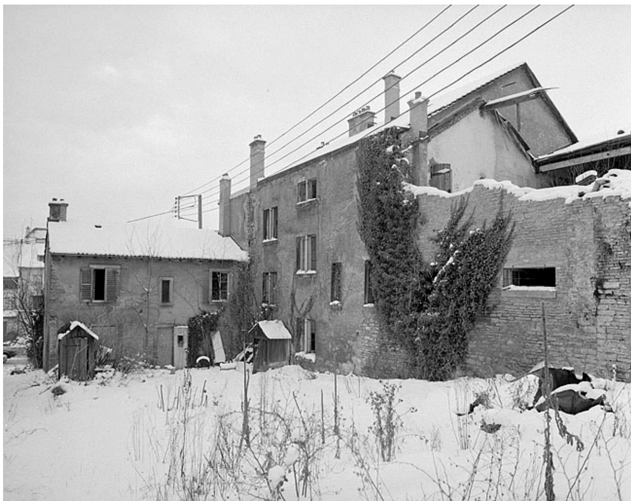
Corps de bâtiment sur rue, façade est.
