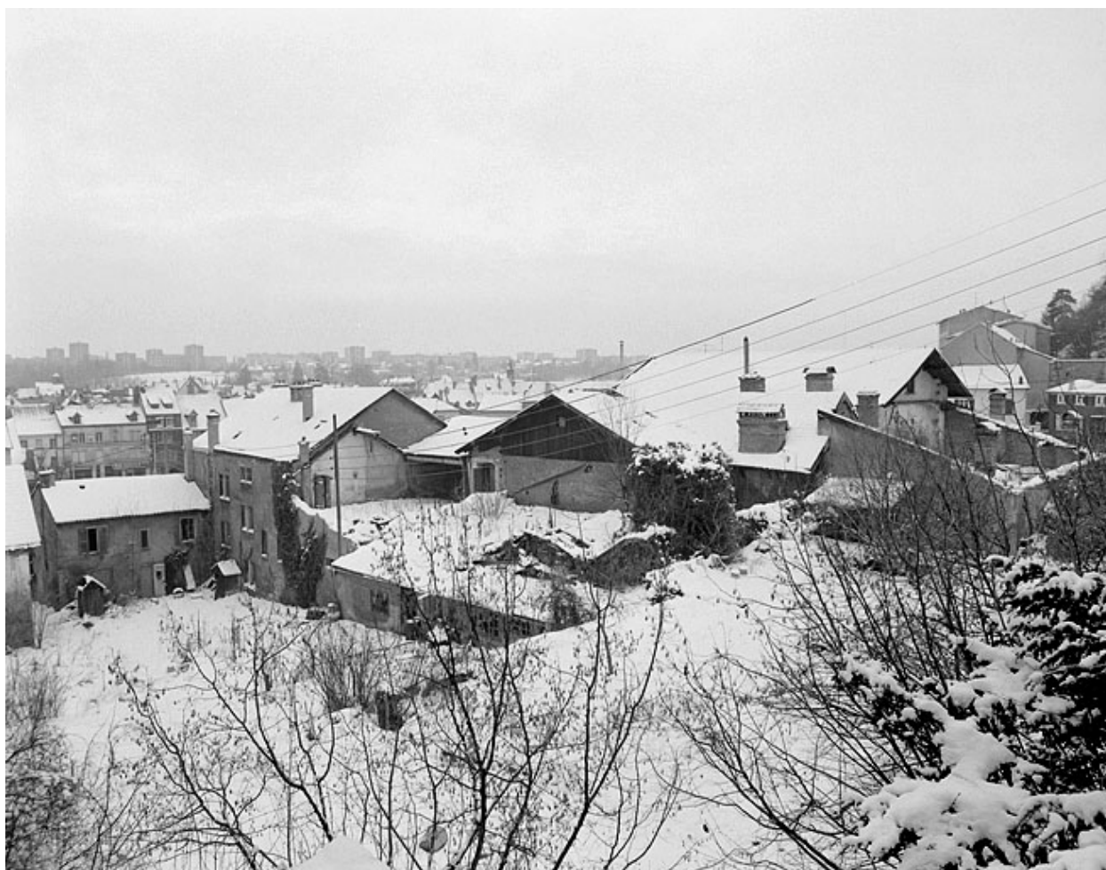
Vue d'ensemble sur l'angle nord-est.
