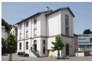
Bâtiments administratifs (?). Vue depuis le sud-ouest. Phot. Jérôme Mongreville IVR43_20122501826NUC4A
