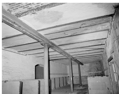
Premier étage, pièce à 2 vaisseaux. Phot. Yves Sancey IVR43_19862500015X
