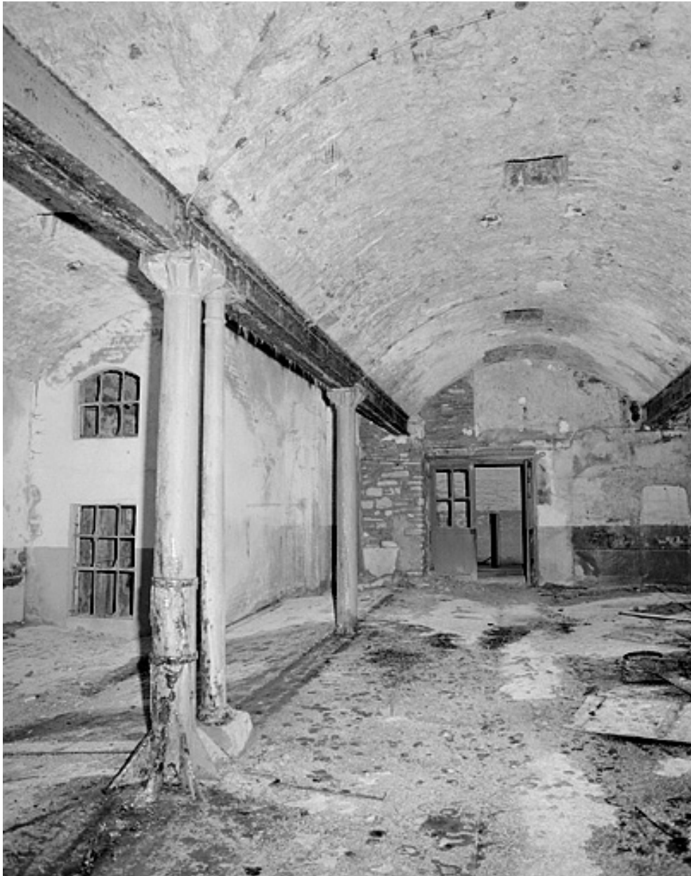
Premier étage, grande salle, côté ouest.
