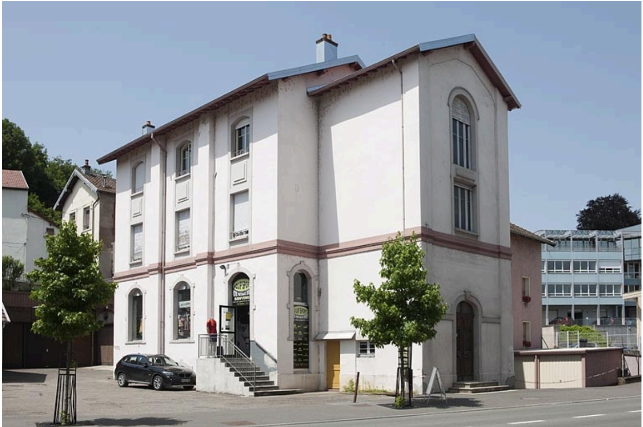
Bâtiments administratifs (?). Vue depuis le sud-ouest.
