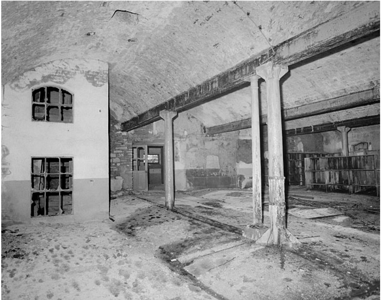
Premier étage, grande salle, côté ouest.
