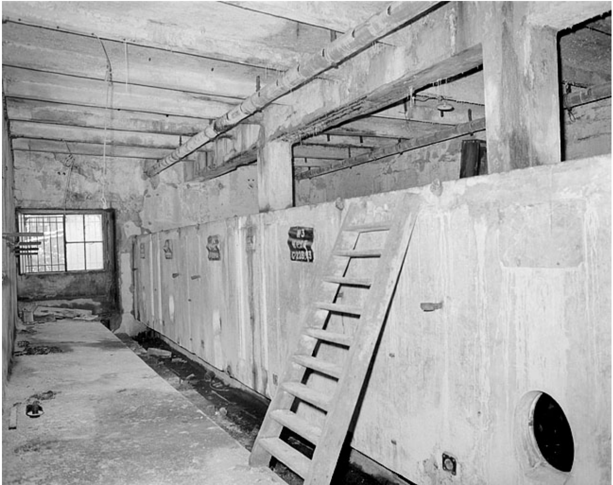
Premier étage, salle des cuves.
