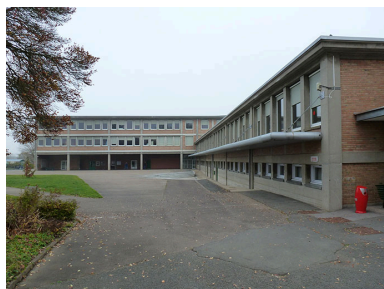
Audincourt, lycée professionnel Nelson Mandela : la cour, les façades antérieures et le préau de l'externat avant les travaux. Phot. Philippe Mairot IVR43_20142500677NUC4A
